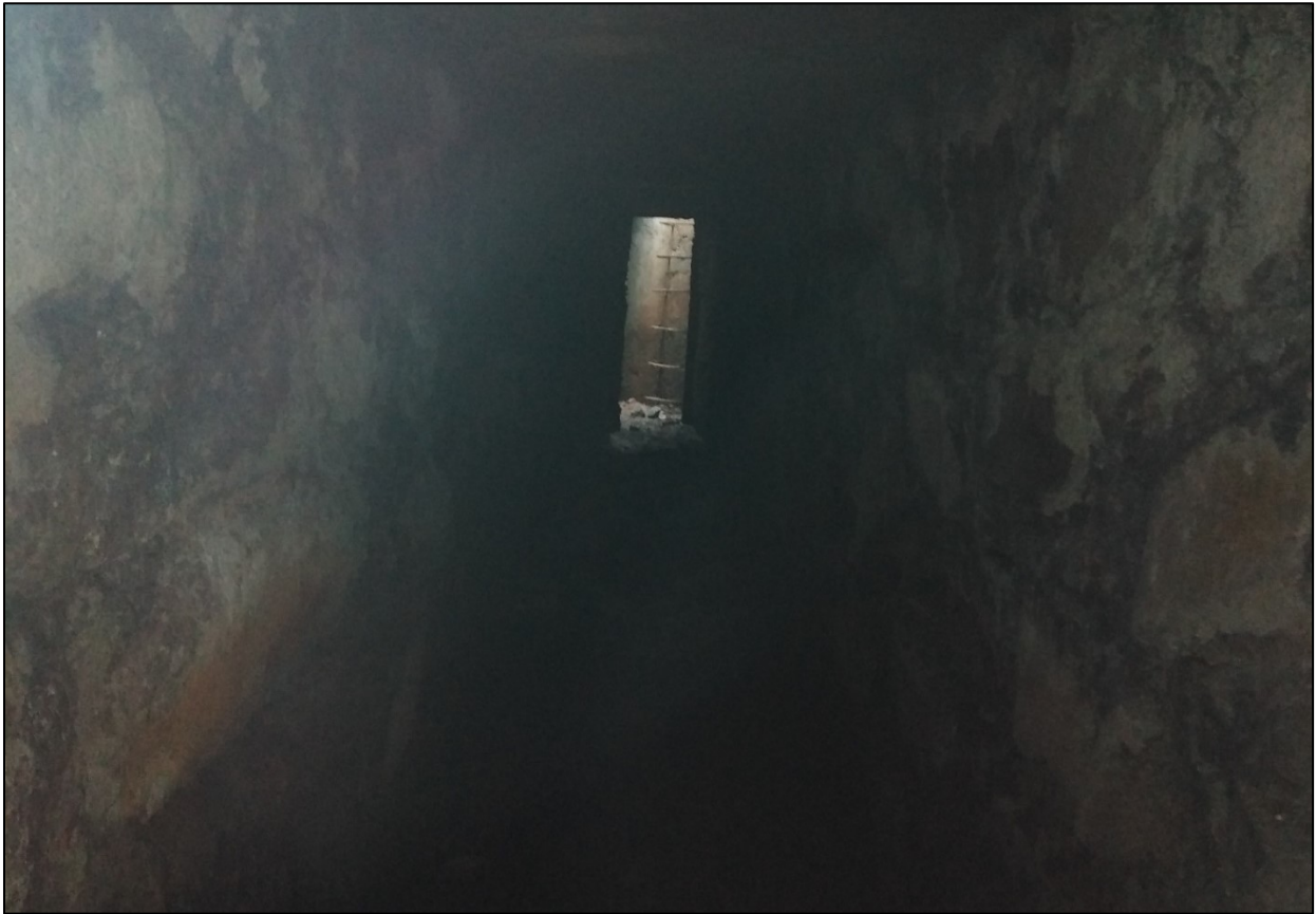
Obr. 19: Obdélníková štola. Fotka je vedena v obdélníkové části štoly před zatočením do hřbetu. Na fotce je viditelné obložení štoly a kontrolní šachta.
