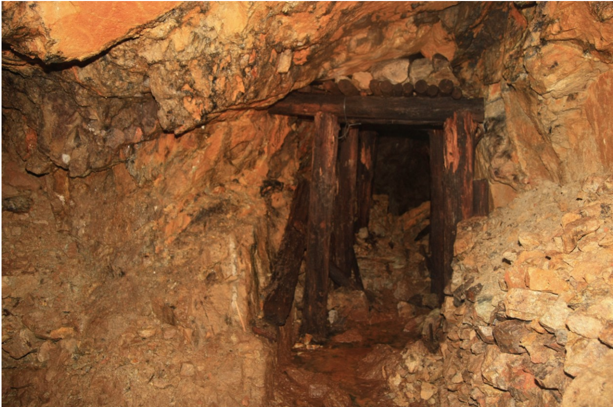
Obr. 28: Vnitřní prostor štoly Jeroným s dřevěným ostěním (Kukutsch et al., 2008).
