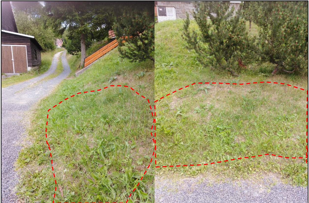
Obr. 23: Snížená oblast nad štolou při úpatí západního svahu.
