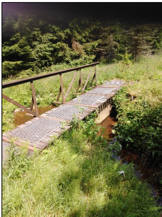
Obr. 18: Obrázek zobrazuje aktuální stav rozdělovacího zařízení nacházejícího se na okraji chatařské oblasti. Jedná se o nově zbudovaný objekt, s částečnou schopností odvádět část vody do přírodního kanálu, který je od rozdělovače dobře zřetelný, díky reliéfu a zvýšené vlhkosti v prohlubni vedoucí od rozdělovače. Pozůstatky přírodního kanálu jsou téměř zcela zasypány, zabahněny a zarostlé vegetací.
