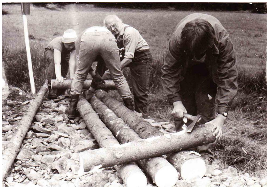
Budování naučné stezky Javorník
