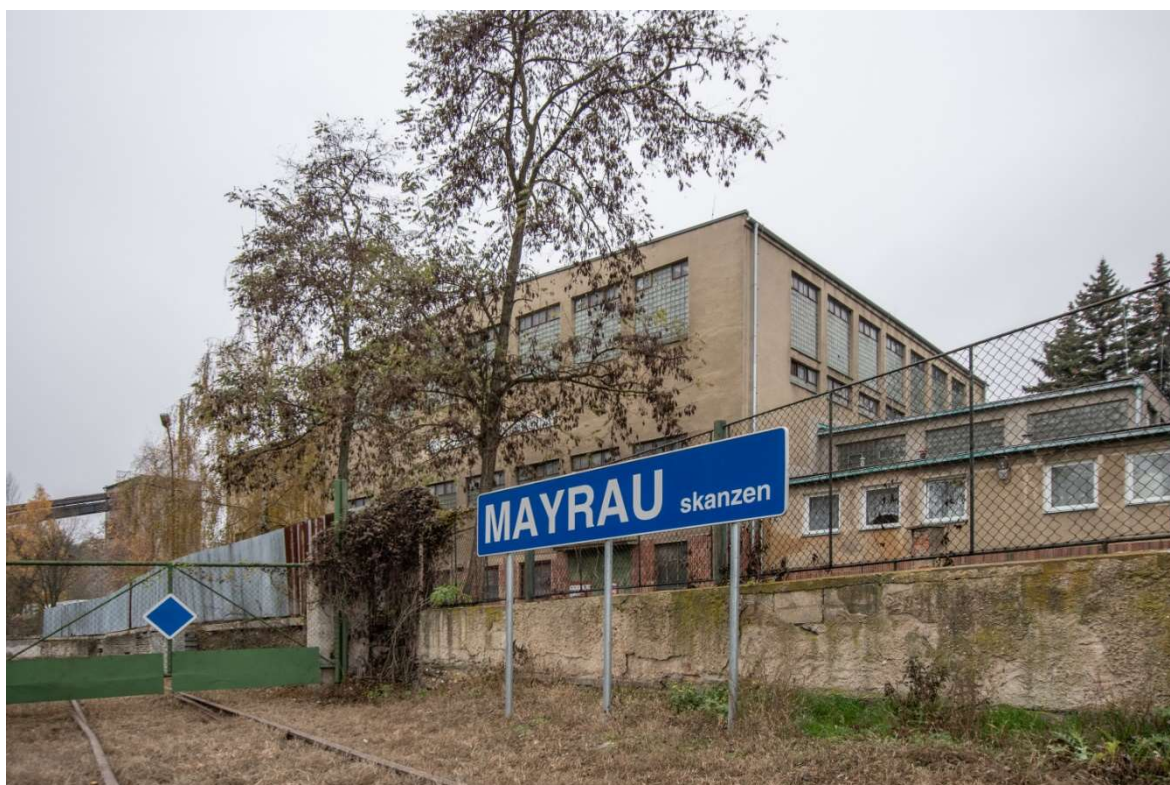
Obr. 24: Důl Mayrau, železniční zastávka sloužící provozu turistických vlaků (listopad 2020)
