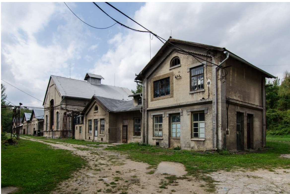
Obr. 19: Důl Mayrau, technické budovy (září 2018)
