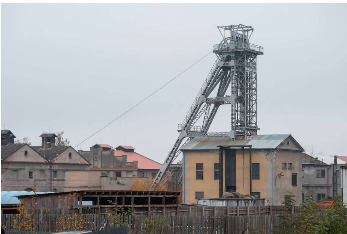
Obr. 14: Důl Schoeller, pohled z jihozápadní strany (listopad 2020)
