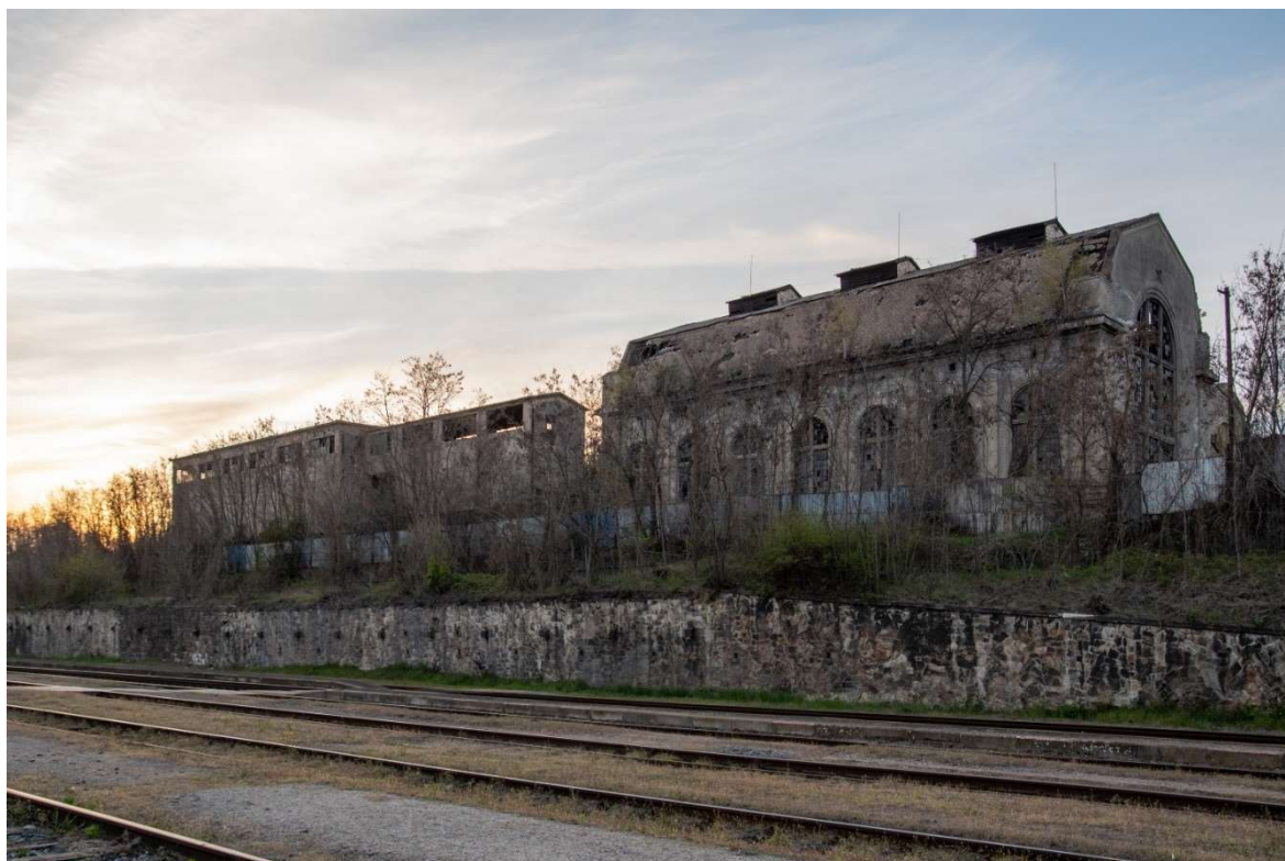
Obr. 6: Totožný pohled z nádraží Kladno-Dubí, vlevo výsypky, vpravo budova kotelny (duben 2022)
