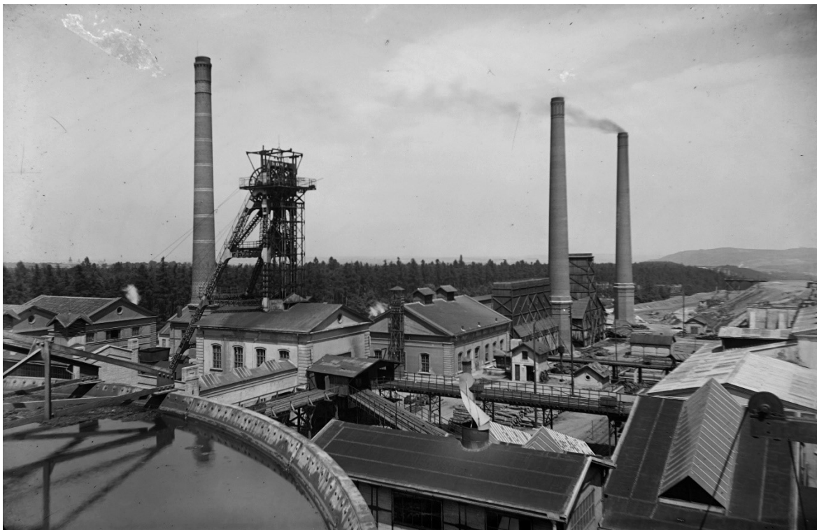
Obr. 13: Důl Schoeller, pohled z jihozápadní strany (neznámá datace)
