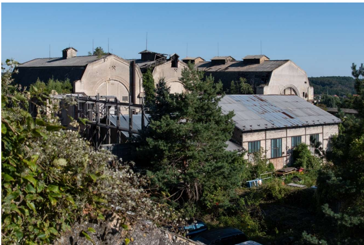
Obr. 7: Důl František Josef, pohled ze severozápadní strany, dvě spojené budovy vlevo jsou strojovny parních a těžních strojů, vpravo budova kotelny a v popředí jámová budova, na které je stále patrný otvor po těžní věži (září 2021)
