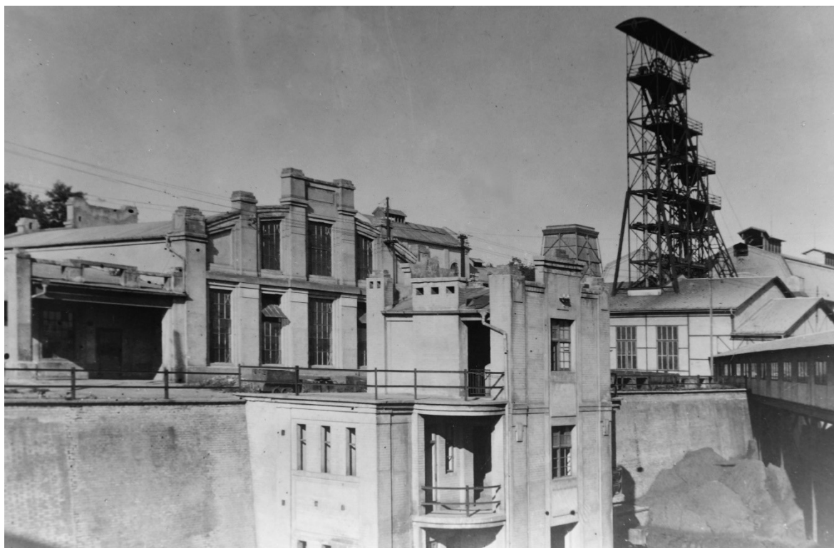
Obr. 3: Areál dolu František Josef, pohled z jižní strany (neznámá datace)
