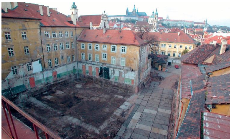
Obr. 29: Stav po demolici tiskárenské haly a po odstranění novověkých navážek. Situace těsně před zahájením archeologického výzkumu v listopadu 2003 (foto J. Hlavatý, 2003). 277
