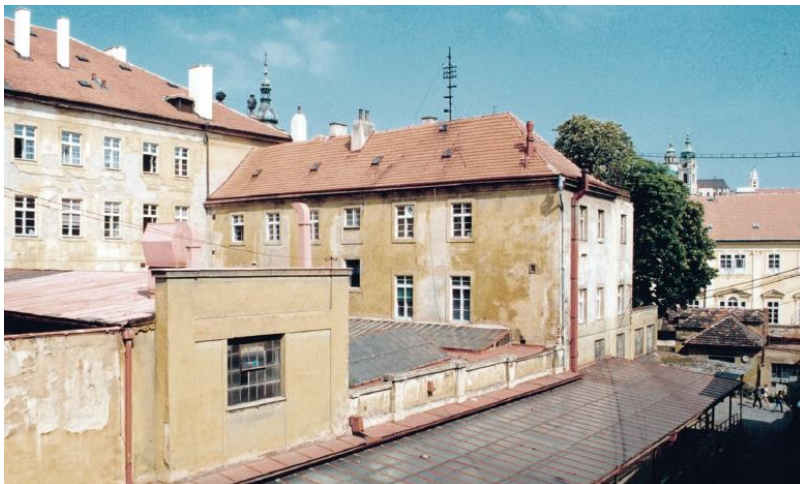
Obr. 28: Vestavěná tiskárenská hala před zbouráním (foto J. Podliska, 1997). 276
