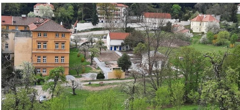
Obr. 81: Dnešní stav zahrady během rekonstrukce, foto z 28. 4. 2022 Veronika Pulcová
