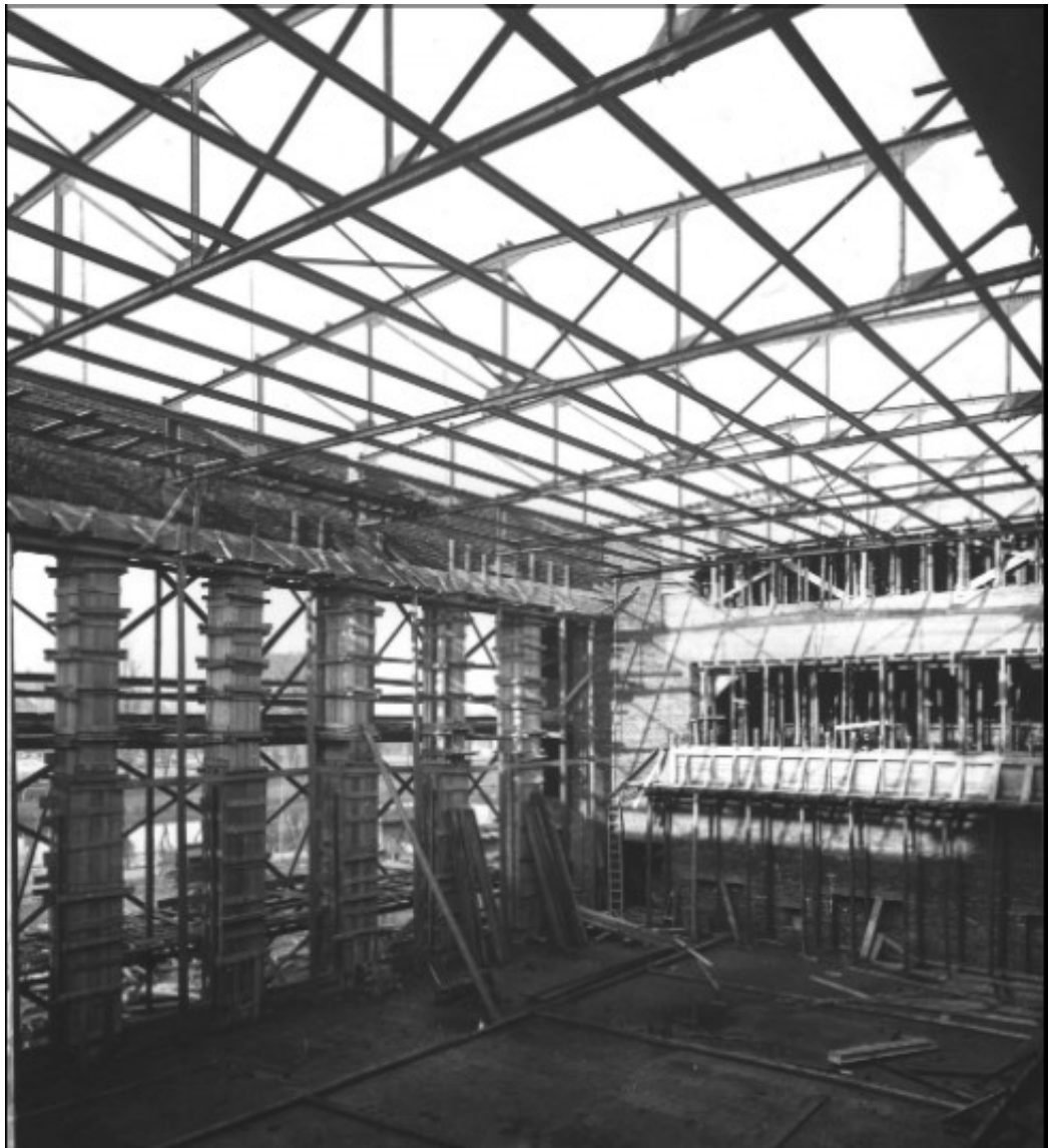
Obr. č. 10: Stavba nové sokolovny (1928-1929)
