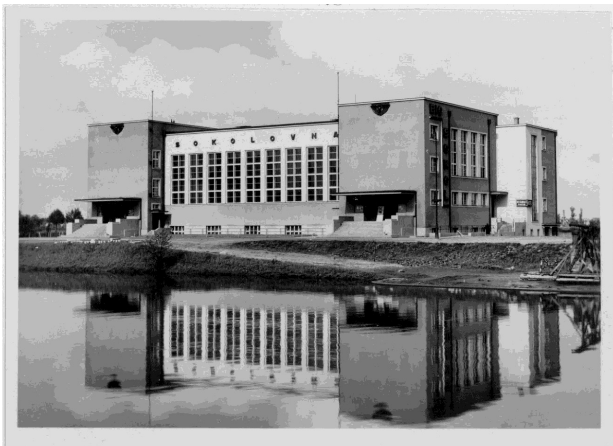
Obr. č. 9: Nově postavená sokolovna na Eliščině nábreží (1930)
