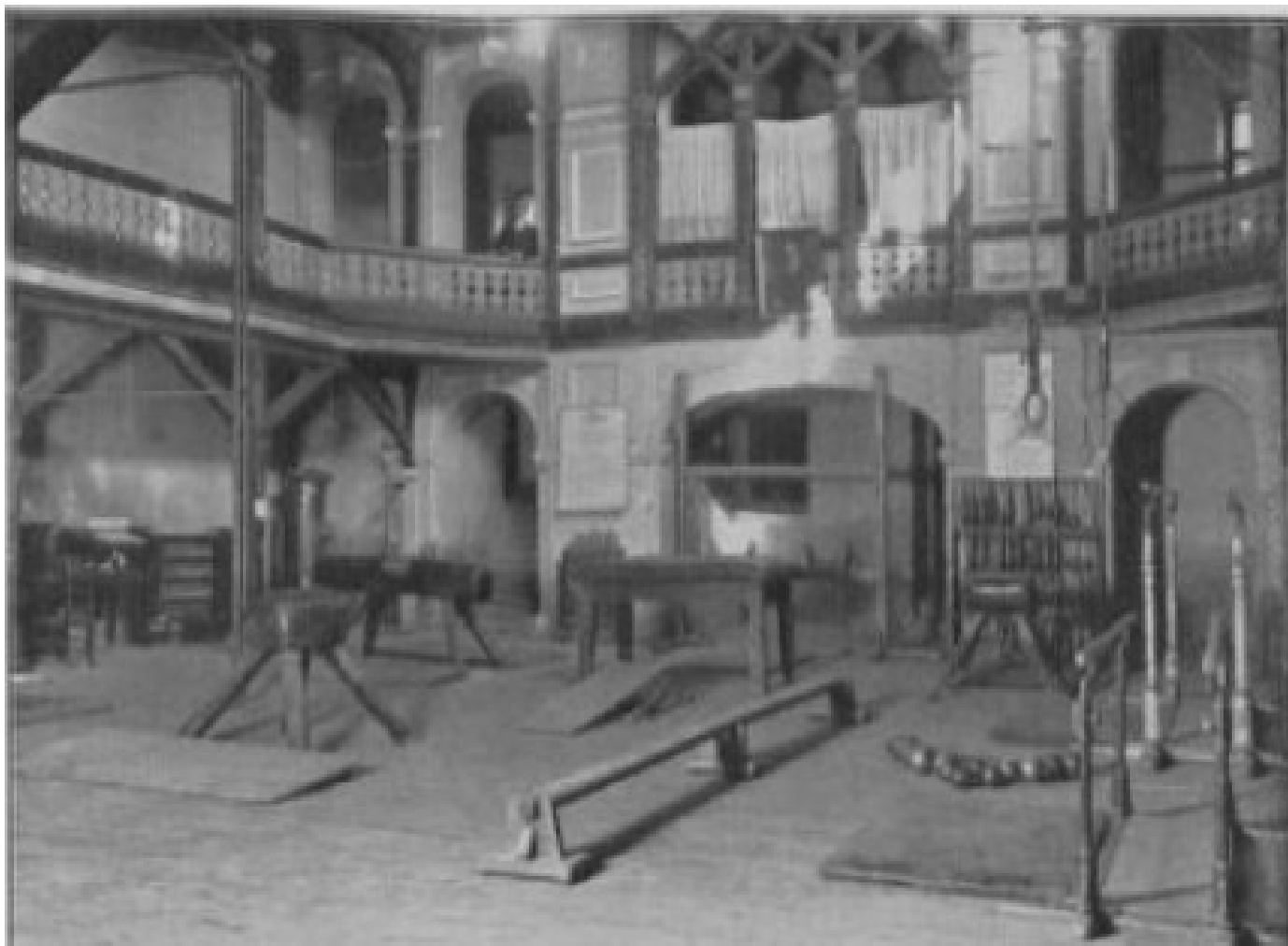
Obr. č. 6: Vnitřní prostory sokolovny na Kavčím plácku
