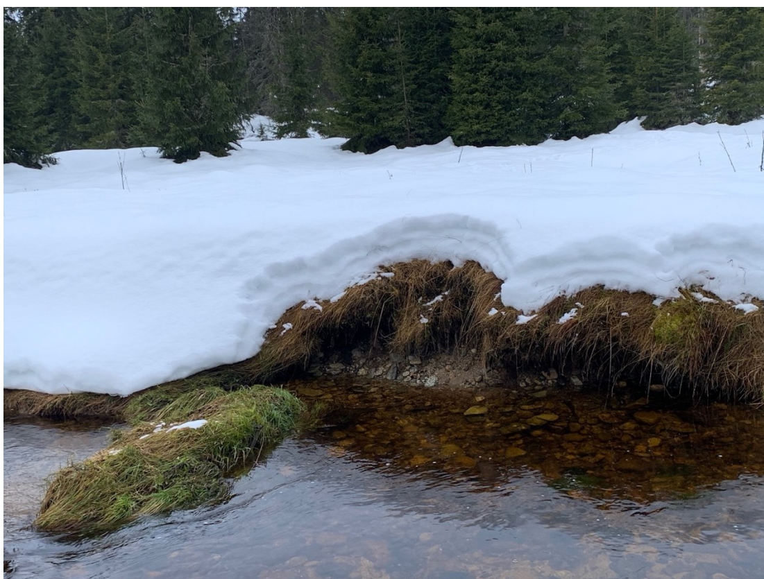
Příloha 10: Část nátrže č. 5, jež je částečně zakrytá sesunutou částí břehu, pořízeno: 28. 12. 2021, zdroj: archiv Jakuba Šolce
