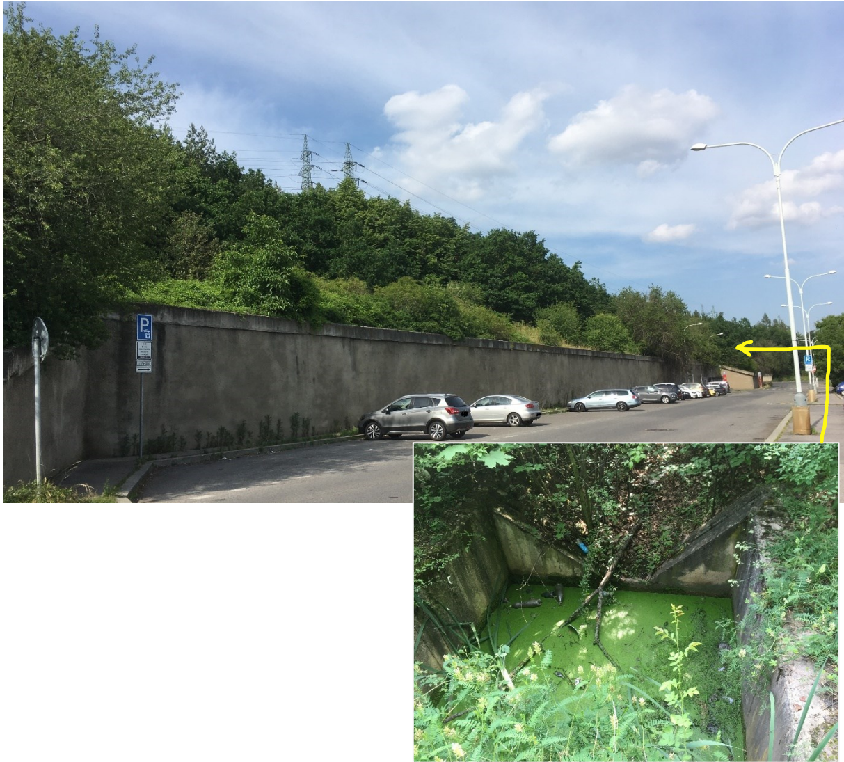
Obrázok 42: Nad parkoviskom Nemocnice Na Homolce sa nachádza stabilizovaný zosuv, o čom svedčia technické opatrenia v podobe oporného múru a odvodňovacích strúh (vpravo dole). Podľa dátových a mapových podkladov (databáza PanGeo IPR hl. m. Prahy, ZM 10 ČÚZK) plocha zosuvu nezasahuje pod stožiare vysokého napätia (horná časť fotografie), a naopak zasahuje prakticky celý areál nemocnice. Zdroj: archív autora (jún 2021).
