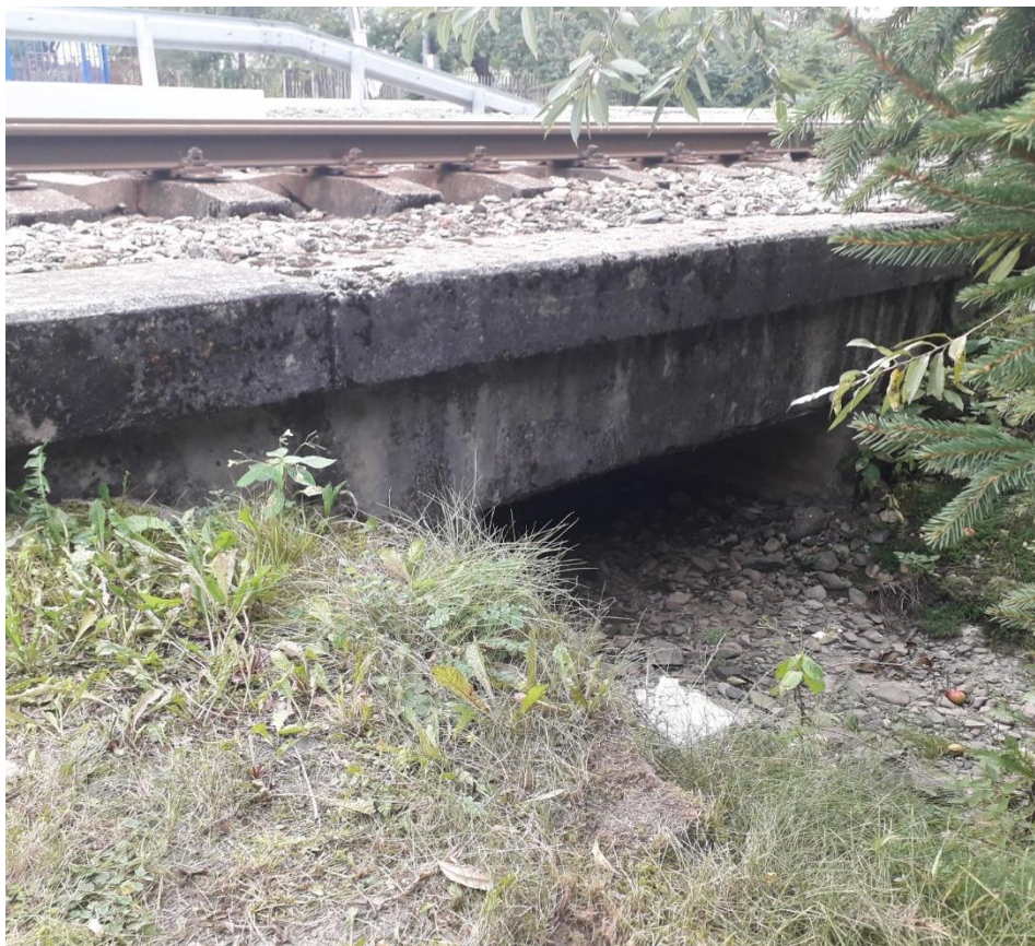
Príloha 35: priepust náhonu pod telesom železničnej trate a miesto jeho vtoku späť do riečišťa. Foto autor, fotené v auguste 2021
