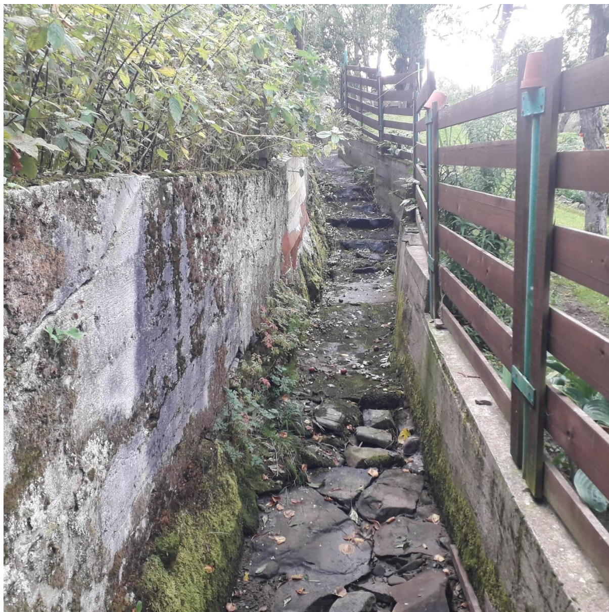
Príloha 34: Súčasný stav betónových základov píly a miesta, kde stávalo vodné koleso. Foto autor, fotené v auguste 2021.
