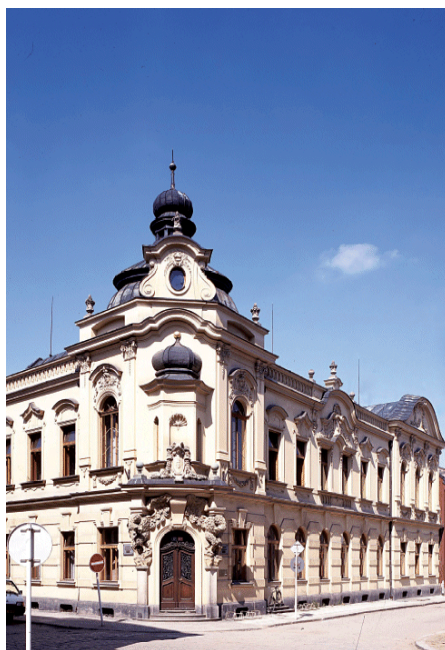
Obrázek 3: Budova ústřední knihovny v Tomkově ul. č. p. 177
