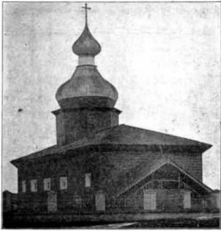
Рис. 51. Никольская церковь с. Шелоки.
