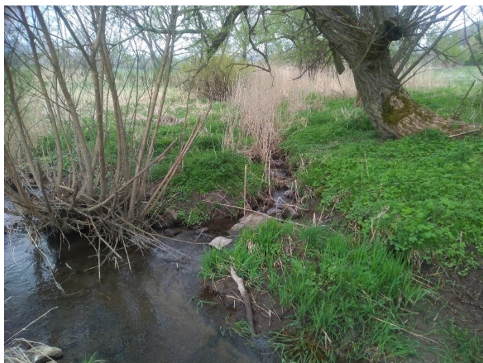
Příloha 14: Výúst odvodnění do Klíšského potoka d3pl (povrchová, z levé strany) Zdroj: Fotografie autorky (2021)
