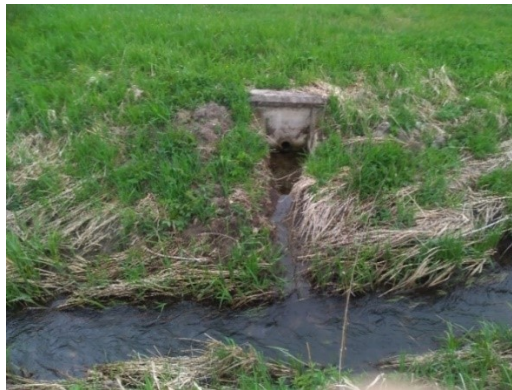
Obrázek 2: Příklad vyústění drenáže do vodního toku Zdroj: Fotografie autorky (2021)
