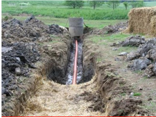
Obrázek 11: Ukázka denitrifikačního biofiltru (lůžko) Zdroj: Zajíček (2019a)
