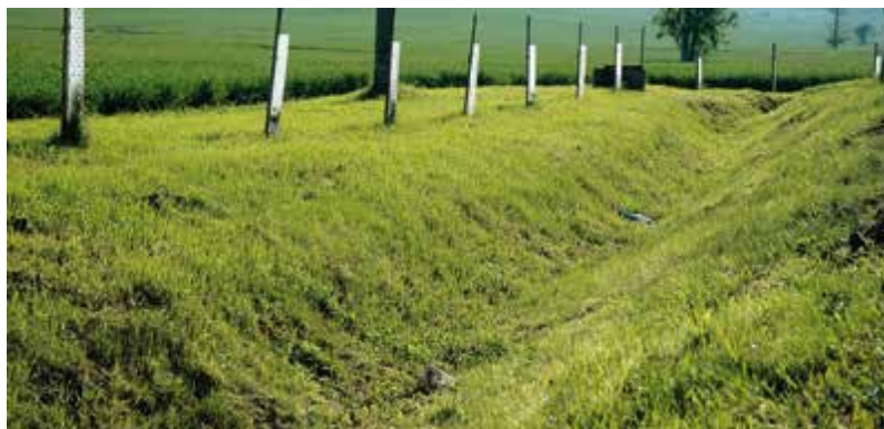
Obrázek 12: Ukázka zatravněného zasakovacího příkopu Zdroj: Dzuráková a kol. (2017)
