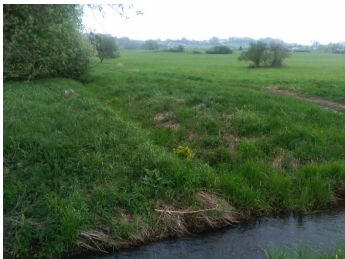
Příloha 17: Výúst odvodnění do Klíšského potoka d7pl (povrchová, z levé strany) Zdroj: Fotografie autorky (2021)
