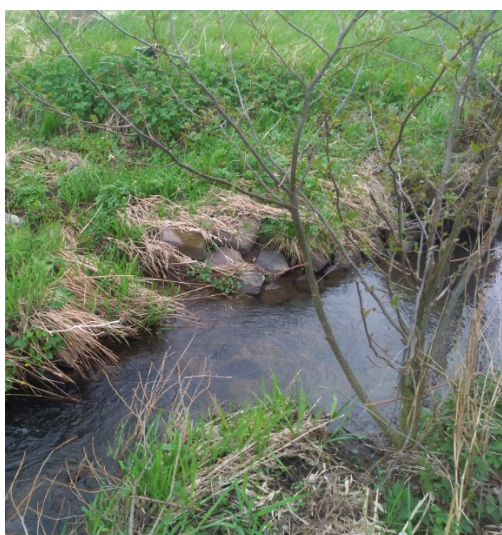
Příloha 15: Výúst odvodnění do Klíšského potoka d4pl (povrchová, z levé strany) Zdroj: Fotografie autorky (2021)
