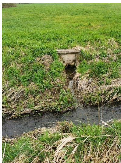
Příloha 12: Výúst odvodnění do Klíšského potoka d1tp (zatrubněná, z pravé strany) Zdroj: RNDr. Milada Matoušková, Ph.D. (2021)
