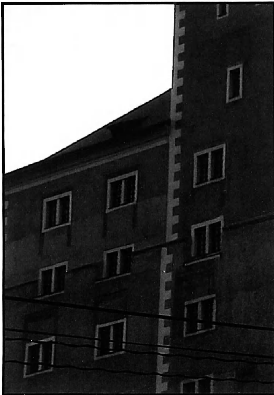
Obr. 34: Pohled na jihovýchodní průčelí paláce a věže, kde jsou zřetelná ostění velkých gotických oken; foto autor, 4. 10. 2006.
