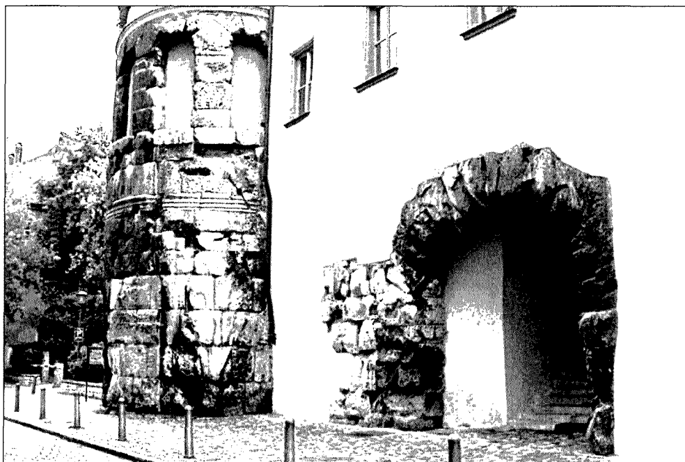
Řezno, brána Porta praetoriana. Pozůstatky antického Castrum Regino v zástavbě Starého Města, brána byla postavena ve 2. století za vlády císaře Marka Aurelia.
