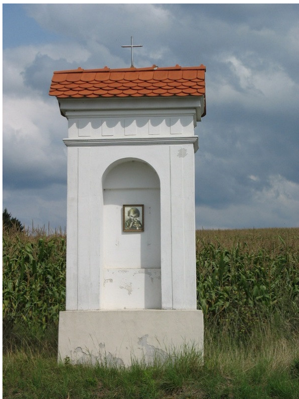
Obr. 19. Výklenková kaplička na kopci u Choustniku. Farnost Choustník (objekt č. 16).
