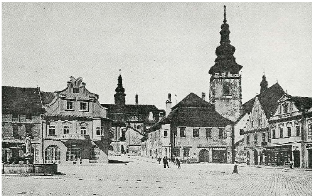
1. Pavel Janák: rekonstrukce Fárařova domu v Pelhřimově (1913)
