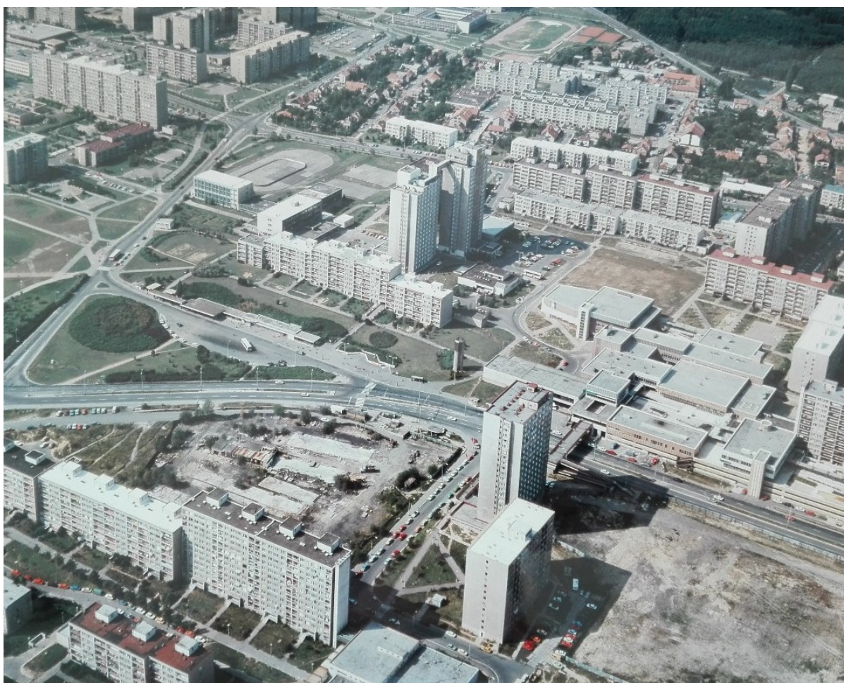
Obrázek 23 – Výškové budovy Kupa propojené v nejvyšších patrech můstkem, vpravo od Kupy část centra Hájů a další výškový dům; jeden z několika, které měly opticky vymezovat lokální centra jednotlivých souborů. Foto z 1. poloviny 90. let. Zdroj: archiv IPR HMP
