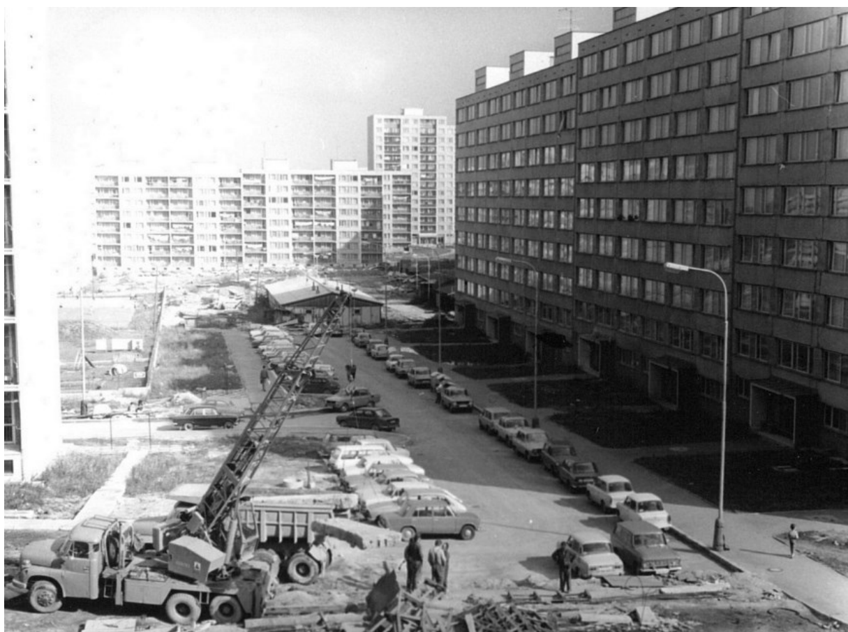
Obrázek 21 – Byty již byly předány, ale stavební práce v jejich bezprostředním okolí stále pokračovaly. Zdroj: https://www.metro.cz/foto.aspx?r=metro-praha&c=A161016_191649_praha-metro_lupo&foto=LUP66ac9d_7V.jpg
