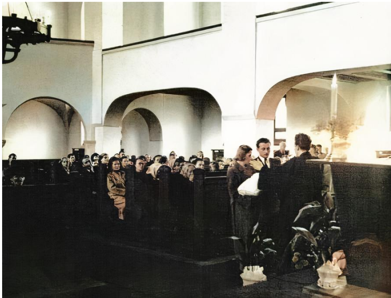
interiér kostela, kolorováno, zdroj: http://www.znicenekostely.cz/?load=detail&id=13994
