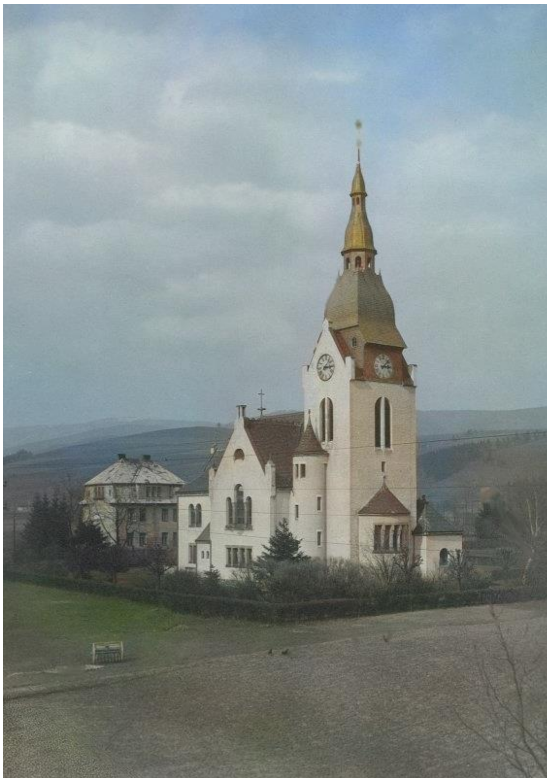
historická fotografie kostela, před r. 1945, zdroj: http://www.znicenekostely.cz/?load=detail&id=13884
