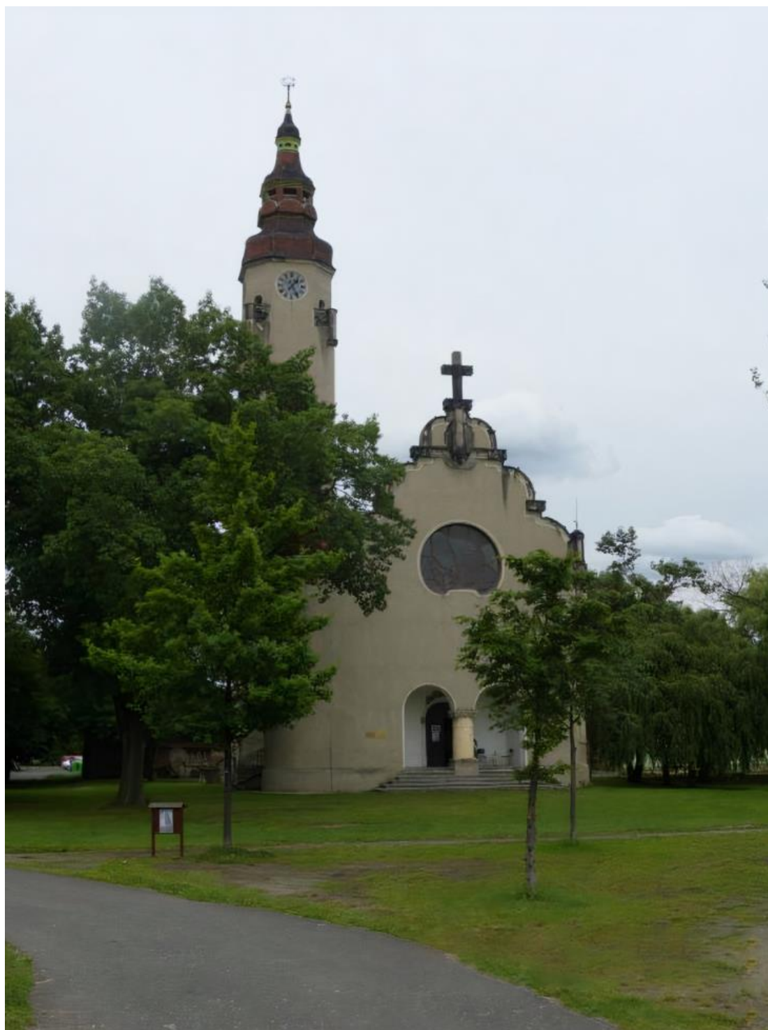
pohled na jižní fasádu kostela, foto: archiv autora.
