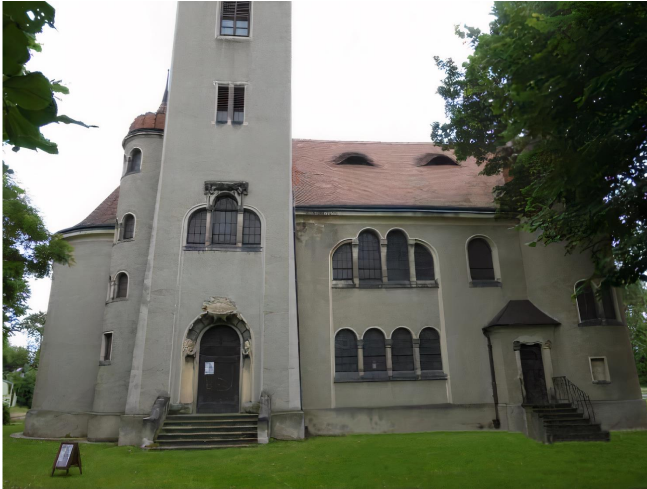
pohled na západní stranu kostela s věží, foto: archiv autora.
