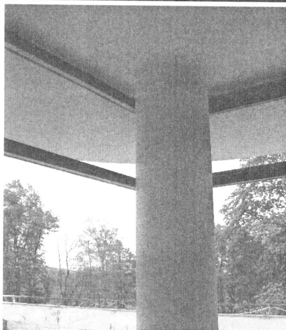
A. Tenzer, G. Paul, F. Čermák : Sanatorium ve Vrážci u Písku 1934-36 Léčebný pavilon Interiér, Detail madla dveří, Detail sloupu terasy Fotografie, 2007
