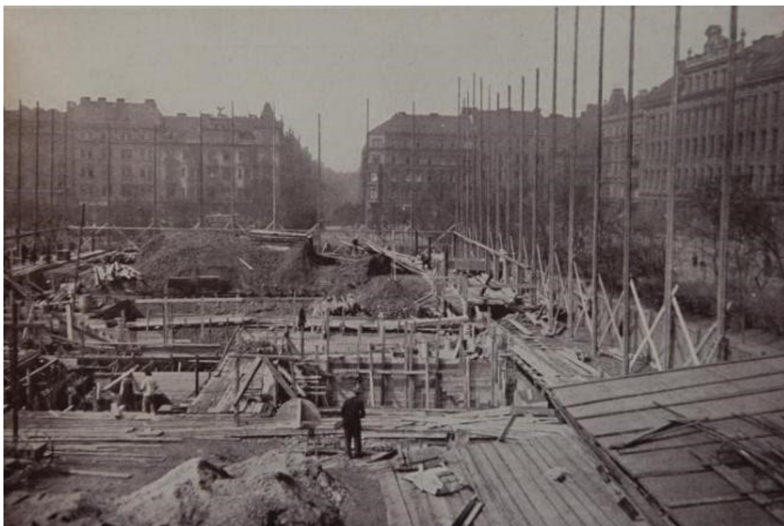
33. Josip Plečnik: Stavba 2. vinohradského kostela, severovýchodní strana, pohled na staveniště
