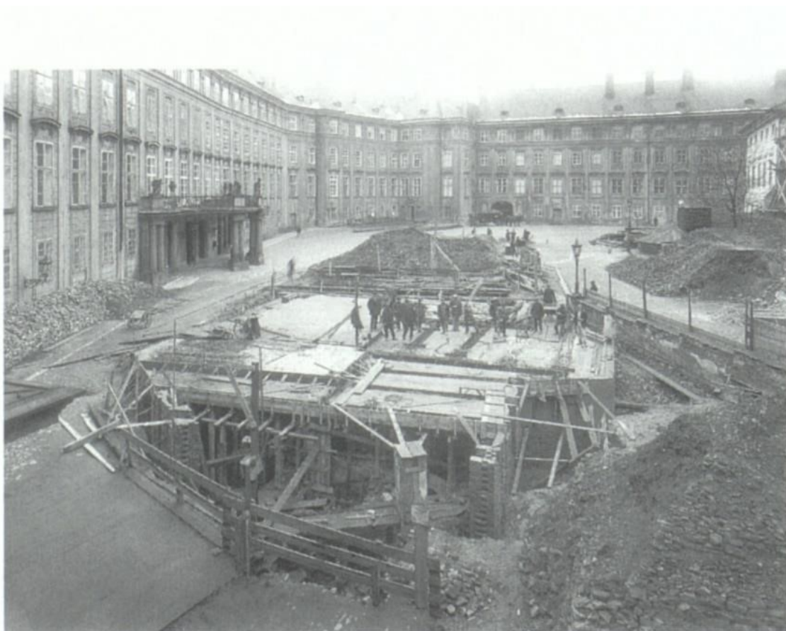
59. Josip Plečnik, Třetí nádvoří stavba betonové střechy nad vykopávkami, 1926
