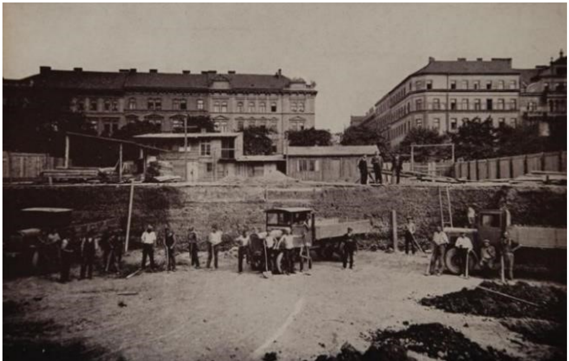
32. Josip Plečnik: Stavba 2. vinohradského kostela, práce ve výkopech
