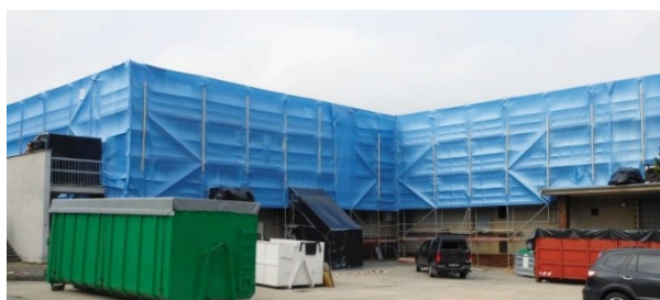
Obrázek 5: Příprava hermeticky uzavřeného pásma s viditelnou dekontaminační komorou, v popředí zabezpečené kontejnery. [38]
