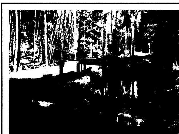
Obr. 7.1 Levobřežní náhon pro MVE Smolné Pece: v minulosti ovšem přiváděl vodu pro jinému účelu, než je výroba elektřiny, a to na výrobu papíru. Tato manufaktura se podle reambulované mapy nacházela na levém břehu nad mostem přes Rolavu vedoucím do Smolných Pecí. Koryto Rolavy se v tomto místě nachází cca o 20 výškových metrů níže (na fotografii vlevo od náhonu).
