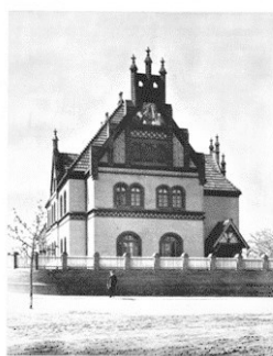
359. Hlavní průčelí fary. Poštorná.
