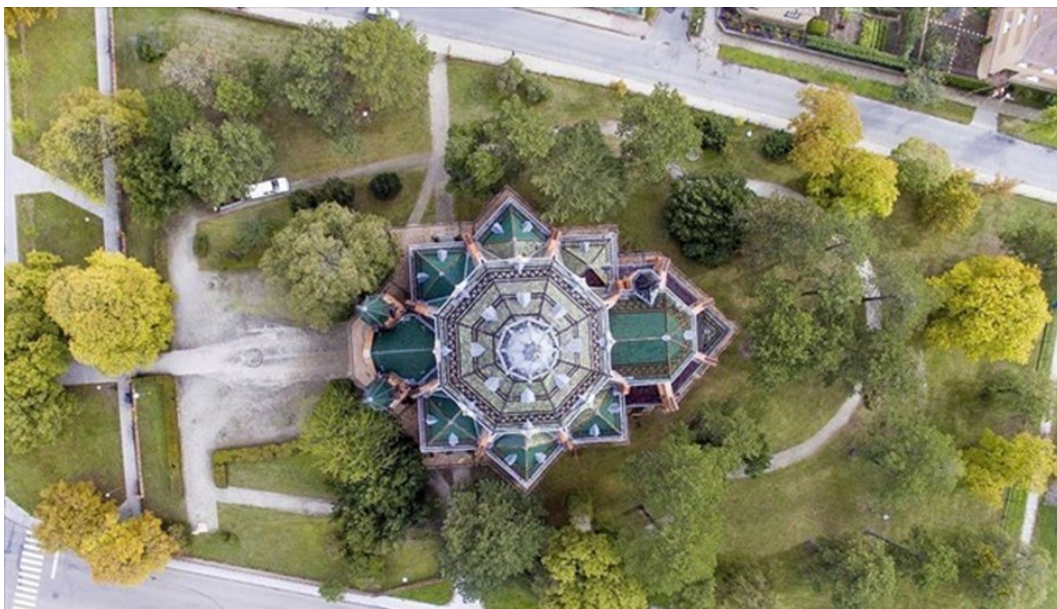
50. Kostel Navštívení Panny Marie. Poštorná.
