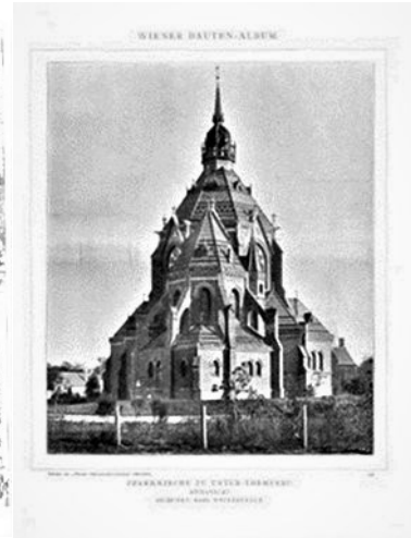
340. Kostel Navštívení Panny Marie. Poštorná.
