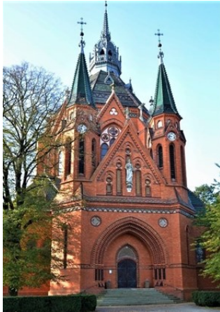
241. Kostel Navštívení Panny Marie. Poštorná.
