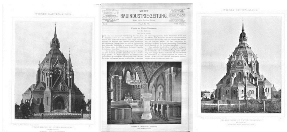
341. 342. 343 Kostel Navštívení Panny Marie. Poštorná.
