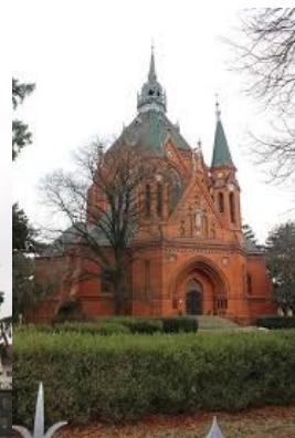
368. Kostel Navštívení Panny Marie. Poštorná. (1894–1898)
