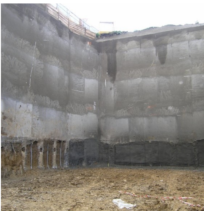
obr. 6. Zasítování a betonování prvních osmi metrů souvrství, viditelné poslední odkryté vrstvy.
