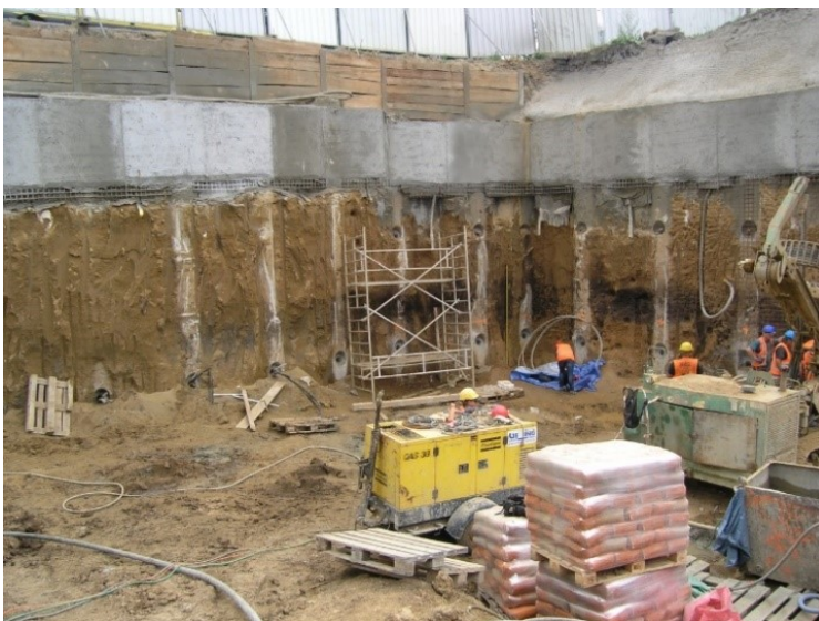
obr. 5. Místo odběru vzorků na profilu v Praze v Dejvicích - postupné prohlubování základové jámy, zasítování prvních dvou metrů a stavební práce na odkrytém profilu.
