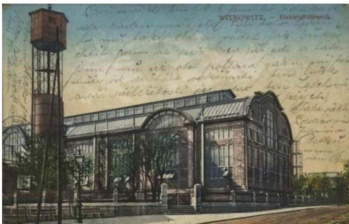
Příloha 20 – Elektrická centrála ve Vítkovicích v roce 1913
