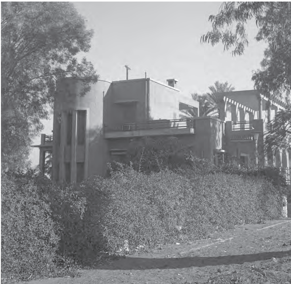
Obr. 1 Vila na Třídě pyramid č. 18 v Gíze, která byla od roku 1959 po dvě desetiletí sídlem káhirského pracoviště tehdejšího Československého egyptologického ústavu (foto M. Zemina) / Fig. 1 The villa on Al-Ahram St. 18 in Giza, where the Cairo branch of the then Czechoslovak Institute of Egyptology was settled in 1959 (photo M. Zemina)
