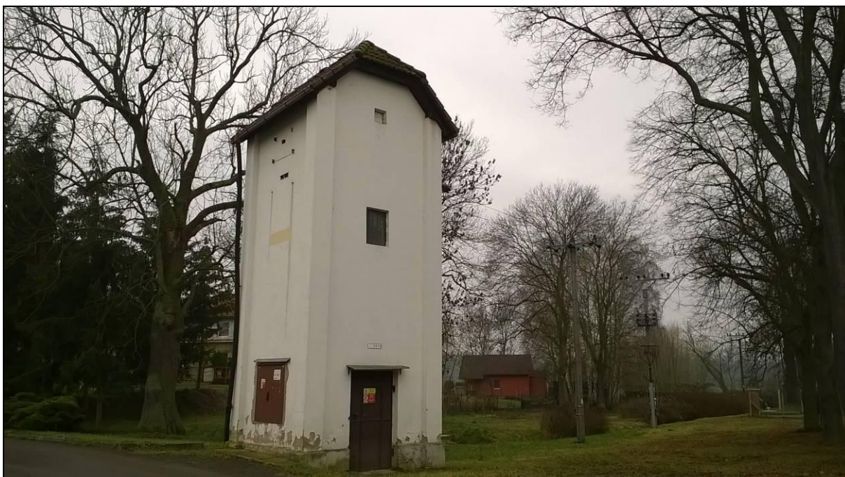
Obrázek 296. Trafostanice Veselá u Mnichova Hradiště, nenormovaný typ. Foto Jiří Chmelenský, 2015.
