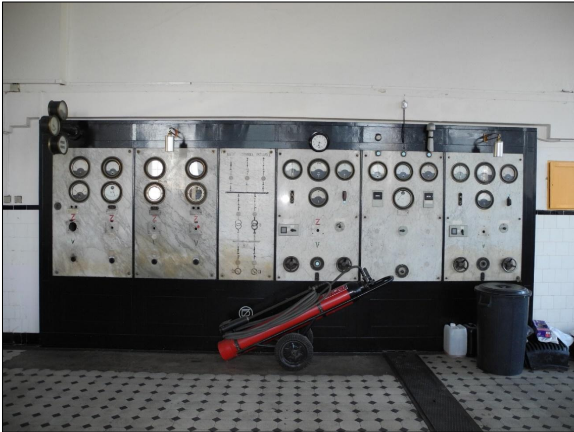
Obrázek 119. Rozvodná deska od firmy František Křížik v MVE Haškov u Mnichova Hradiště. Foto Jiří Chmelenský, 2015.
