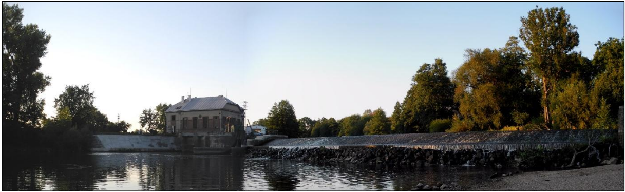
Obrázek 20. MVE Haškov u Mnichova Hradiště, příklad vodního díla jezového. Vpravo dlouhý jez kamenné konstrukce o délce 67 m, pohyblivý jez o délce 10,5 m a výšce 1,25 m, MVE s jalovým přepadem a vývařišti turbín. Foto Jiří Chmelenský, 2015.
