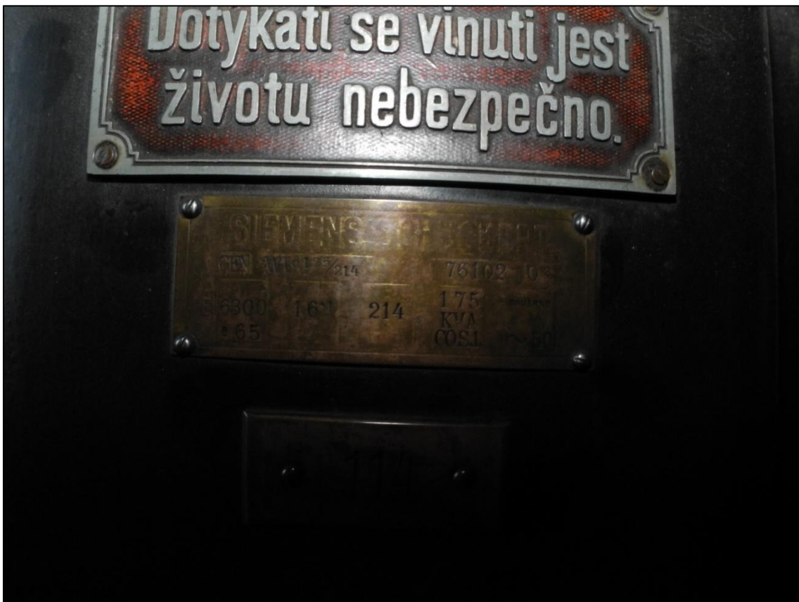
Obrázek 165. Štítek generátoru I od firmy SIEMENS SCHUCKERT WId 175/214 o výkonu 214 kW. Foto Jiří Chmelenský, 2015.
