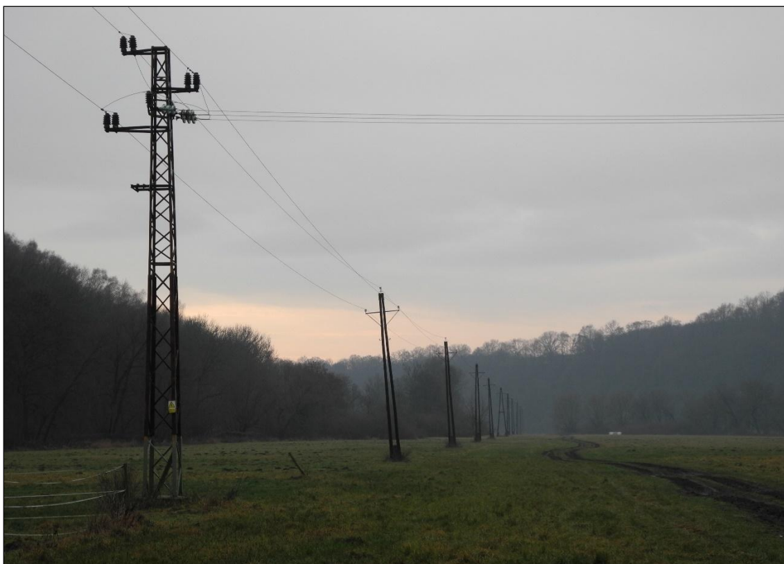
Obrázek 192. Pokračování elektrovedu viz výše. První stožár je železný, nýtovaný, přechodový přes silnici Mnichovo Hradiště – Mohelnice, druhý, třetí, čtvrtý, pátý jsou dřevěné dvojité sloupy a šestý sloup je dvojitý vzepřený. Foto Jiří Chmelenský, 2015.
