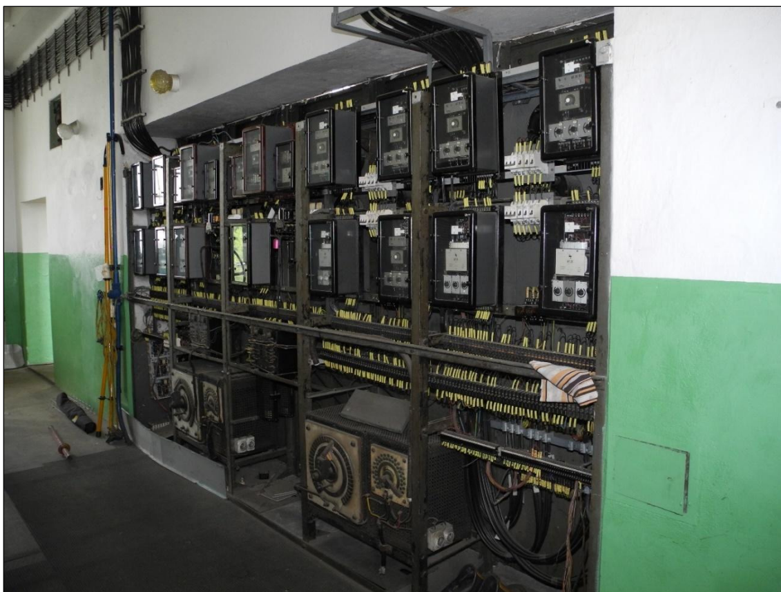
Obrázek 139. Detail zadní strany odpojené rozvodné desky. Dole byly ponechány původní ovládací reostaty. Foto Jiří Chmelenský, 2015.
