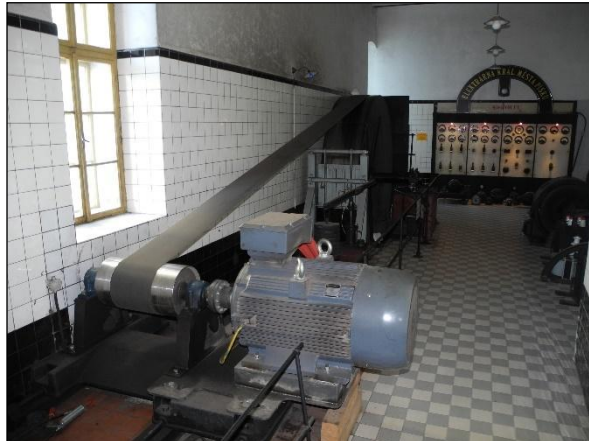
Obrázek 53. Horizontální generátor číslo II. s budičem (vlevo) MVE Rožátov u Mladé Boleslavi. Generátor výroby firmy Siemens-Schuckert, typu WId 175/214, číslo 76101 o výkonu 175 kVA. Budič výroby Siemens-Schuckert, typu W30, čísla 80922 o výkonu 5,4 kW. Konstrukce z roku 1918. Foto Jiří Chmelenský, 2015.
