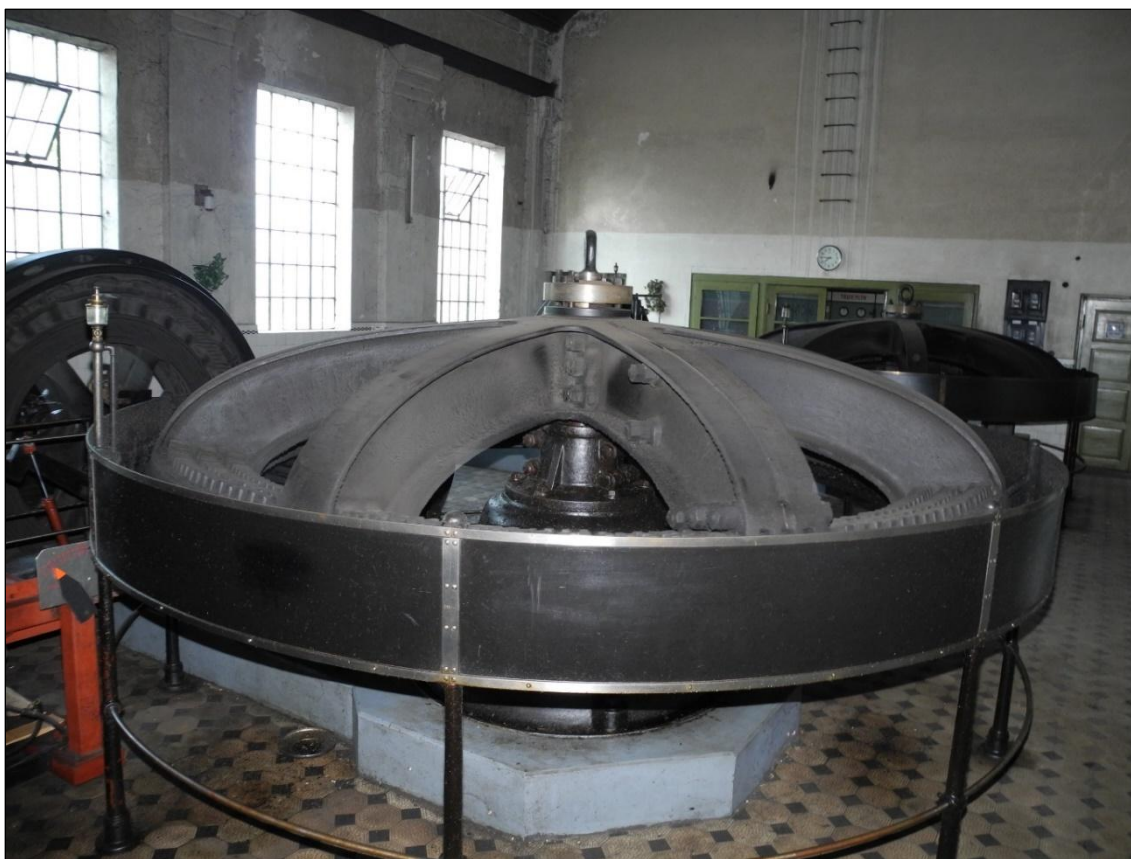
Obrázek 160. Zvonové kolo I, vzadu generátor I. Strojovna MVE Rožátov. Foto Jiří Chmelenský, 2015.
