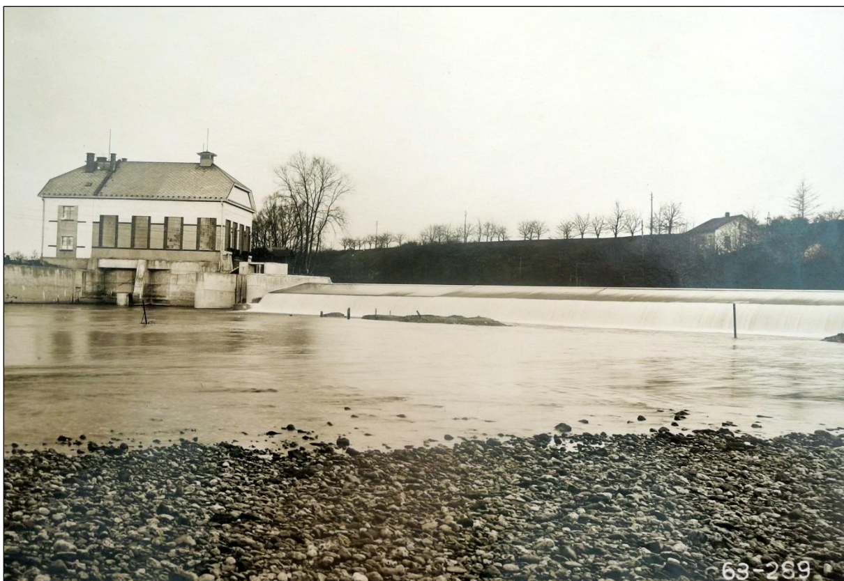
Obrázek 101. Pohled na MVE Haškov po dokončení, pravděpodobně rok 1927. Pohled je orientován proti proudu, vlevo elektrárna, patrné jsou odpadní kanály, sklopný jez a pevný jez.
