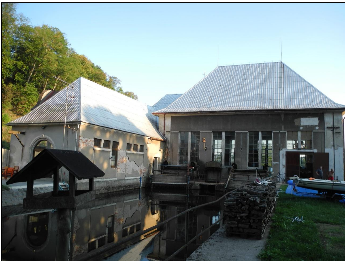
Obrázek 88. Vlevo obytná část severní strany elektrárny. Foto Jiří Chmelenský, 2015.
