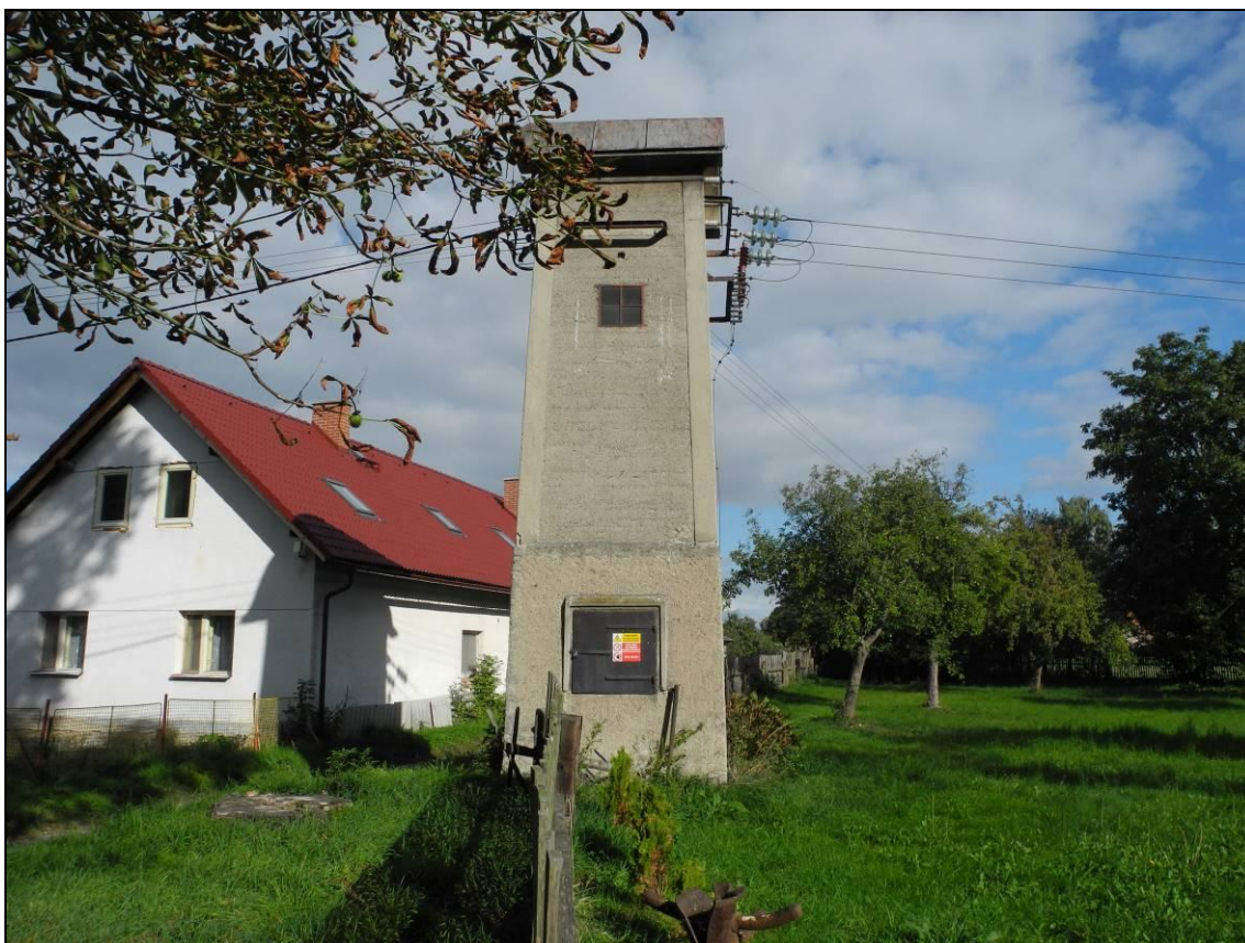
Obrázek 214. Trafostanice Býčina, celkový pohled. Foto Jiří Chmelenský, 2015.
