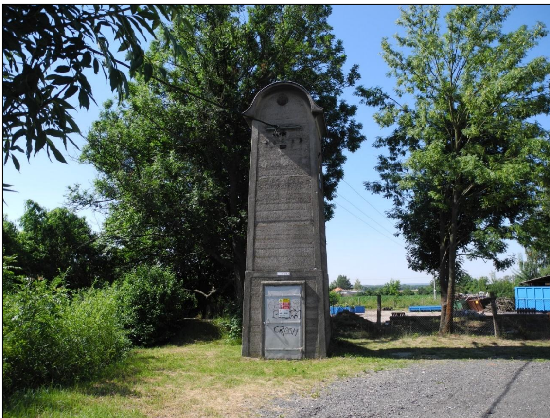
Obrázek 253. Trafostanice Kněžmost dochovaná v původním stavu, včetně dveří. Foto Jiří Chmelenský, 2015.
