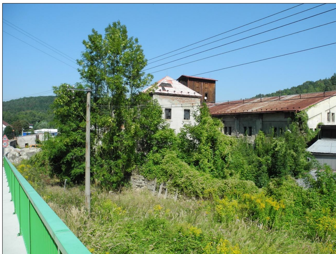
Obrázek 227. Trafostanice/rozvodna Dolní Cetno cukrovar. Foto Jiří Chmelenský, 2015.
