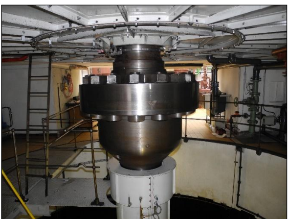
Obrázek 55. Moderní současné vertikální generátory firmy Flender typu H2VW 12, čísla 4254935 o výkonu 200 kW s cizím buzením. MVE Hněvousice u Mnichova Hradiště. Foto Jiří Chmelenský, 2015.
