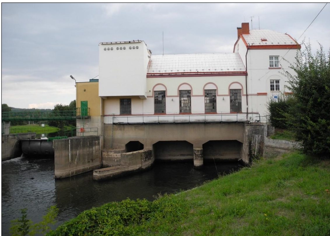
Obrázek 130. MVE Bakov od jihu. Vpravo opevněný břeh, dva odpadní kanály turbín, jalový přepad a jezové pole. Vpravo objekt správy elektrárny, uprostřed strojovna, vpravo v přízemí stará rozvodna, nad ní novější rozvodna 22 kV. Foto Jiří Chmelenský, 2015.
