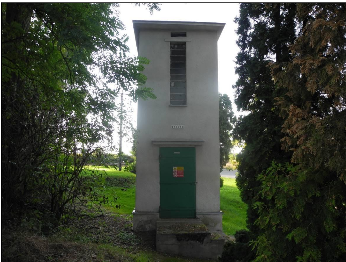
Obrázek 217. Trafostanice Čejetice, rekonstruovaná, omítnutá, dveře původní, stejně jako prosvětlovací otvor. Foto Jiří Chmelenský, 2015.
