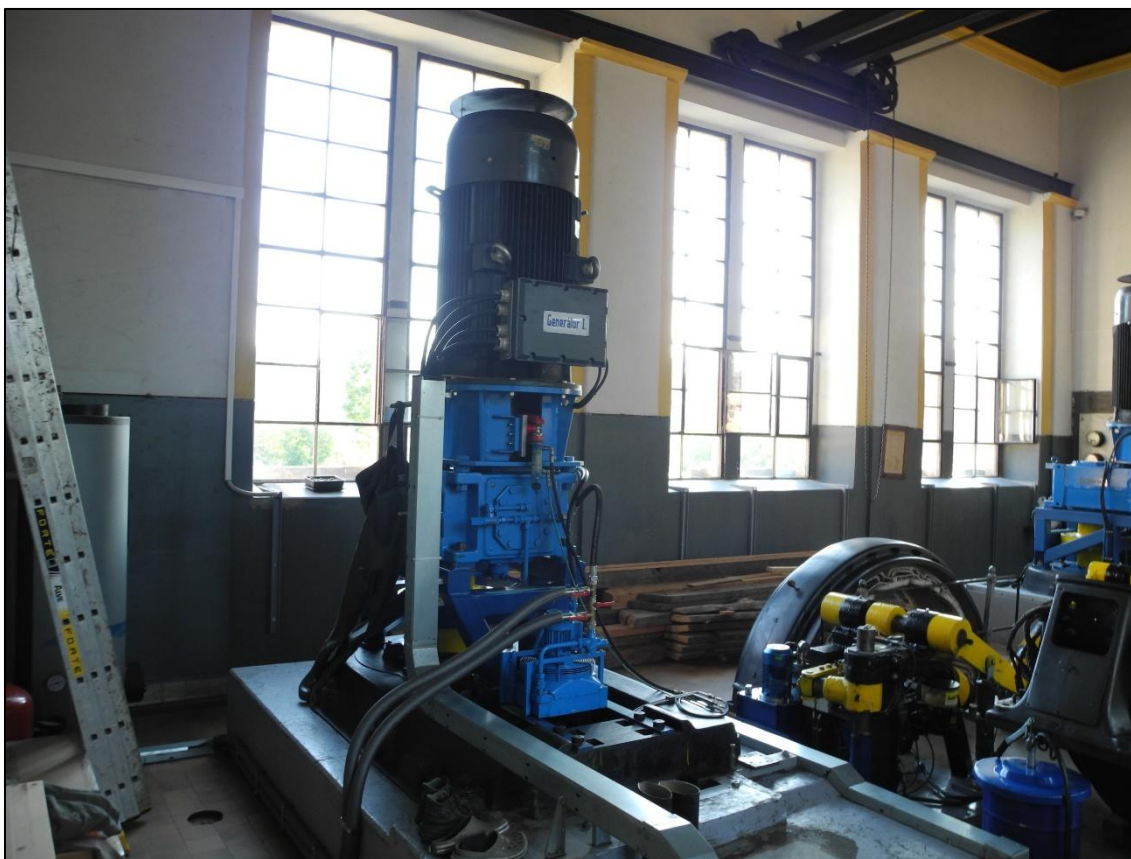
Obrázek 91. Pohled do strojovny na nové generátory. Zde generátor I. Dobře patrné je přebetonované původní lože generátorů a regulace. Foto Jiří Chmelenský, 2015.
