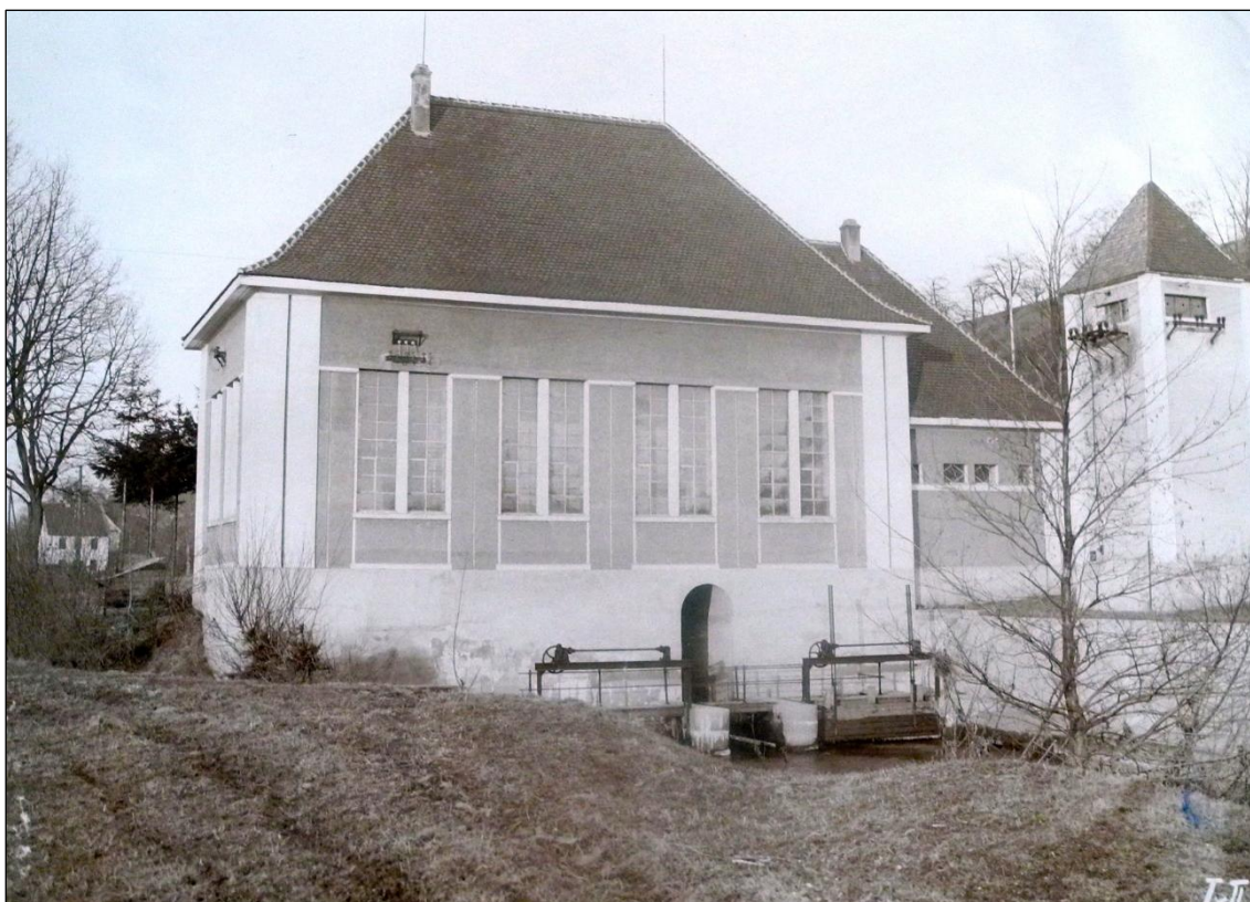
Obrázek 81. MVE Hněvousice, pohled od jihozápadu na budovu strojovny, jalový přepad a dva uzávěry odpadního kanálu. Vlevo trafostanice.
