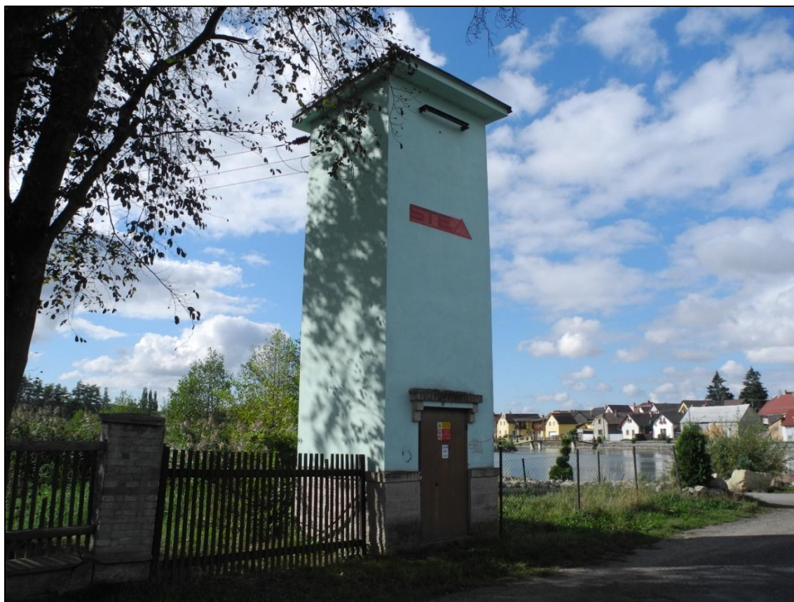
Obrázek 220. Trafostanice Dolní Bousov. Foto Jiří Chmelenský, 2015.
