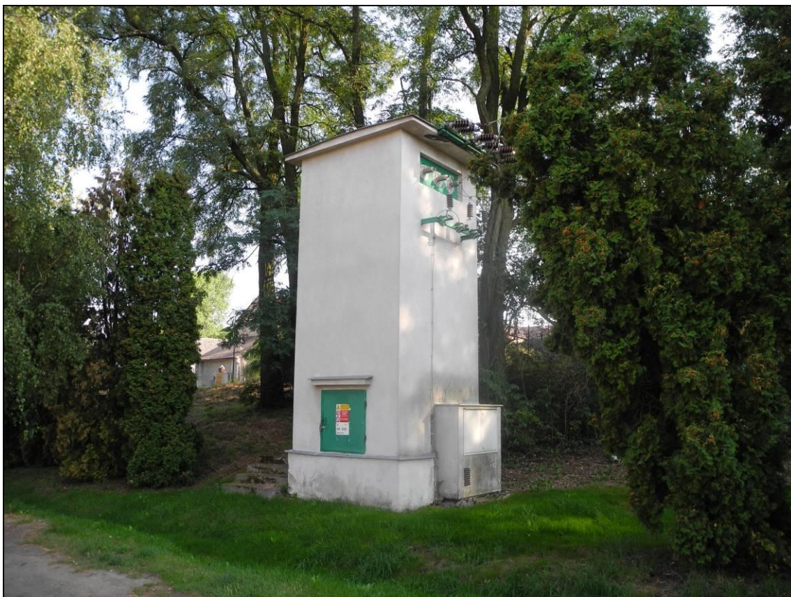
Obrázek 218. Trafostanice Čejetice. Pohled na Nepůvodní dvířka rozvaděče a na nově přistavěný rozvaděč. Foto Jiří Chmelenský, září 2015.
