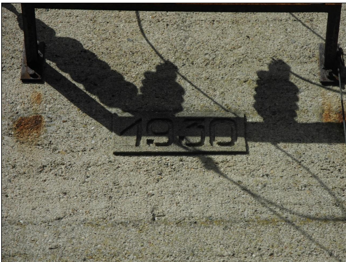
Obrázek 291. Datace výstavby trafostanice Strážiště rok 1930. Foto Jiří Chmelenský, 2015.
