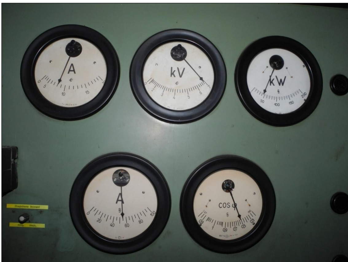
Obrázek 171. Ampérmetr, Voltmetr a Wattmetr v provozu díky generátoru I. Foto Jiří Chmelenský, 2015.
