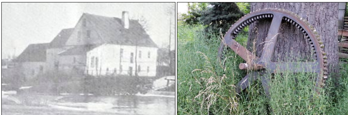
Obrázek 66. Družstevní elektrárna Bezděkov (okr. Klatovy). Pohled přes jez.
