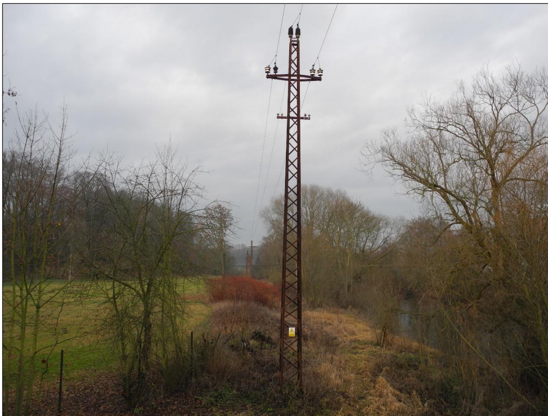
Obrázek 190. Elektrovod Hněvousice – Mladá Boleslav Rožátov. V popředí tzv. přechodový nýtovaný stožár, vzadu dřevěné, dvojité sloupy. Foto Jiří Chmelenský, 2015.
