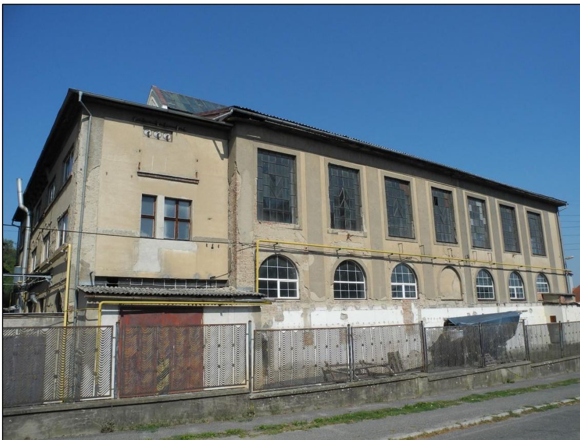
Obrázek 205. Jihozápadní pohled na parní elektrárnu Dražice. Pohled na transformovnu elektrárny. Foto Jiří Chmelenský, 2015.
