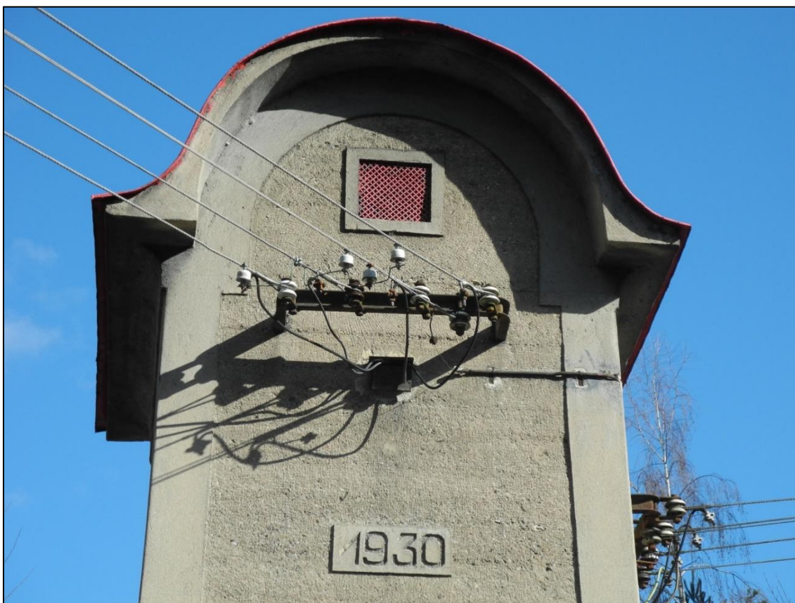
Obrázek 285. Ventilační otvor, výstupy nn a datace 1930. Foto Jiří Chmelenský, 2015.
