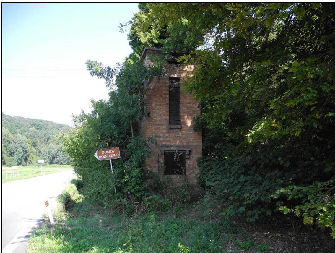
Obrázek 223. Trafostanice Dolní Cetno, opustěná, dochovaná v původním stavu, volně přístupná na vlastní nebezpečí! Foto Jiří Chmelenský, 2015.
