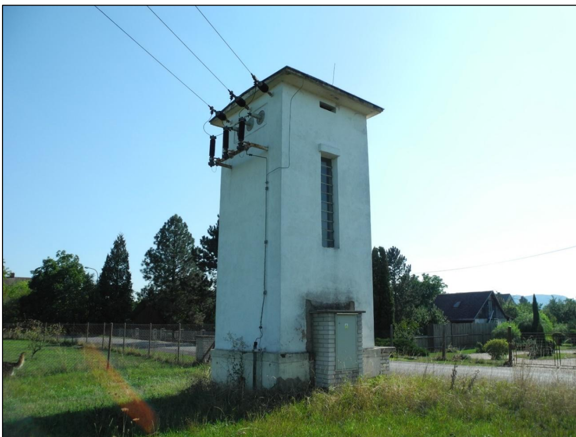
Obrázek 233. Trafostanice Doubrava, patrné je prosvětlovací okno interiéru s původním zasklením a větrací otvor těsně pod střechou. Foto Jiří Chmelenský, 2015.
