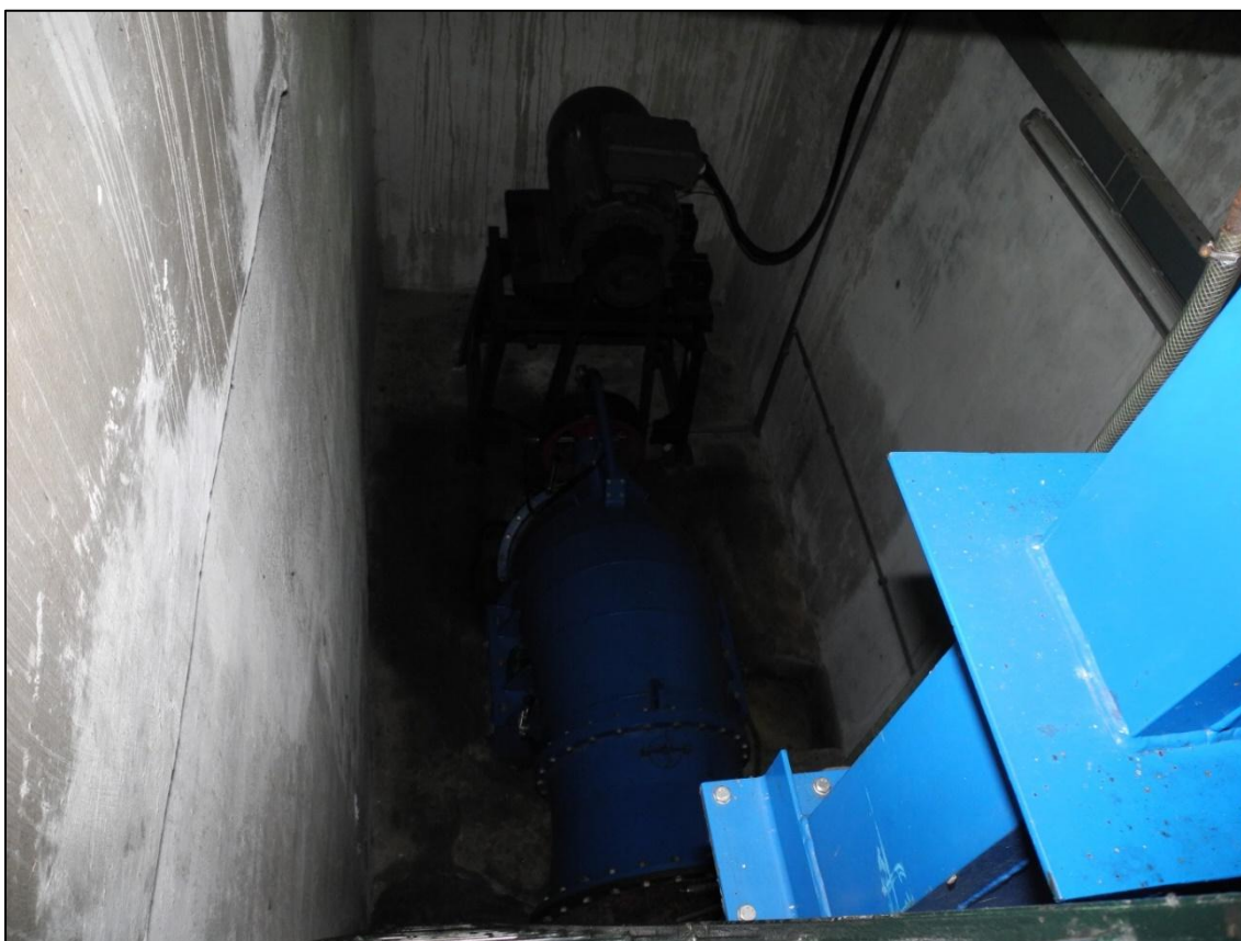
Obrázek 100. Detail Kaplanovy turbíny od výkonu 100 kW v turbínové kašně. Foto Jiří Chmelenský, 2015.
