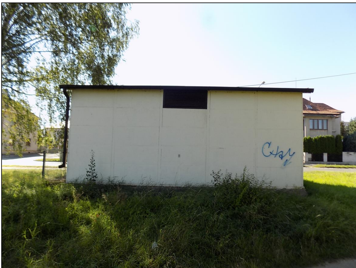
Obrázek 306. Rozvodna Mnichovo Hradiště, pohled na východní stěnu rozvodny. Foto Jiří Chmelenský, 2016.
