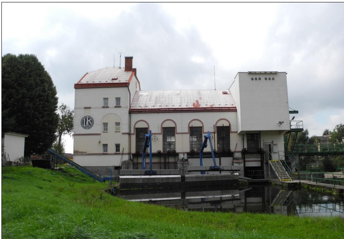
Obrázek 129. Pohled na MVE Bakov od severu. V popředí náhon, na něm zcela vpravo hrubé česle s lávkou, vpředu jemné česle se shrabovacím zařízením. Vlevo objekt správy elektrárny, uprostřed strojovna, vpravo přízemí původní rozvodny, nad ní přistavěná 22 kV rozvodna. Foto Jiří Chmelenský, 2015.
