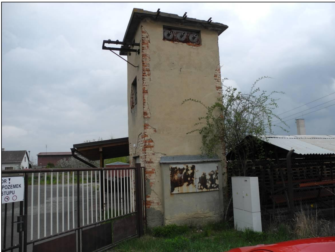
Obrázek 265. Trafostanice typ DZD po omítnutí. Patrné jsou vstupy vn a přistavěná rozvodná deska. Foto Jiří Chmelenský, 2015.
