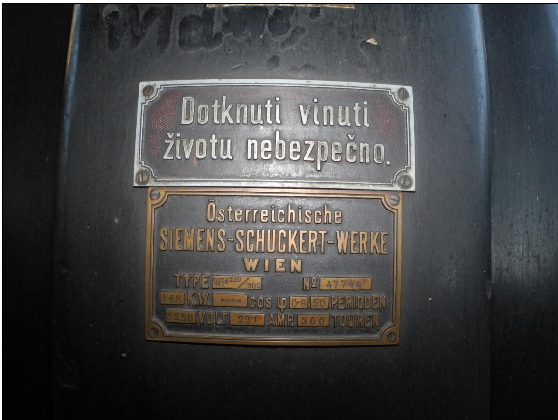
Obrázek 94. Detail výrobního štítku generátoru SIEMENS SCHUCKERT WERKE WIEN typ WId 210/300 o výkonu 168 kW. Foto Jiří Chmelenský, 2015.
