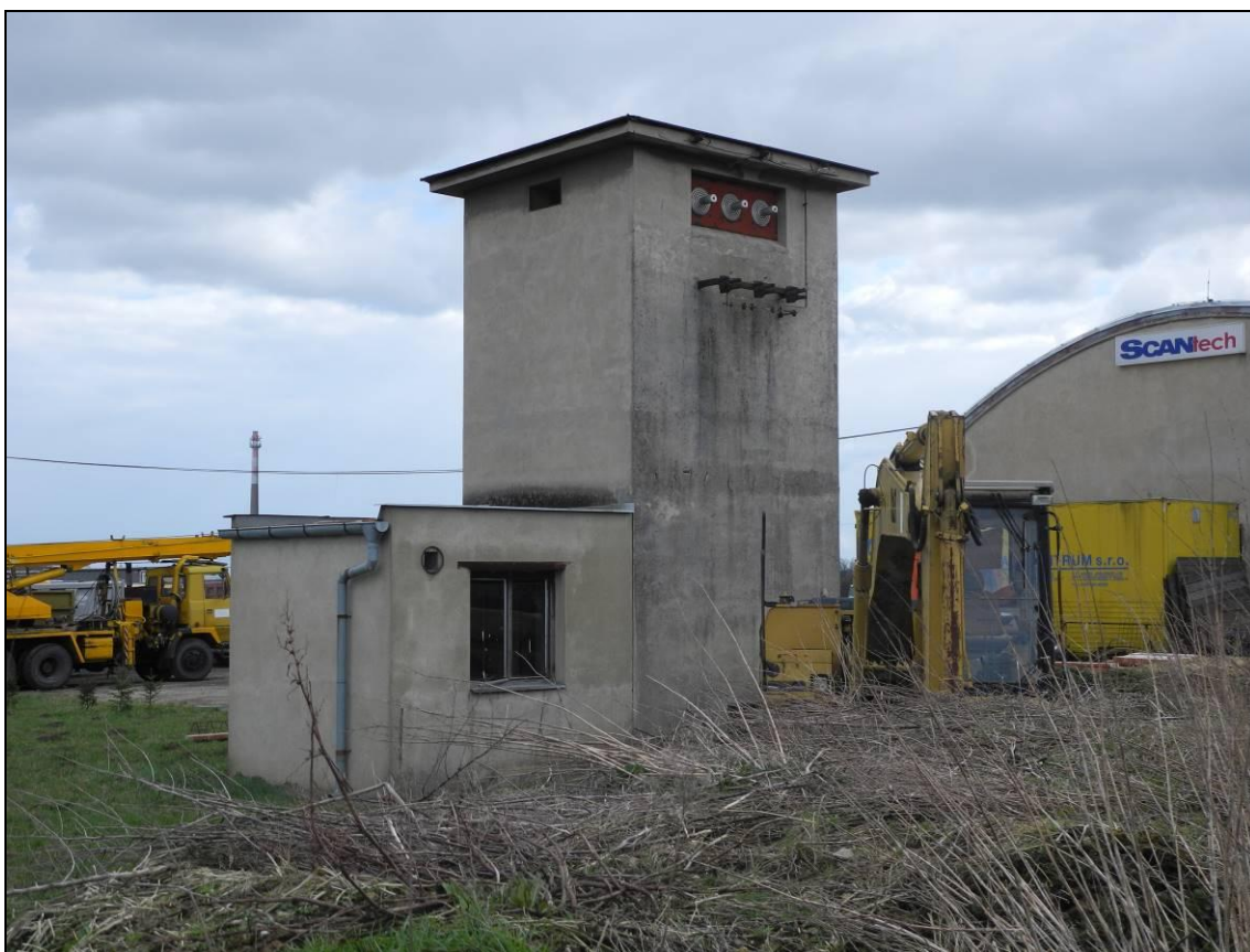
Obrázek 263. Pohled na vstupy vn přestavěné trafostanice a na netypickou přístavbu rozvodny nn. Foto Jiří Chmelenský, 2015.
