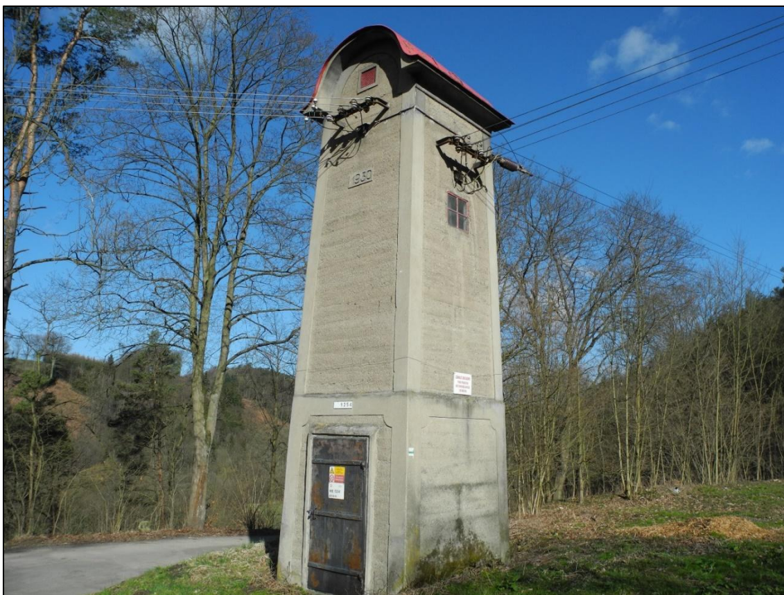
Obrázek 284. Trafostanice Podhora dochovaná v původním stavu. Foto Jiří Chmelenský, 2015.
