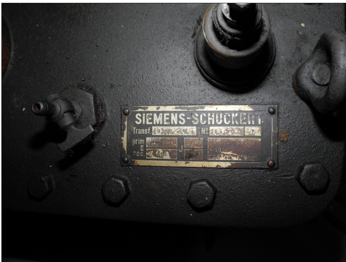
Obrázek 177. Detail štítku transformátoru firmy Siemens Schuckert typ KO206/6IIa s převodem 6,3 kV na 0,4 kV. Foto Jiří Chmelenský, 2015.
