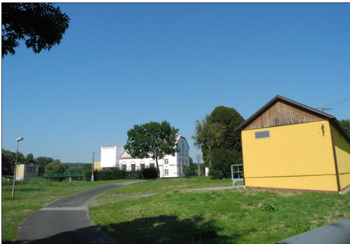
Obrázek 132. Pohled od vstupní brány na areál MVE Bakov. Vpravo nově postavená rozvodna z roku 2007. Foto Jiří Chmelenský, 2015.
