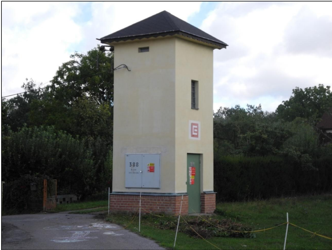
Obrázek 280. Trafostanice Osek. Foto Jiří Chmelenský, září 2015.
