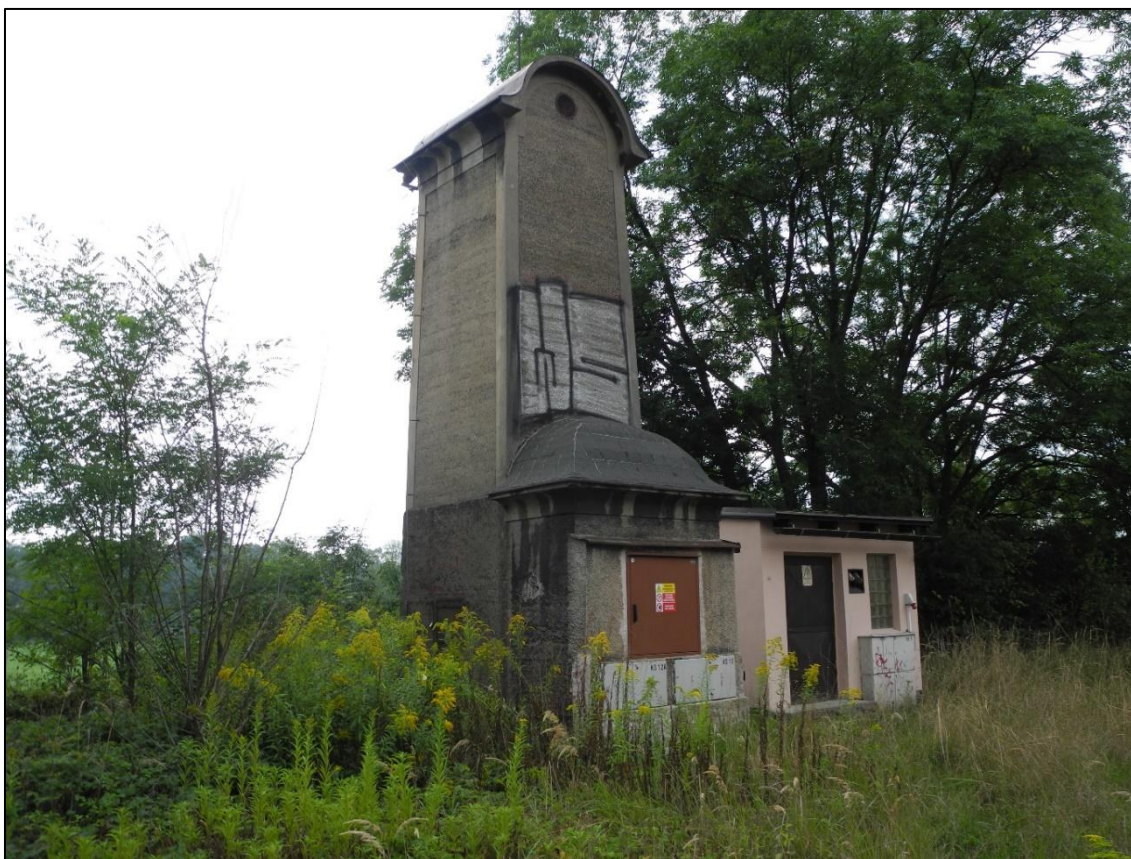
Obrázek 211. Trafostanice Bakov n. J. nádraží. Patrný je dobový přístavek rozvodny. Foto Jiří Chmelenský, 2015.
