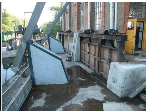
Obrázek 13. Pohled proti vodě na MVE Haškov u Mnichova Hradiště. Pod elektrárnou patrný odpadní kanál, jezové pohyblivé pole a vpravo pevný kamenný jez. Foto Jiří Chmelenský, 2015.
