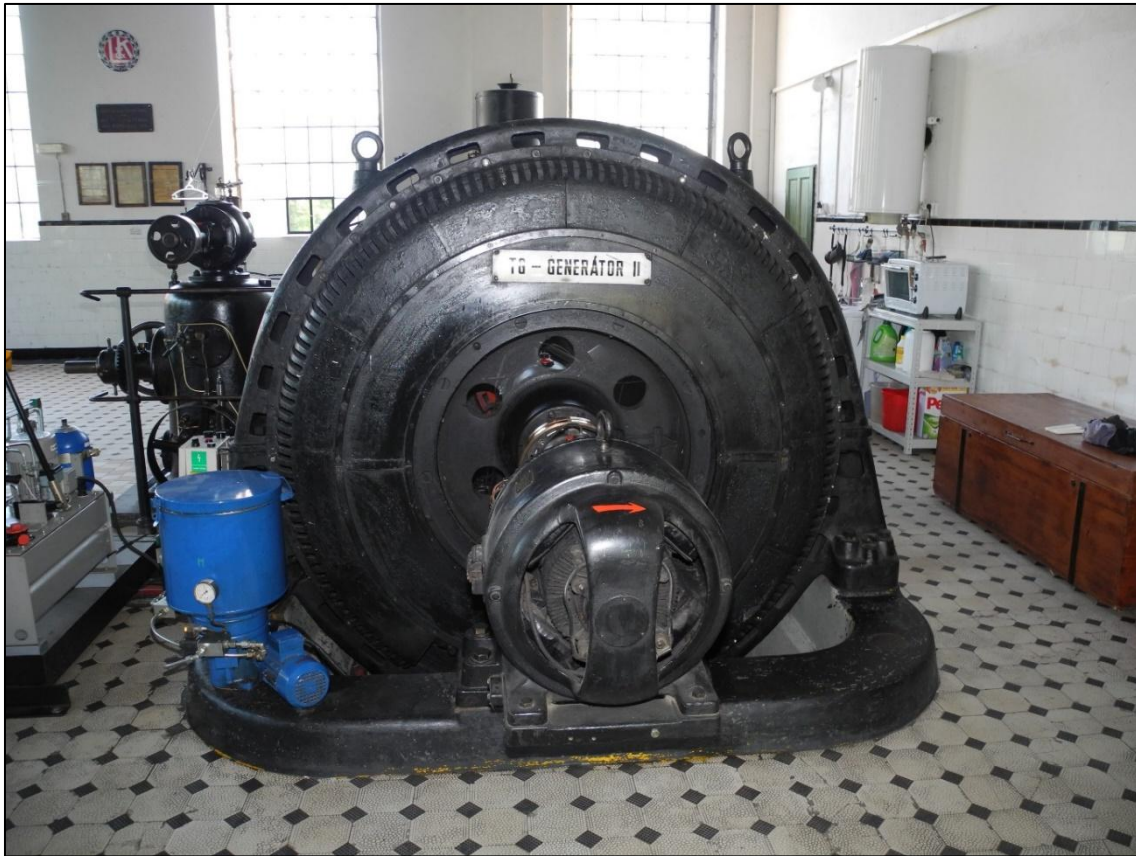
Obrázek 111. Generátor II o výkonu 510 kVA s budičem, obojí výroby František Křížík a. s. Foto Jiří Chmelenský, 2015.
