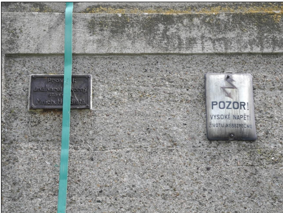
Obrázek 288. Detail dochované tabulky stavební firmy Ing. Karla Pokorného, stavitele z Mnichova Hradiště (vlevo) a původní tabulky varování před úrazem vysokým napětím (vpravo). Foto Jiří Chmelenský, 2015.
