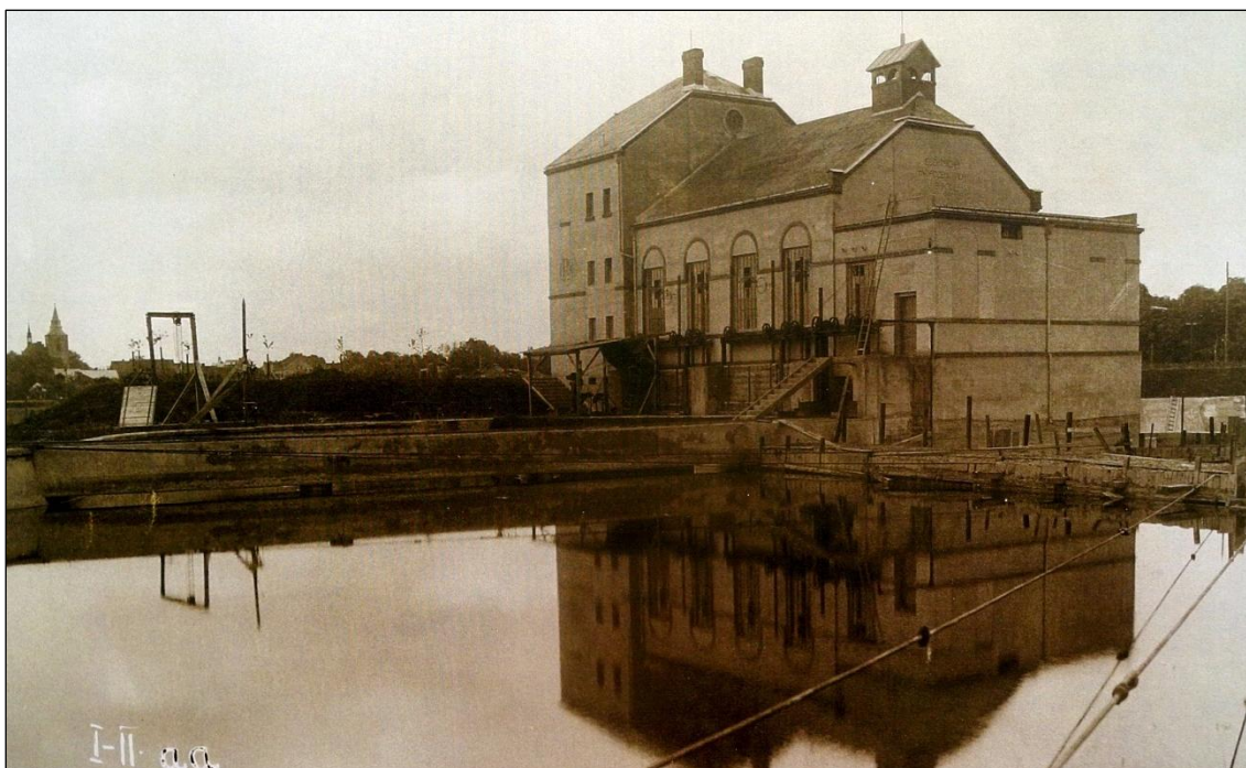
Obrázek 125. MVE Bakov nad Jizerou v průběhu stavby v roce 1922. Pohled od Malé Bělé, vlevo patrná věž kostela v Bakově.
