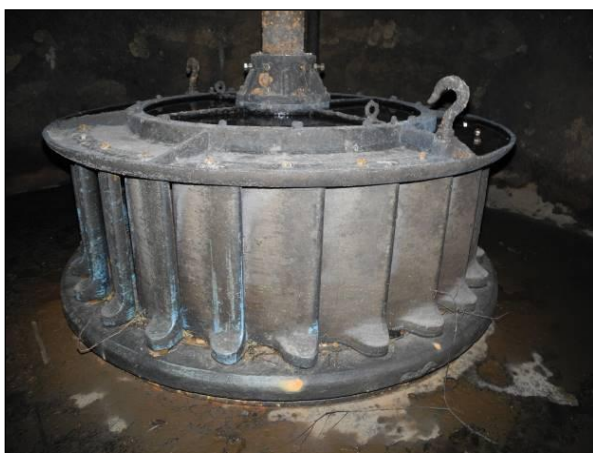
Obrázek 39. Francisova vertikální turbína ukrytá pod uzavřenými regulačními lopatkami. Nahoře je patrná hřídel turbíny, vodící ložisko, pak víko turbíny (štít) s manipulačními háky, dále uzavřené regulační lopatky a regulační kruh. MVE Bakov nad Jizerou (okr. Mladá Boleslav). Foto Jiří Chmelenský, 2015.
