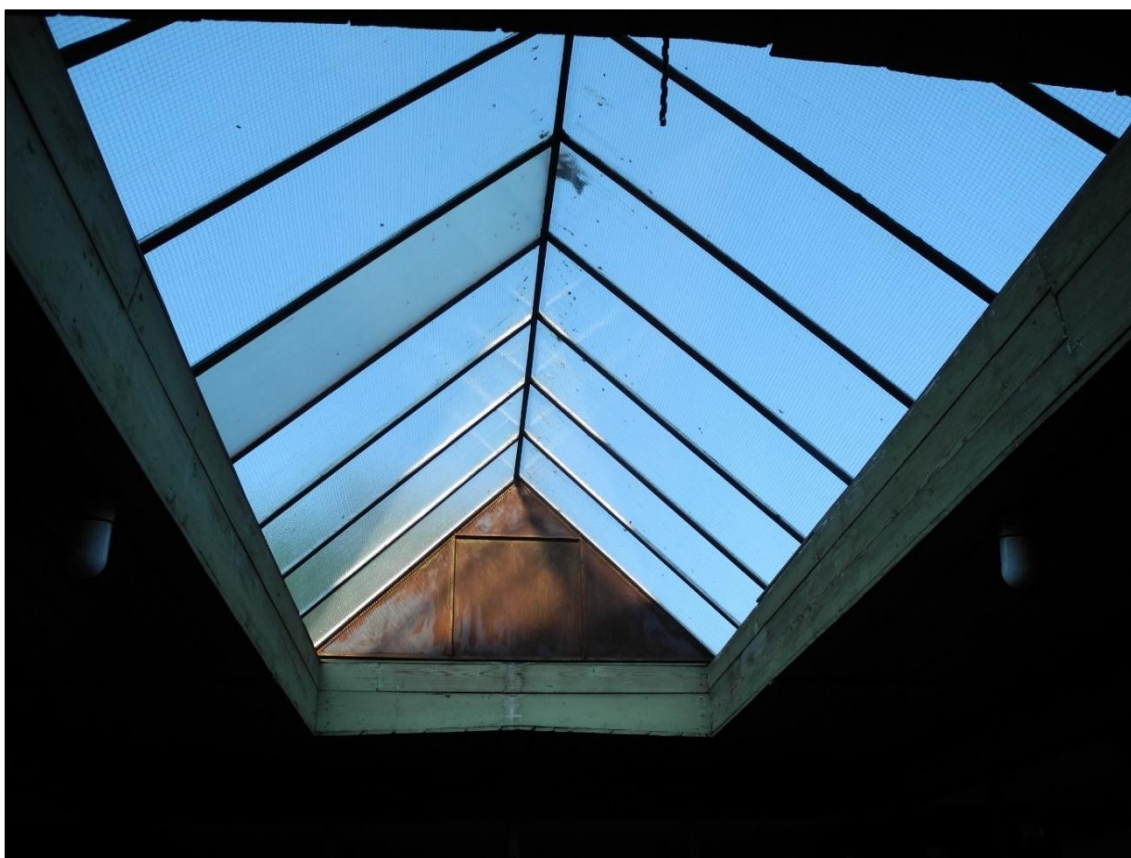
Obrázek 179. Detail prosklené stanové střechy vrchního patra rozvodny. Foto Jiří Chmelenský, 2015.
