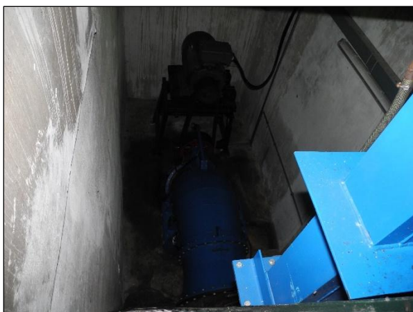
Obrázek 41. Pohled do kašny MVE Hněvousice (okr. Mladá Boleslav). Tato doplňková MVE byla postavena na přepadovém kanálu staré MVE. V kašně je osazena moderní Kaplanova horizontální turbína o výkonu 110 kW od firmy Hydrohrom.* Foto Jiří Chmelenský, 2015.
