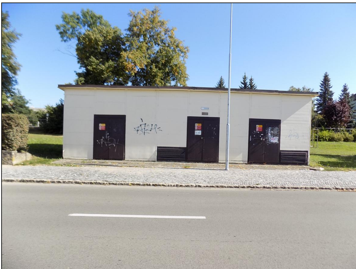
Obrázek 302. Pohled na severní stěnu rozvodny Bakov nad Jizerou v Husově ulici. Foto Jiří Chmelenský, 2016.
