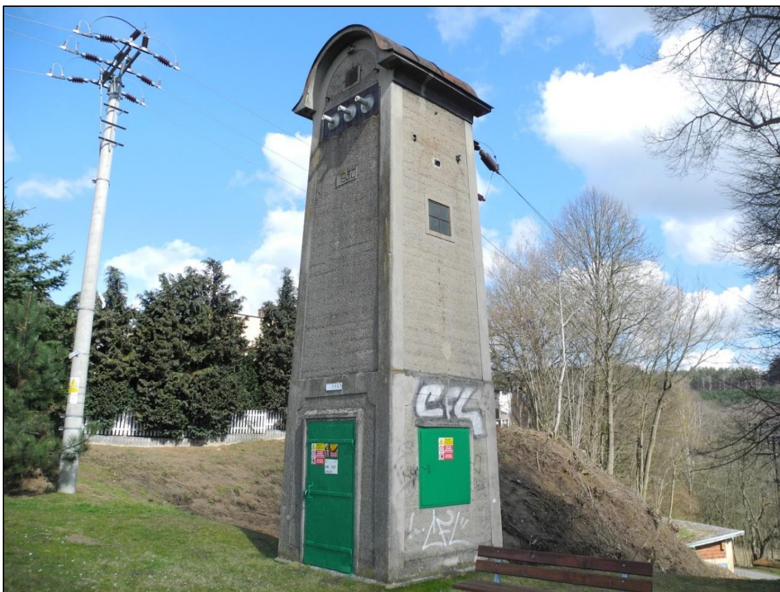
Obrázek 268. Trafostanice Mukařov dochovaná v téměř původním stavu. Byly vyměněny dvířka rozvaděče. Foto Jiří Chmelenský, 2015.
