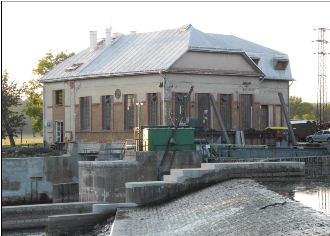
Obrázek 109. Pohled na MVE Haškov. Vpředu pevný jez o délce záplavy 67,05 m, následuje 15 m pokloповý jez a dvoje česle turbín včetně automatického shrabovacího mechanismu. Foto Jiří Chmelenský, 2015.
