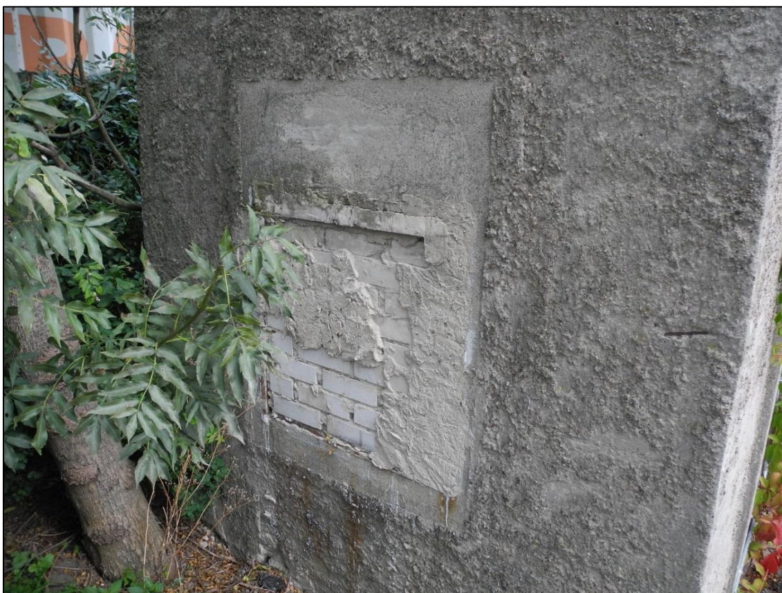
Obrázek 236. Detail zazděného otvoru původního rozvaděče. Foto Jiří Chmelenský, 2015.
