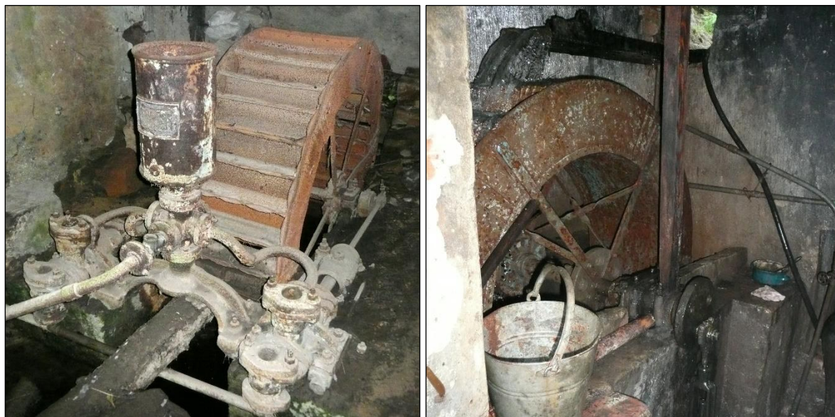
Obrázek 28. Moderní ocelové kolo na spodní vodu (Ponceletova) vodárny Proschenský (Proseč, okr. Liberec). Rok výroby 1895 Josefem Gatterem z Kuřívod, konec provozu po roce 1945. Foto Jiří Chmelenský, 2012.
