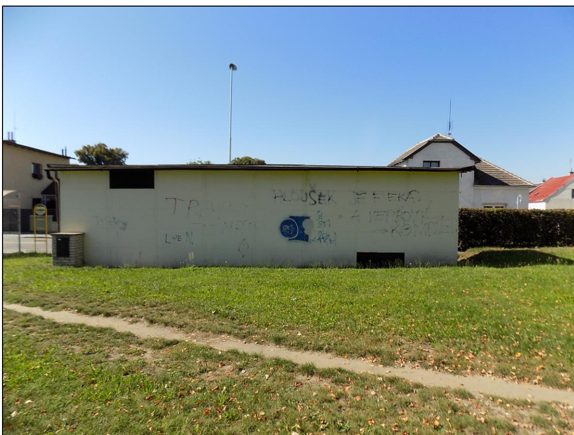
Obrázek 303. Pohled na jižní stěnu rozvodny Bakov nad Jizerou v Husově ulici. Foto Jiří Chmelenský, 2016.
