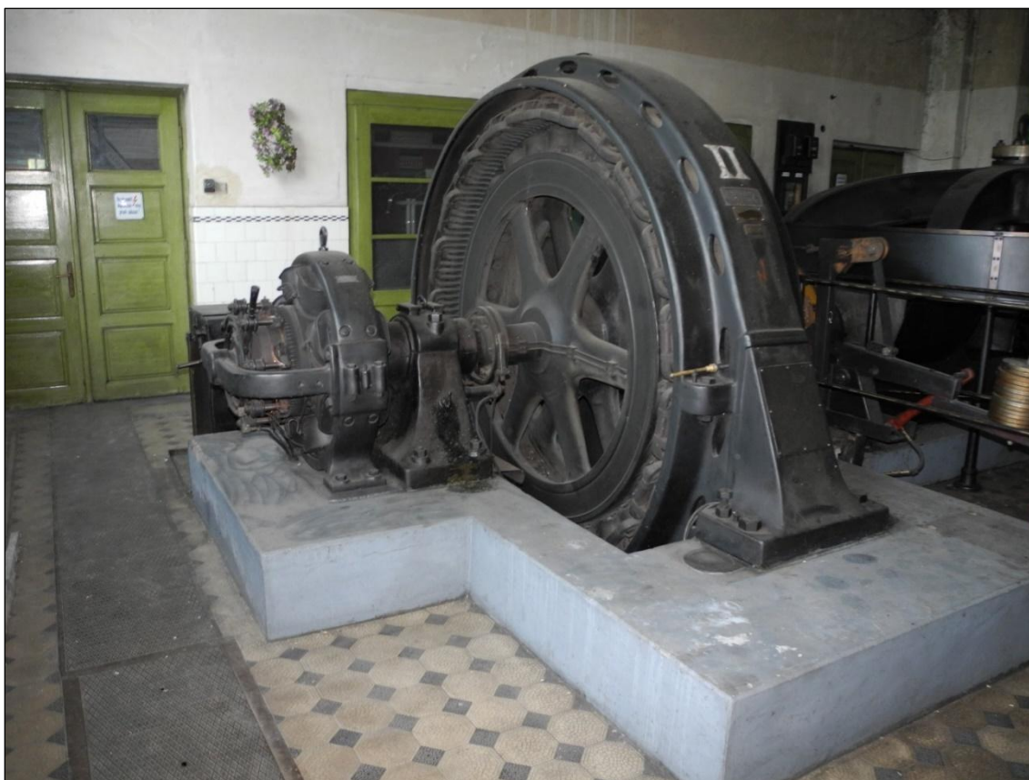
Obrázek 162. Kosý pohled na generátor II od firmy SIEMENS SCHUCKERT WId 175/214 o výkonu 214 kW opatřený budičem, zvonovým kolem a regulací Francisovy turbíny od firmy Josef Prokop a synové. Foto Jiří Chmelenský, 2015.
