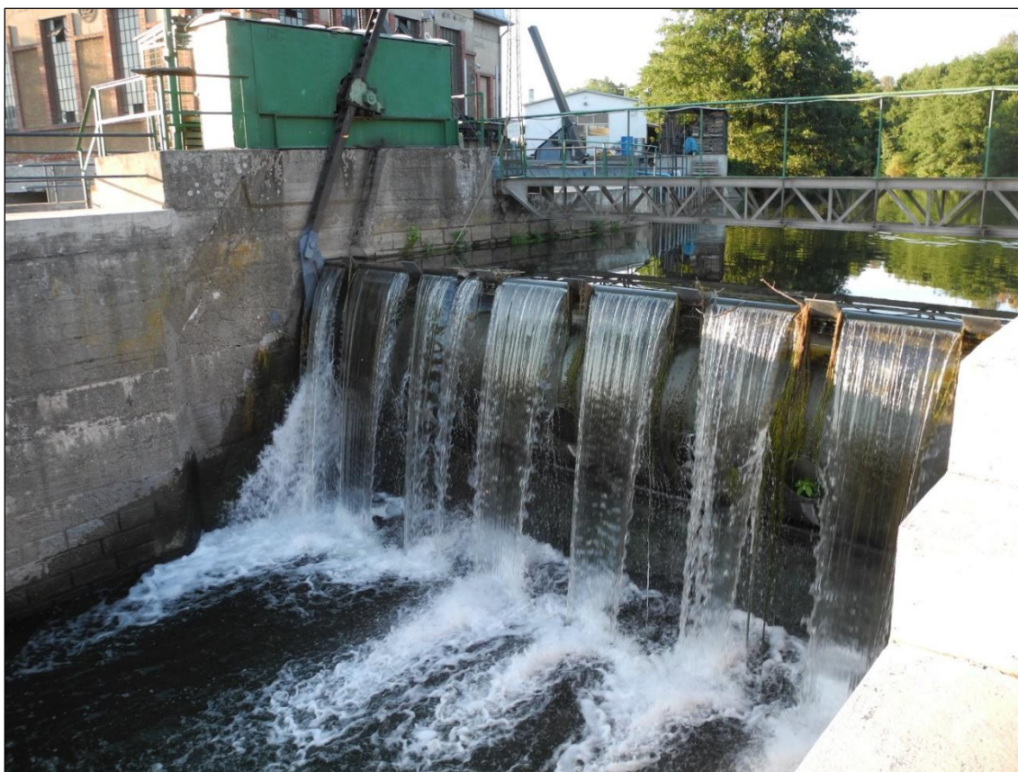
Obrázek 121. Sklopný segmentový jez o šířce 15 m a výšce 1,25 m. Foto Jiří Chmelenský, 2015.
