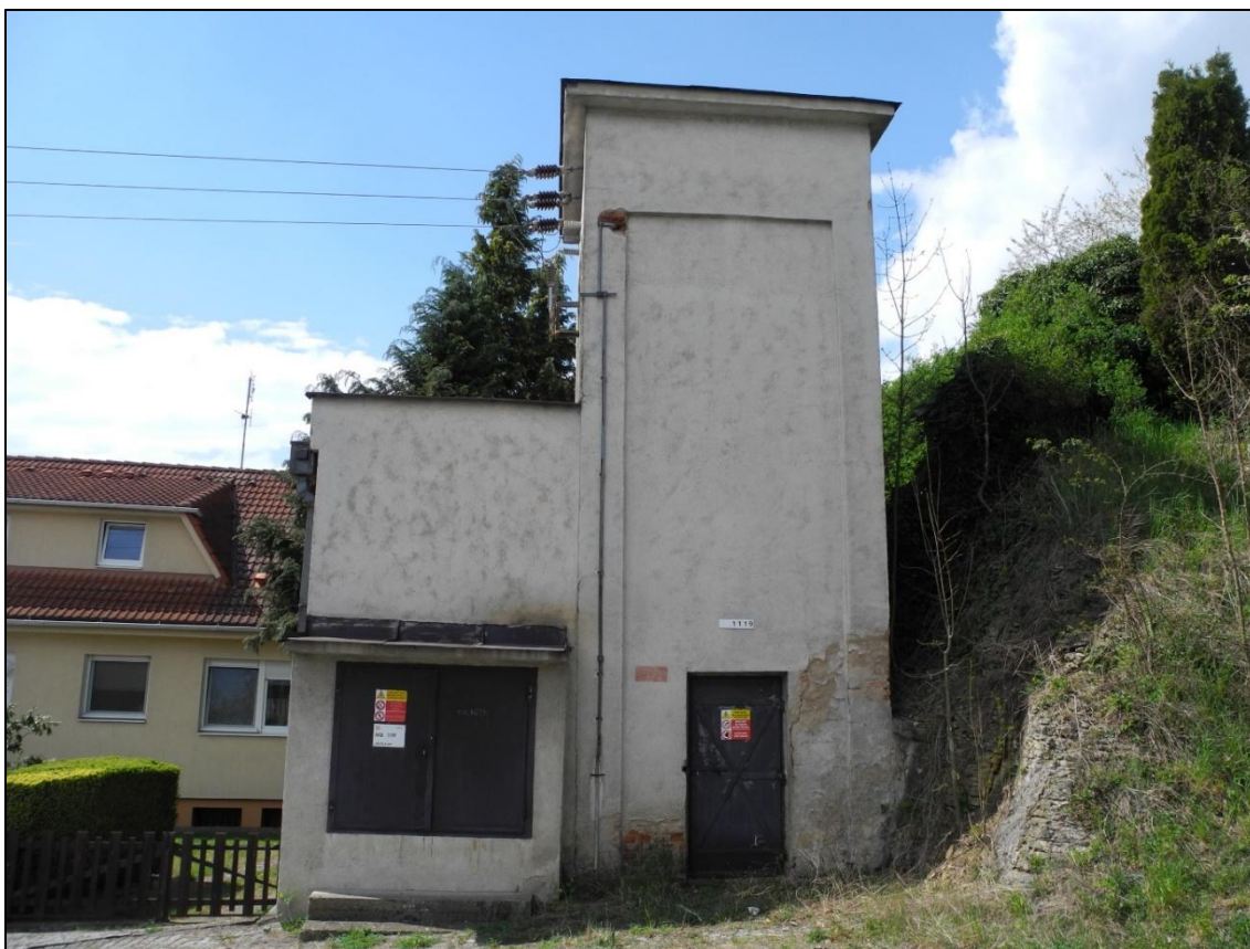
Obrázek 293. Trafostanice Bakov. n. J. Rybničná ulice. Patrná je nepřívodní přístavba vlevo. Foto Jiří Chmelenský, 2015.
