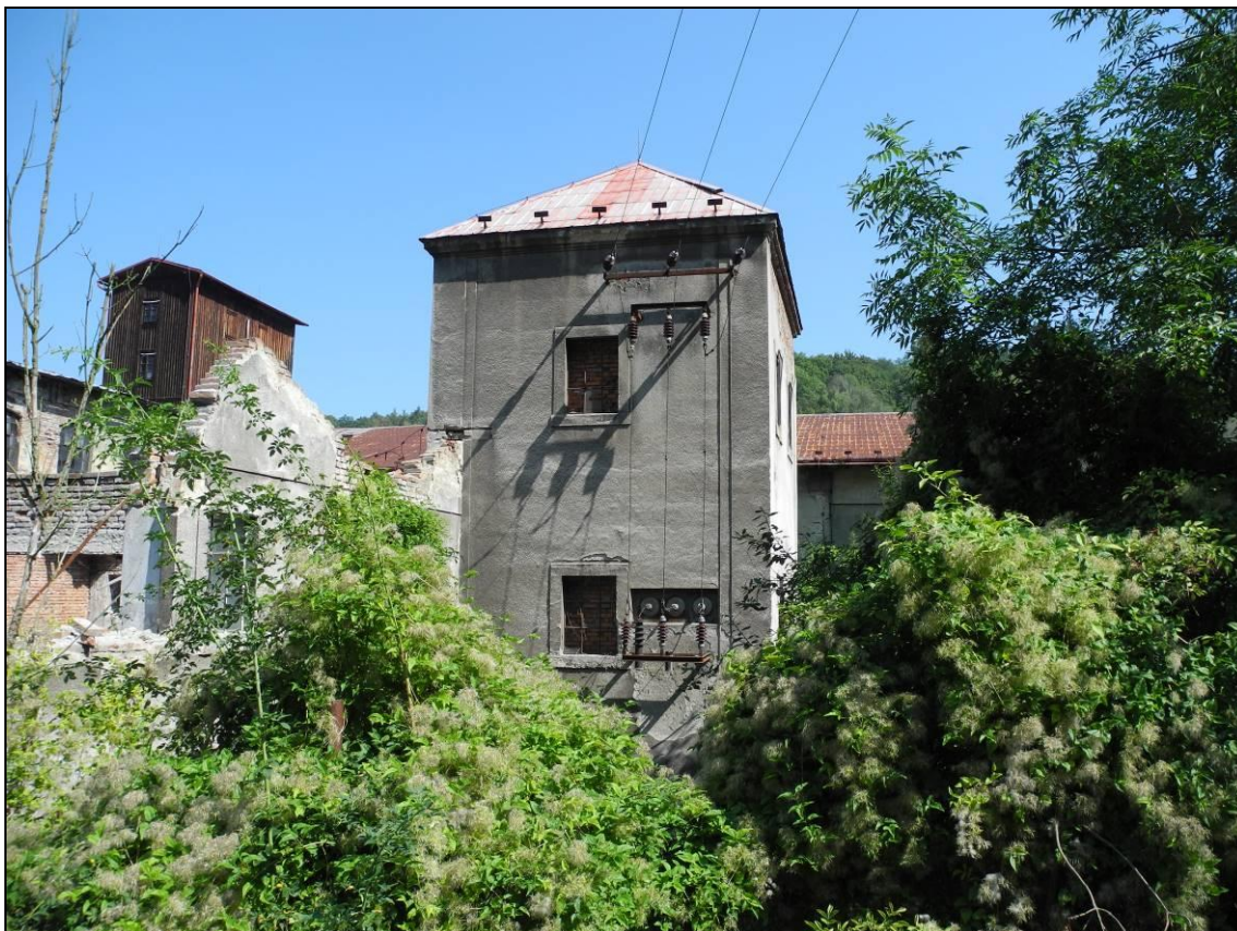
Obrázek 226. Trafostanice/rozvodna Dolní Cetno cukrovar. Foto Jiří Chmelenský, 2015.
