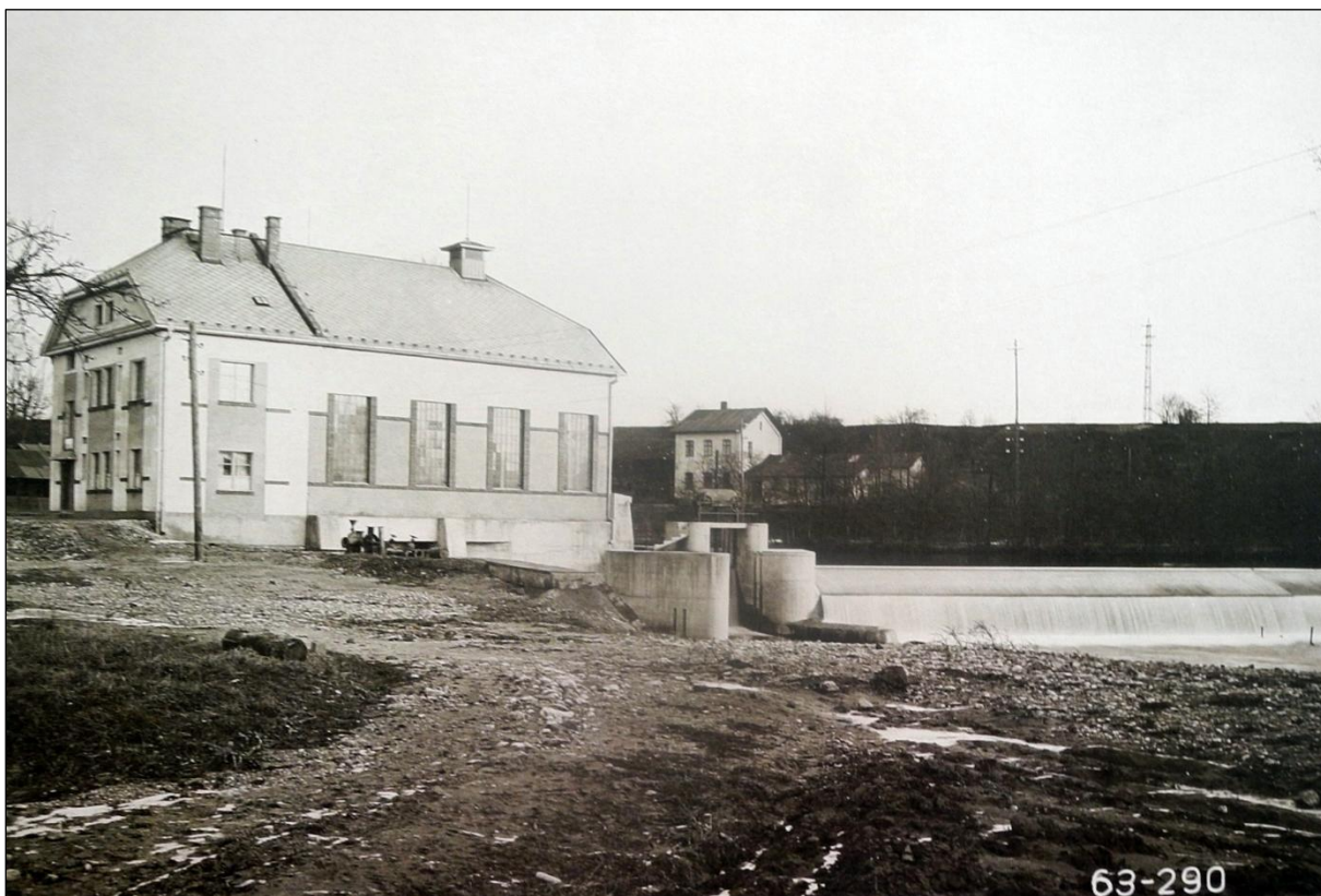
Obrázek 102. Pohled na MVE Haškov od západu. Patrná je správní a obytná část elektrárny, strojovna, sklopný jez a pevný jez. Zdroj: Archiv Škoda Auto a. s. Mladá Boleslav, Mladá Boleslav, f. Laurin & Klement, k. 51 Elektrárny Haškov, Haškov Fotografie Plány, 63-290.
