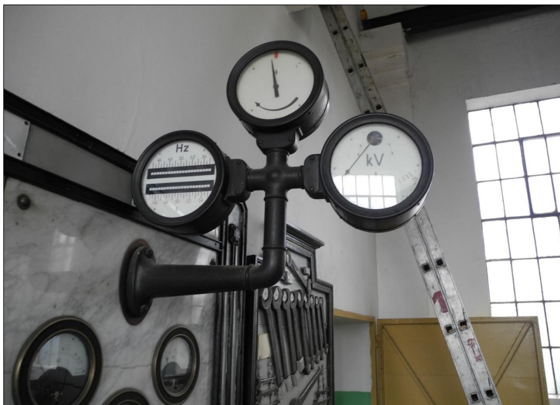
Obrázek 138. Detail měřáku frekvence v Hz vlevo a napětí kV vpravo, nahoře neidentifikovaný měřák. Foto Jiří Chmelenský, 2015.
