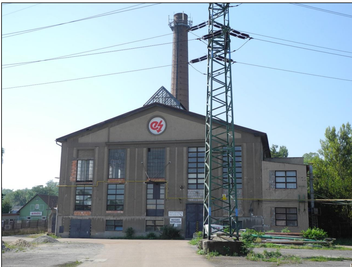
Obrázek 204. Pohled od východu na budovu parní elektrárny Dražice. Dnes sloužící jako opravna elektromotorů. Foto Jiří Chmelenský, 2015.
