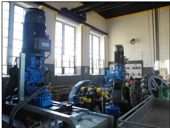
Obrázek 55. Moderní současné vertikální generátory firmy Flender typu H2VW 12, čísla 4254935 o výkonu 200 kW s cizím buzením. MVE Hněvousice u Mnichova Hradiště. Foto Jiří Chmelenský, 2015.
