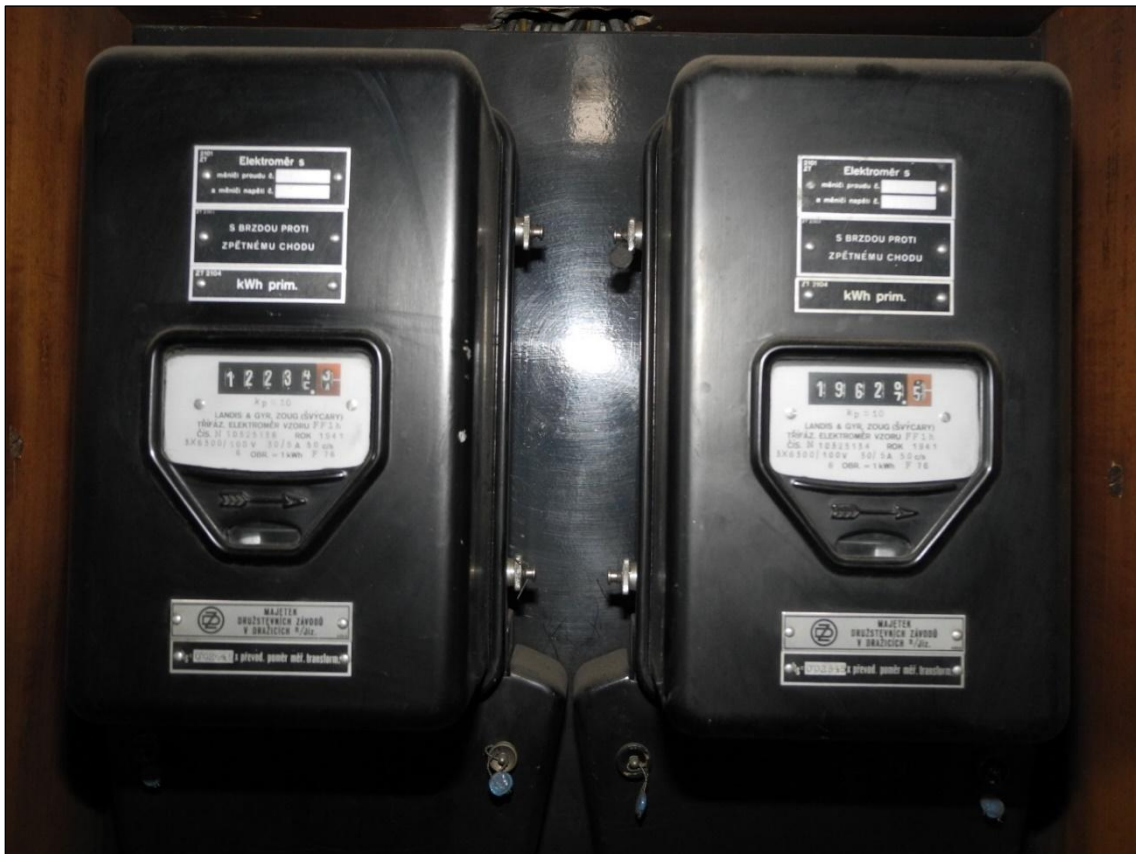
Obrázek 181. Elektroměry místní spotřeby výroby DZD. Foto Jiří Chmelenský, 2015.
