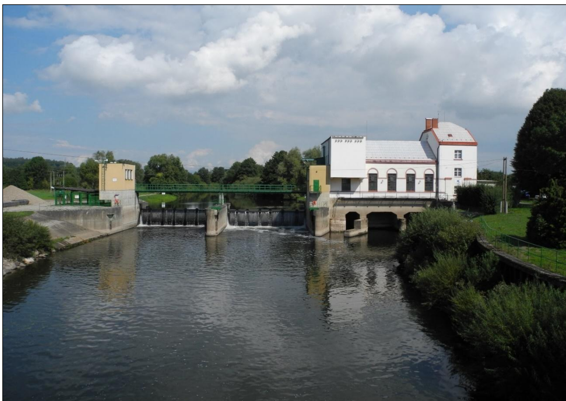
Obrázek 131. Celkový pohled na MVE Bakov od jihu. Oproti předchozímu záběru je zde kompletní vodní dílo. Tj. zleva strojovna jezového pole, lávka, středový pilř, druhá strojovna jezového pole a samotná MVE. Foto Jiří Chmelenský, 2015.
