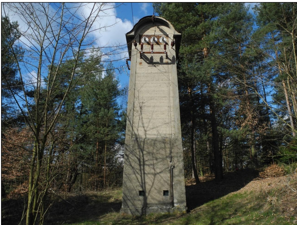
Obrázek 290. Trafostanice Strážiště. Foto Jiří Chmelenský, 2015.
