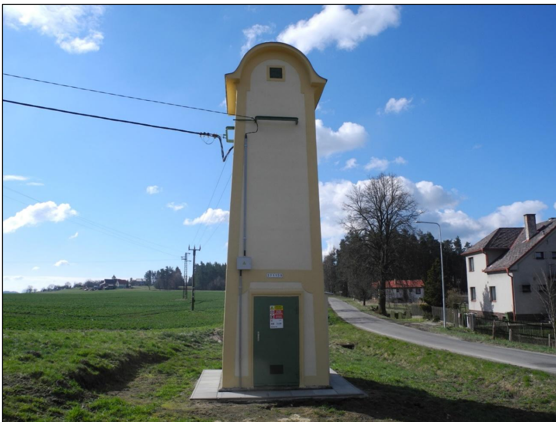
Obrázek 277. Trafostanice Ouč po vzorné opravě. Foto Jiří Chmelenský, 2015.
