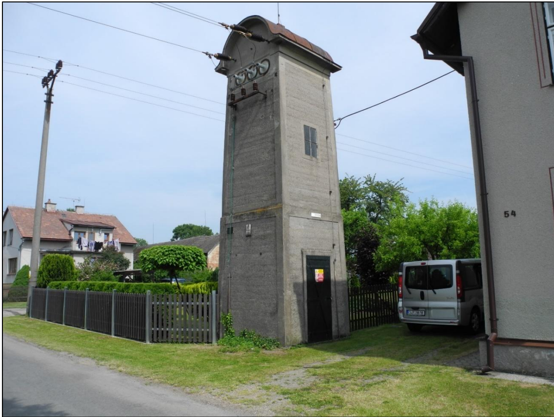
Obrázek 287. Trafostanice Sezemice je přímo ukázkově dochovaná v téměř původním stavu. Foto Jiří Chmelenský, 2015.
