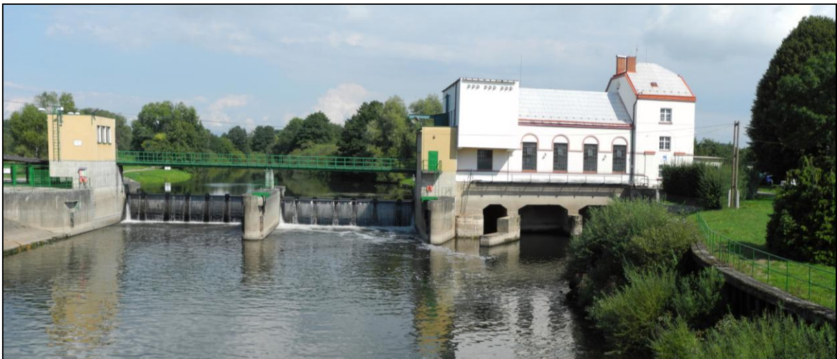
Obrázek 21. MVE Bakov nad Jizerou. Příklad jezového díla. Vpravo MVE, vývařišti turbín, odpadní kanál a dvě jezová pohyblivá segmentová pole. Foto Jiří Chmelenský, 2015.
