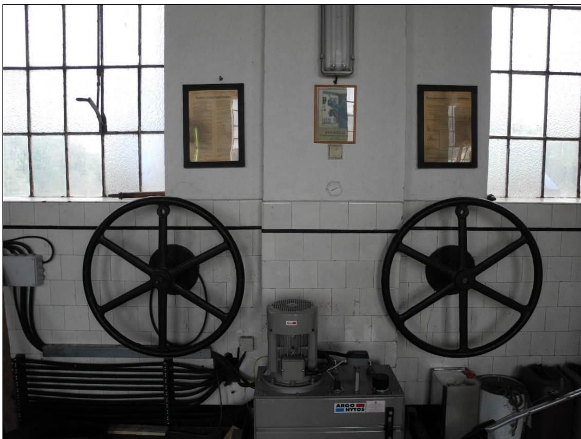
Obrázek 140. Detail ovládacích kol rychlouzávěru turbínových kašen. Foto Jiří Chmelenský, 2015.
