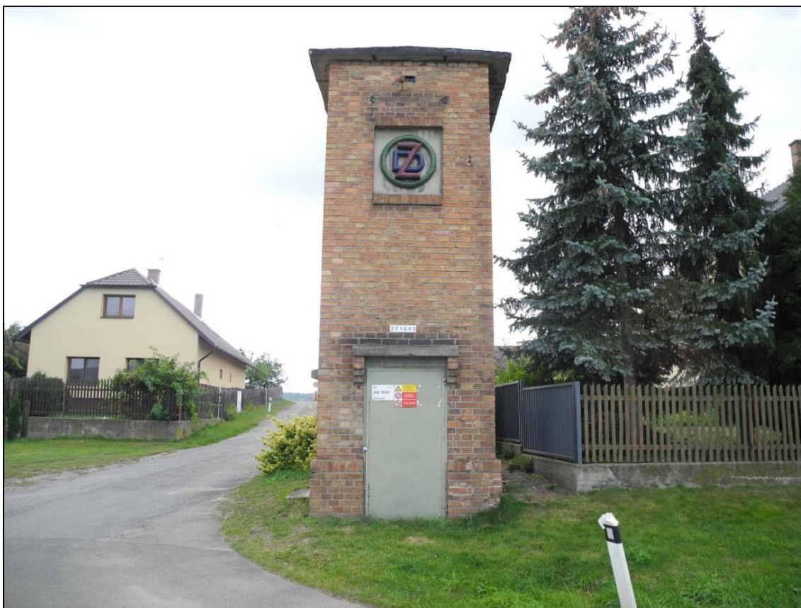
Obrázek 229. Trafostanice Dlouhá Lhota včetně loga DZD. Foto Jiří Chmelenský, 2015.
