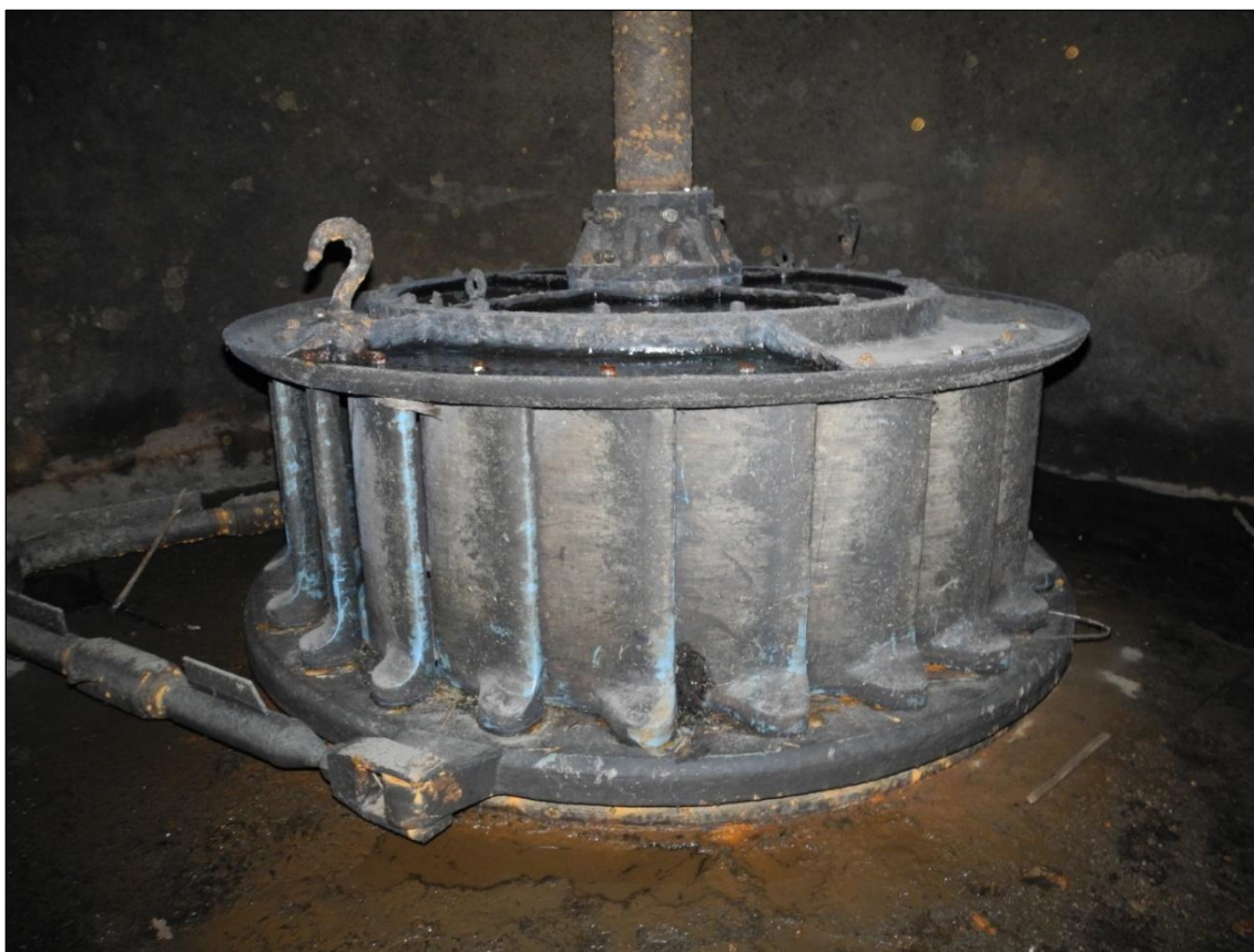
Obrázek 141. Francisova turbína v kašně 1. Pohled na zavřený regulační kryt, vlevo regulační táhla. Pohled po vodě. Foto Jiří Chmelenský, 2015.
