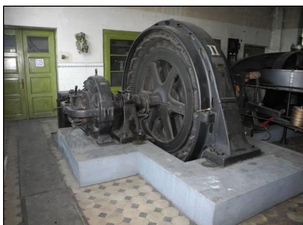
Obrázek 53. Horizontální generátor číslo II. s budičem (vlevo) MVE Rožátov u Mladé Boleslavi. Generátor výroby firmy Siemens-Schuckert, typu WId 175/214, číslo 76101 o výkonu 175 kVA. Budič výroby Siemens-Schuckert, typu W30, čísla 80922 o výkonu 5,4 kW. Konstrukce z roku 1918. Foto Jiří Chmelenský, 2015.
