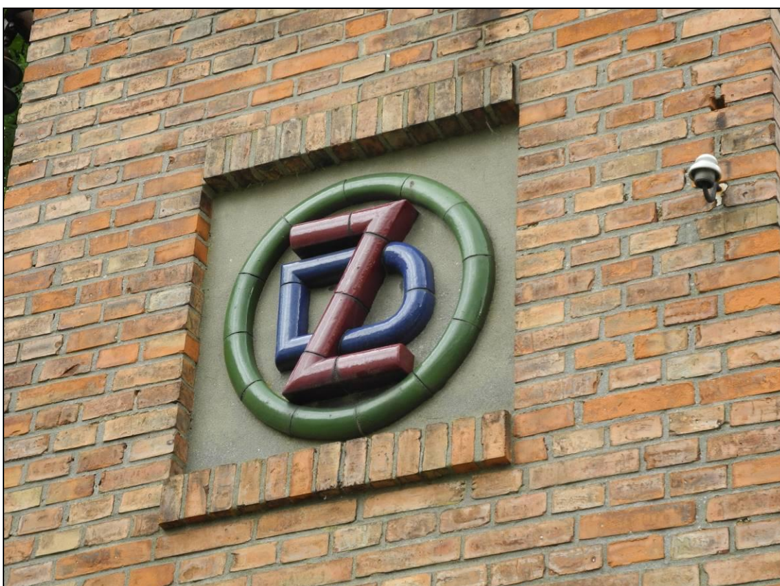
Obrázek 239. Logo DZD na trafostanici Hrušov. Foto Jiří Chmelenský, 2015.
