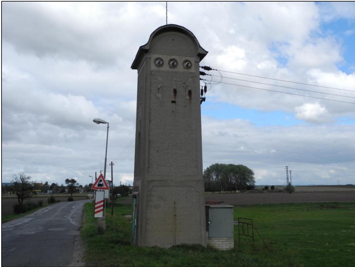
Obrázek 250. Trafostanice typ L&K v Kolomutech. Dobře patrné jsou zachovalé původní porcelánové průchodky vn, datované 1924 nad nimi a pod průchodkami stopy po odstraněné konzoli výstupního nn. Foto Jiří Chmelenský, 2015.
