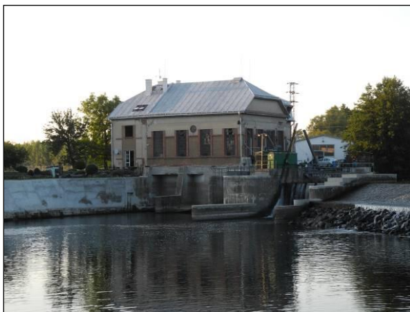
Obrázek 13. Pohled proti vodě na MVE Haškov u Mnichova Hradiště. Pod elektrárnou patrný odpadní kanál, jezové pohyblivé pole a vpravo pevný kamenný jez. Foto Jiří Chmelenský, 2015.
