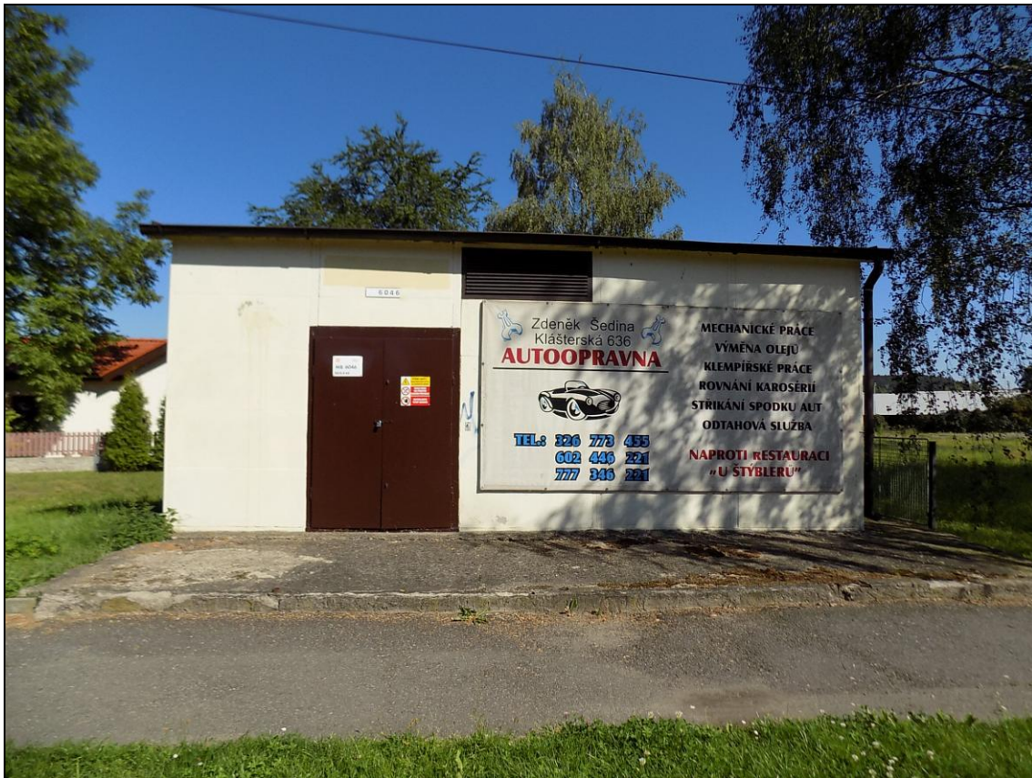
Obrázek 305. Rozvodna Mnichovo Hradiště, pohled na západní stěnu rozvodny. Foto Jiří Chmelenský, 2016.
