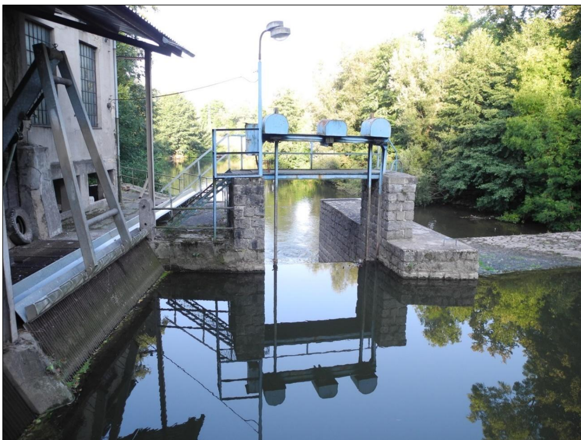
Obrázek 159. Pohled od východu na jalový přepad a jemné česle (vlevo) vybavené shrabovacím zařízením. Foto Jiří Chmelenský, 2015.
