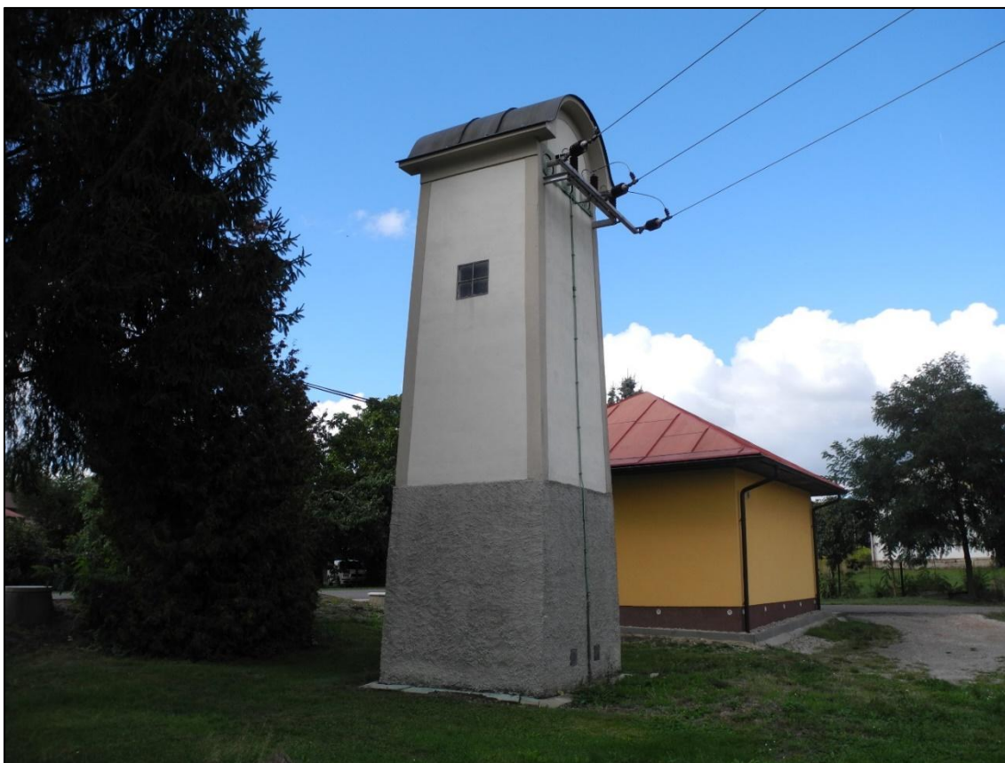
Obrázek 247. Opravená omítka trafostanice Husí Lhota. Foto Jiří Chmelenský, 2015.
