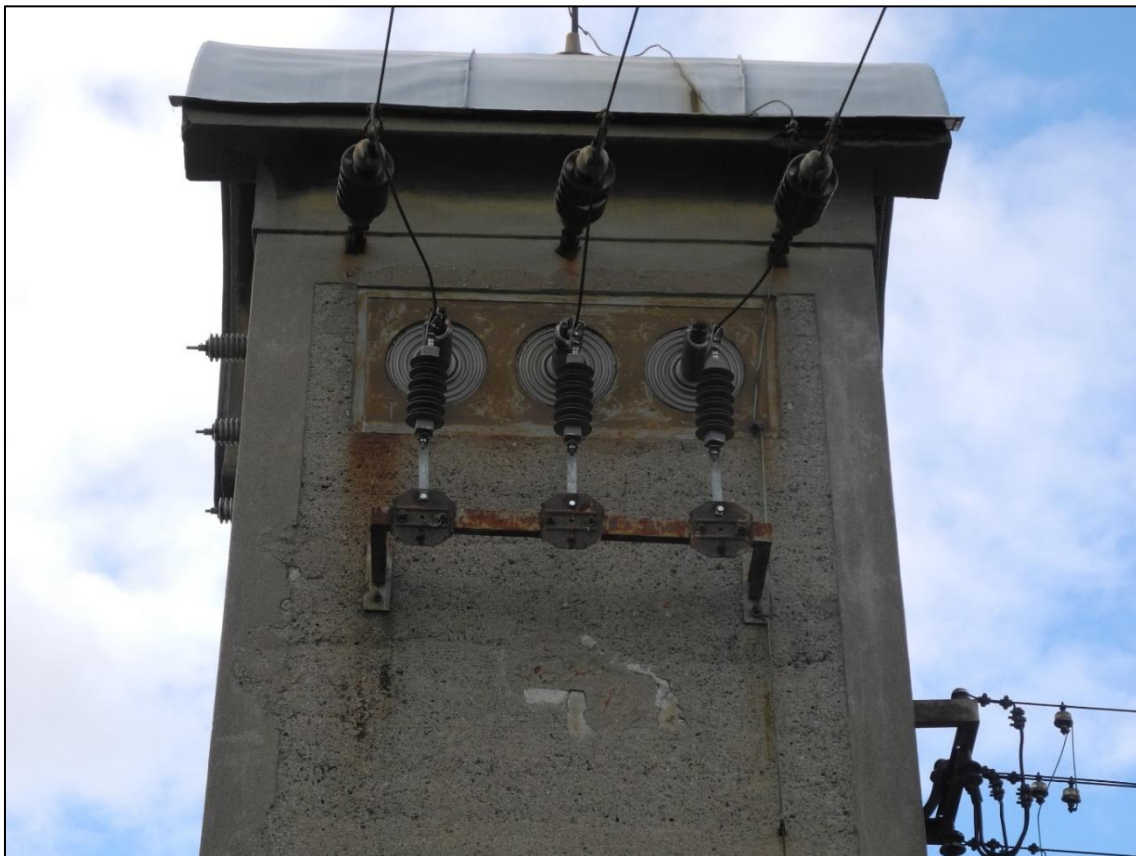
Obrázek 251. Druhotně změněné (nové) průchodky vn. Foto Jiří Chmelenský, září 2015.
