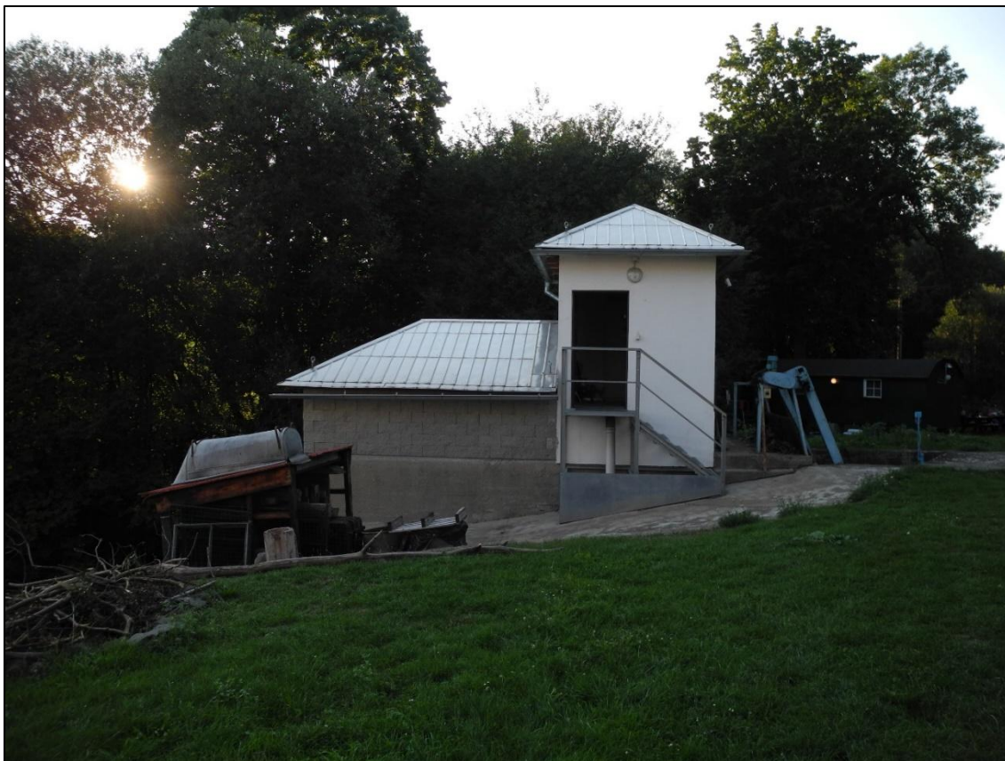
Obrázek 99. Dnešní turbína postavená na přepadovém kanále MVE Hněvousice. Foto Jiří Chmelenský, 2015.
