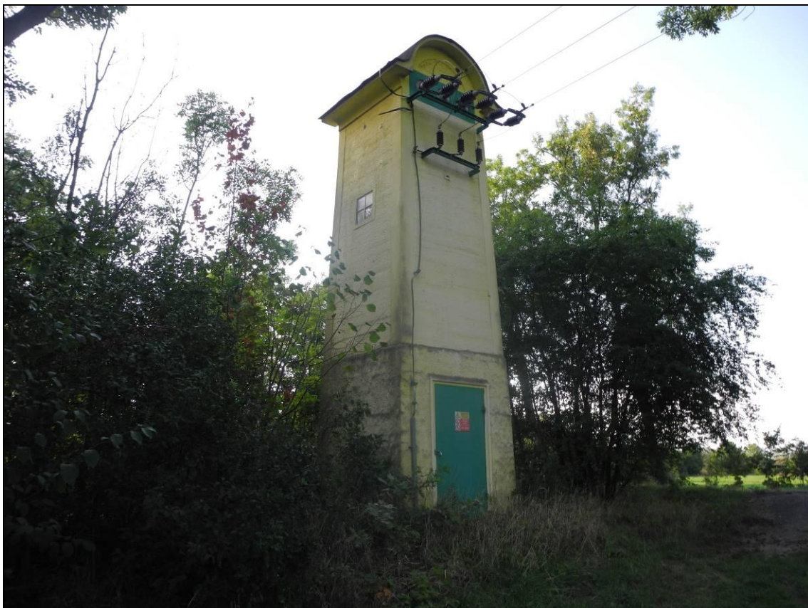
Obrázek 244. Trafostanice Horka u Bakova nad Jizerou. Rekonstruovaný objekt, omítnutý, nové vstupní dveře i dvířka rozvaděče. Foto Jiří Chmelenský, 2015.
