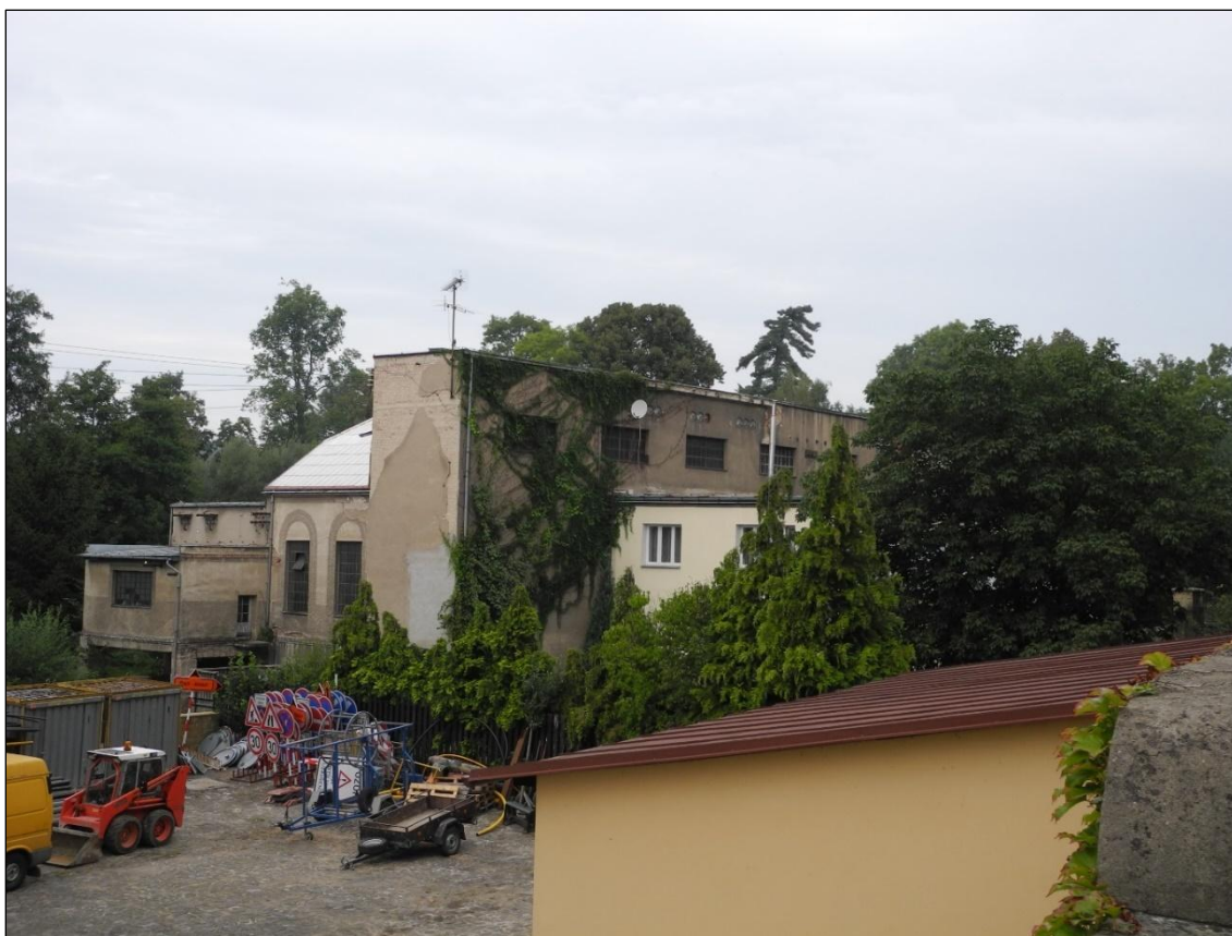
Obrázek 153. Pohled na MVE Rožátov od jihovýchodu. Přístavba rozvodny 22 kV zastiňuje strojovnu elektrárny, vlevo rozvodna 6,3 kV. Foto Jiří Chmelenský, 2015.
