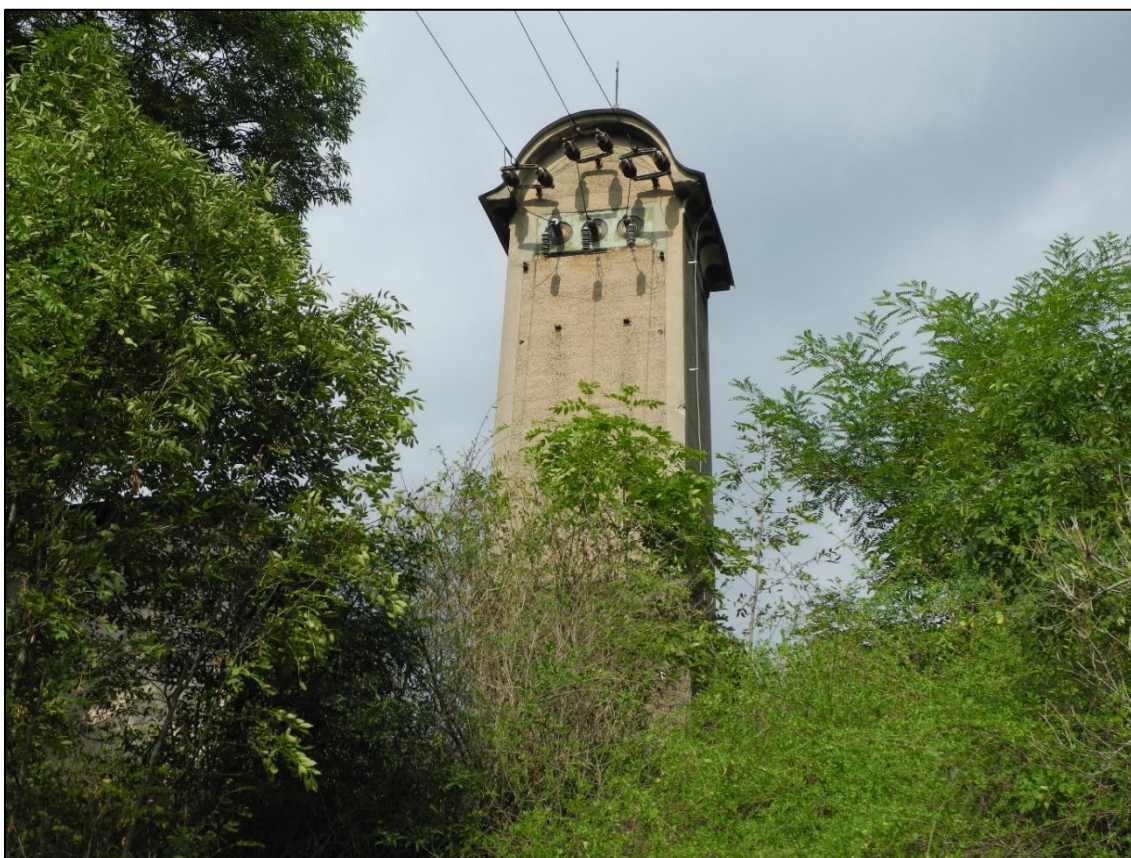
Obrázek 212. Trafostanice Bakov n. J. pohled na vstupy vn. Foto Jiří Chmelenský, 2015.
