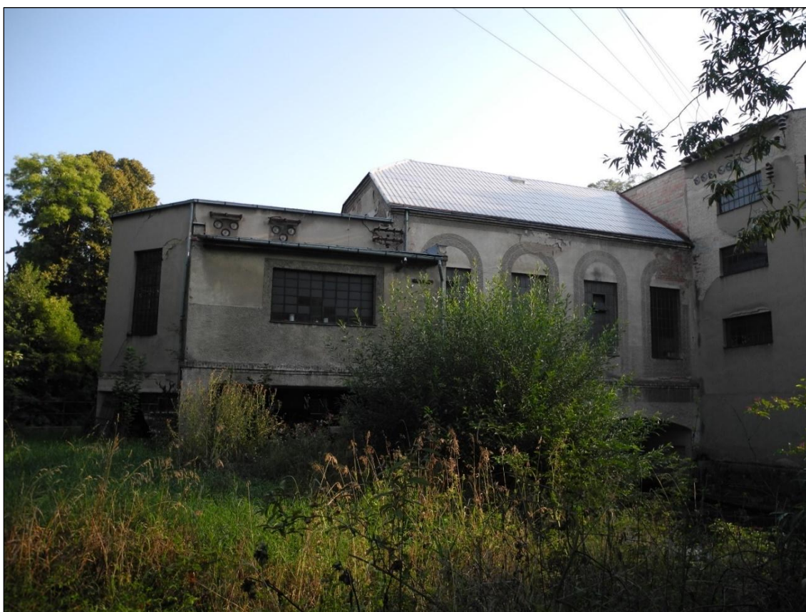
Obrázek 157. Pohled na přístavbu rozvodny 6,3 kV, uprostřed strojovna, vpravo rozvodna 22 kV. Pohled od jihozápadu. Foto Jiří Chmelenský, 2015.
