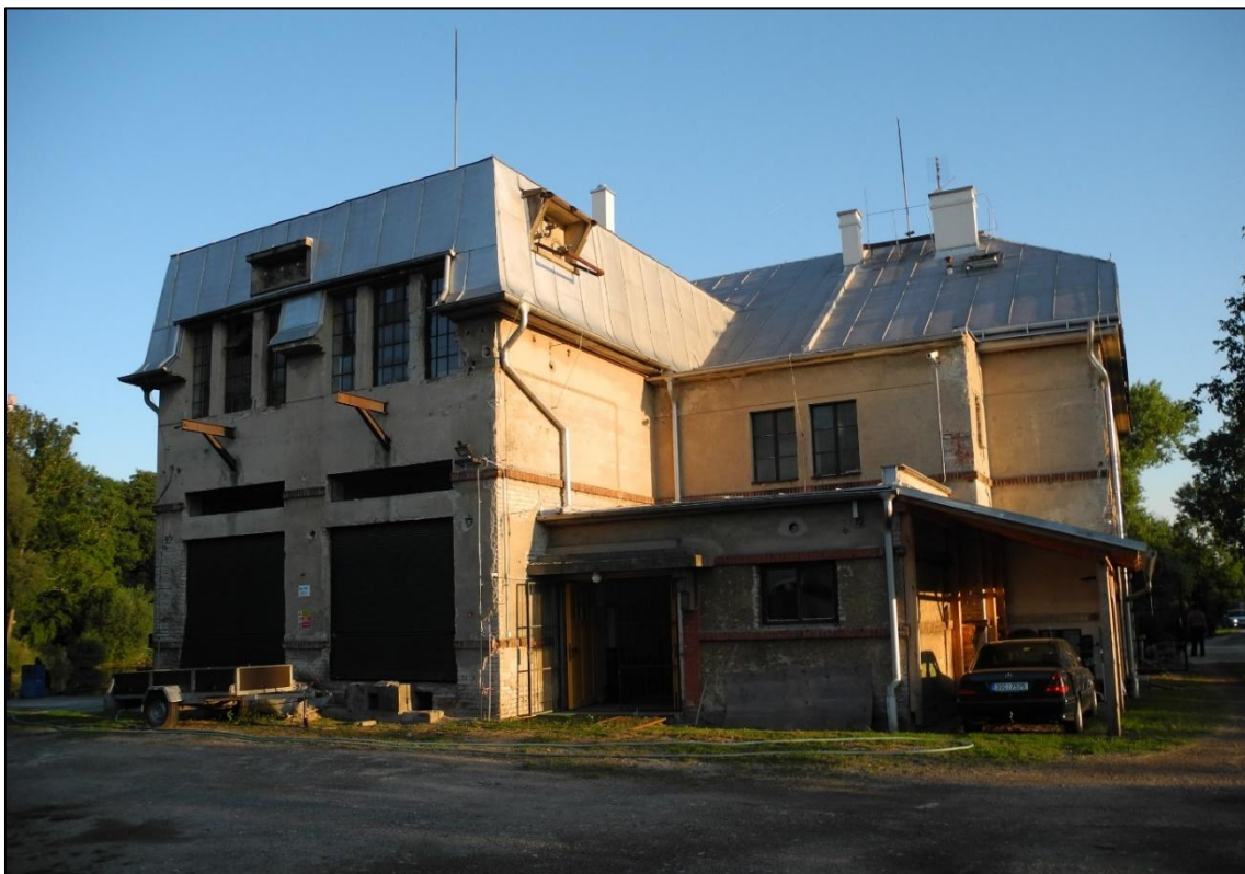
Obrázek 110. Pohled na MVE Haškov ze severozápadní strany. Vlevo jsou dobře patrné dvě plechové rolety vyvážecích otvorů transformátorů. Nad nimi je rozvodna 22 kV. Foto Jiří Chmelenský, září 2015.
