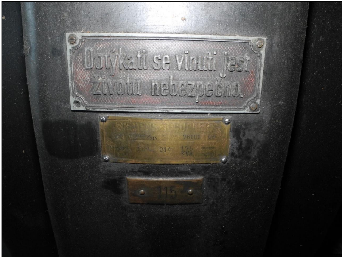
Obrázek 164. Štítek generátoru II od firmy SIEMENS SCHUCKERT WId 175/214 o výkonu 214 kW. Foto Jiří Chmelenský, 2015.
