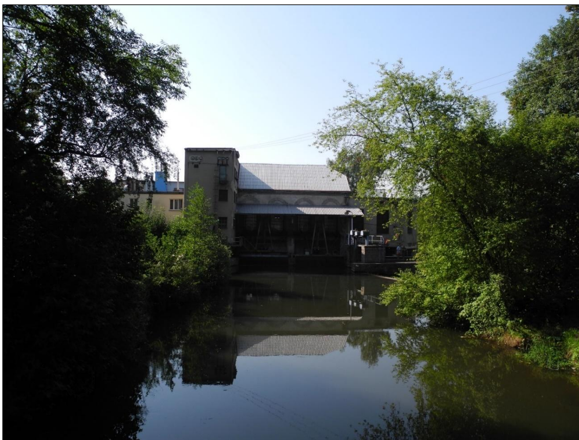
Obrázek 156. MVE Rožátov, pohled od severu. Náhon, jemné česle se shrabovacím zařízením, strojovna, vpravo rozvodna 6,3 kV. Vlevo rozvodna 22 kV. Foto Jiří Chmelenský, 2015.
