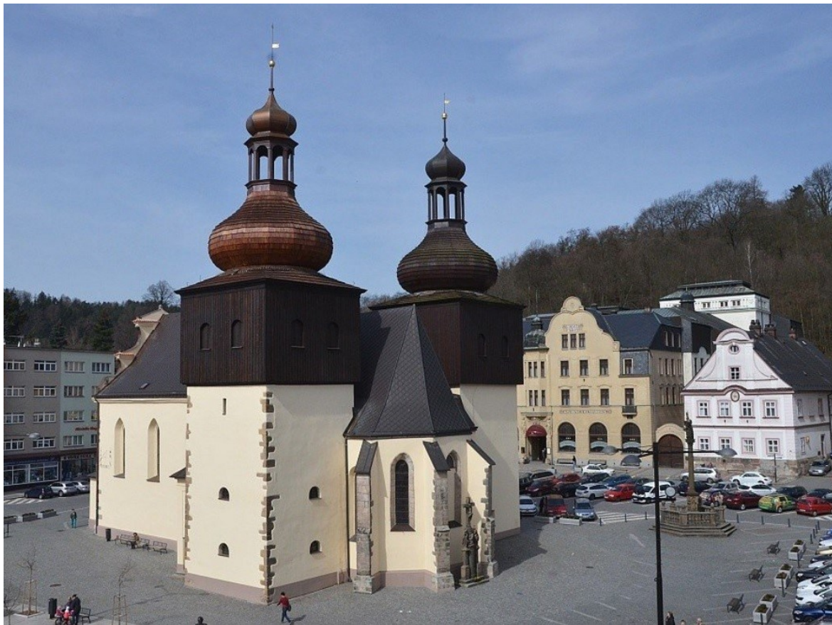
Kostel sv. Vavřince po rozsáhlých opravách. (Foto: DENÍK/Regina Hellová - 2016)
