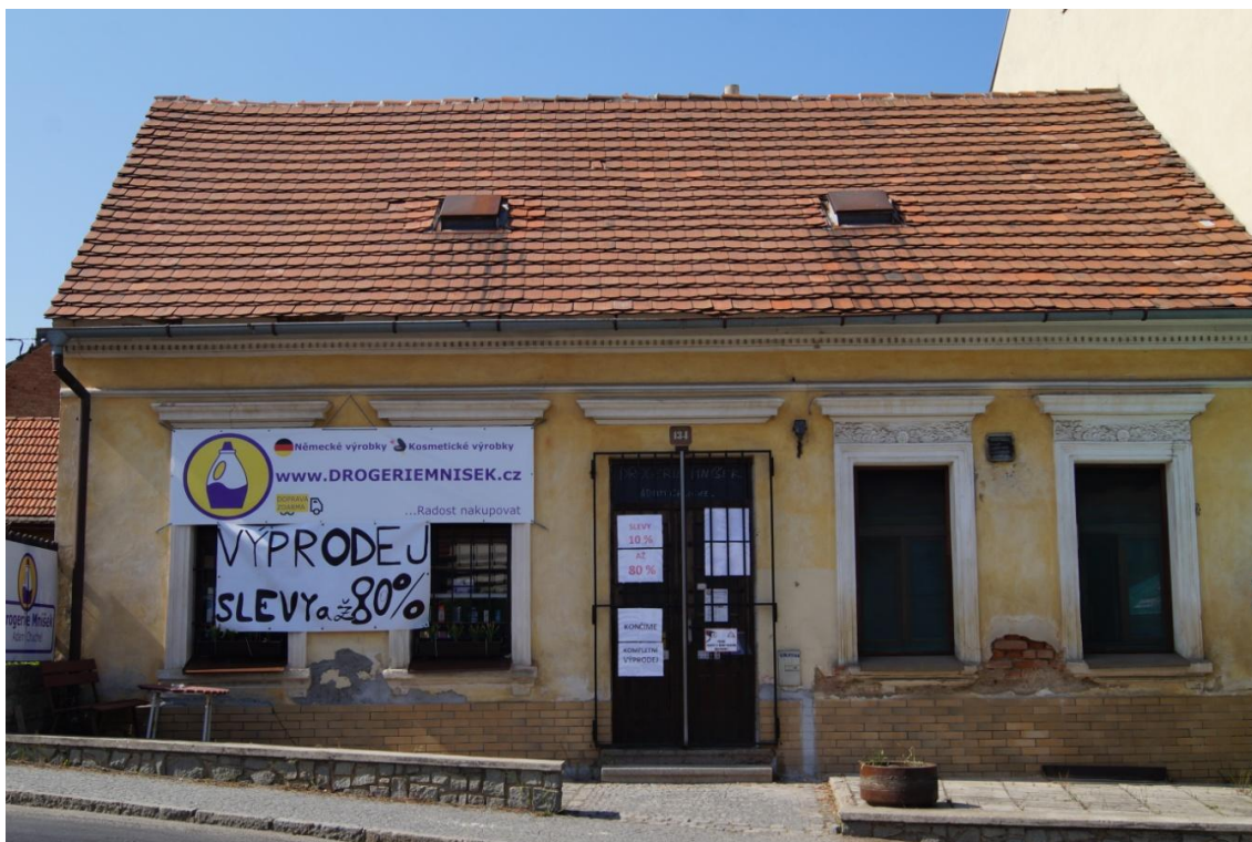
Obr. č. 48: Zde jsou reklamou zakryty významné architektonické prvky objektu.
