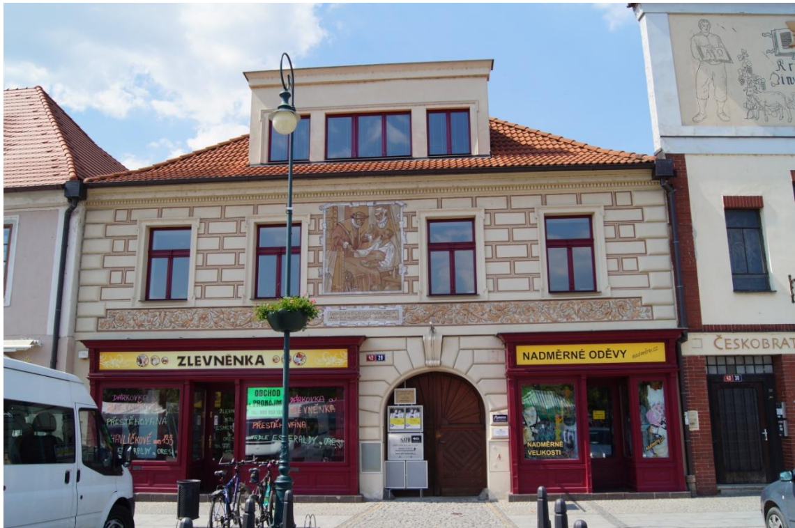
Obr. č. 7: V případě domu č. p. 42/29 by výkladce mohly lépe uzpůsobené vzhledu fasády.
