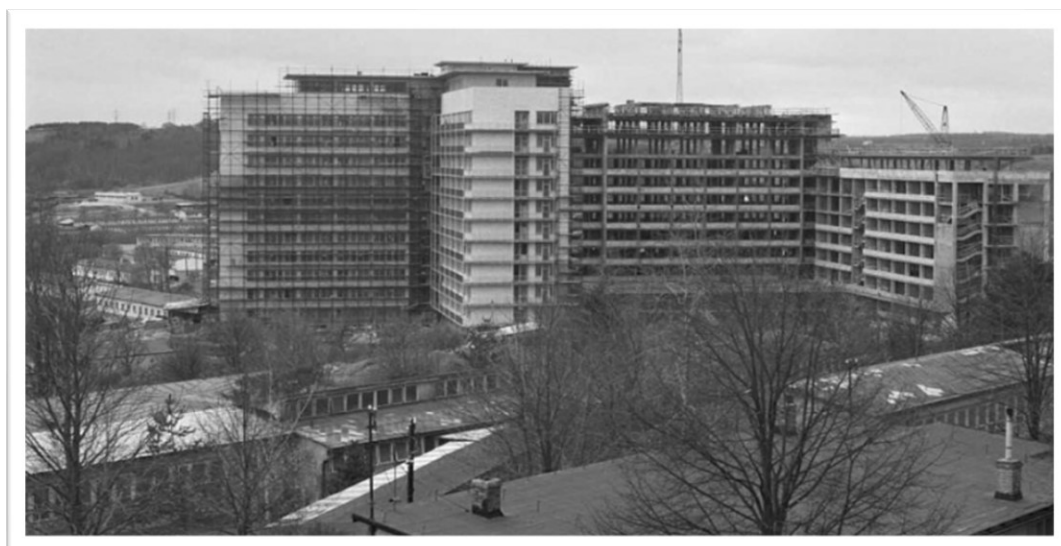
Obrázek č. 5: Výstavba motolské dětské nemocnice 2. 4. 1969
