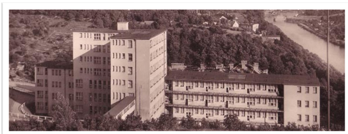
Obrázek č. 8: Infekční pavilon v roce 1947 – severní strana
