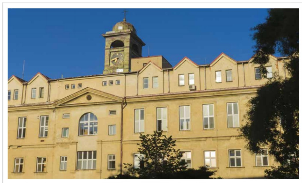
Obrázek č. 14: Současná budova Dermatologické kliniky Všeobecné fakultní nemocnice v Praze
