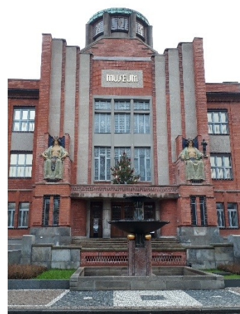
Secesní budova Musea východních Čech
