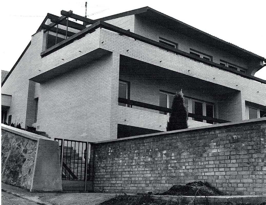
Exteriér vily „bonového krále“ Jozefa Zelíka v ulici Stará vinárska v Bratislavě (stav přibližně z roku 1982)
