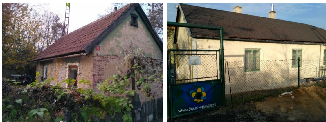
Obrázek č. 16: Pozměněné domky v kolonii Na Slatinách (vlevo) a Pod Bohdalcem (vpravo)
