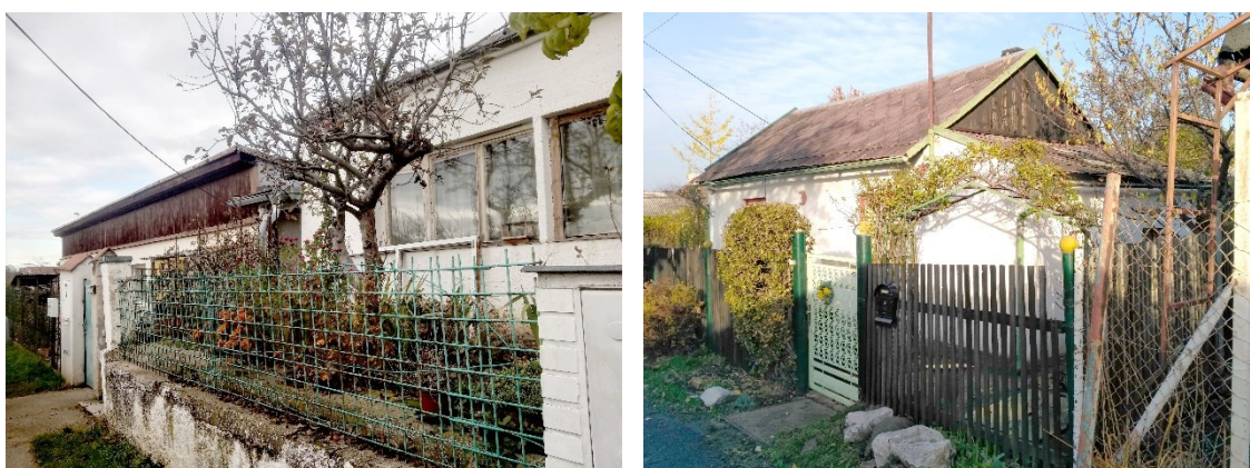
Obrázek č. 17: Domky v kolonii Na Kotlasce (vlevo) a Pod Bohdalcem (vpravo)
