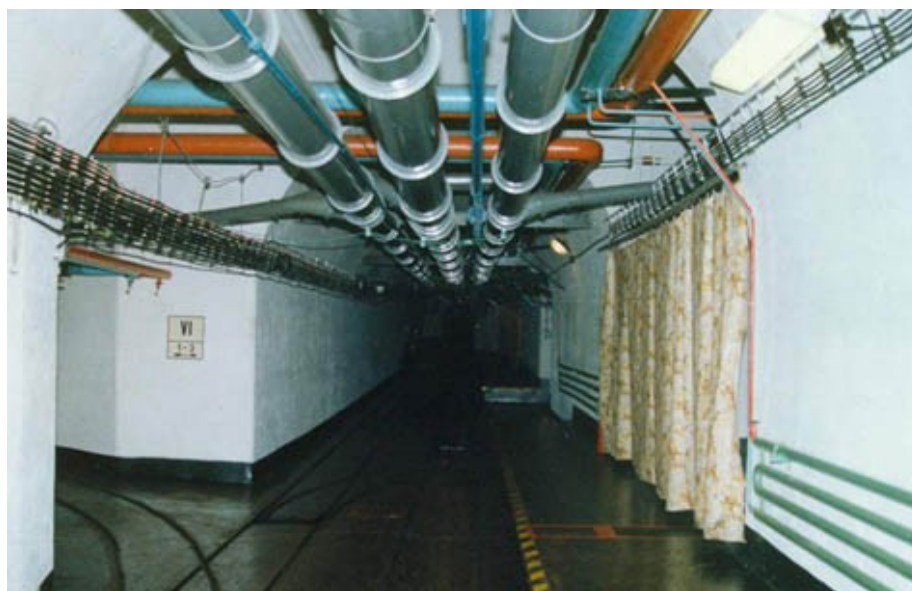
Obr. č.2 : Hlavní spojovací chodby [50]
