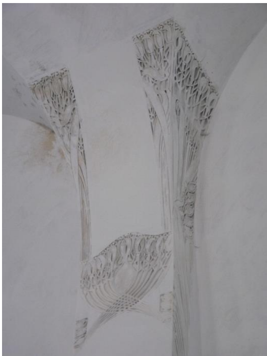
Obr. č. 31 Starokatolický kostel Povýšení sv. Kříže – detail štukové výzdoby pilastru před restaurováním.
