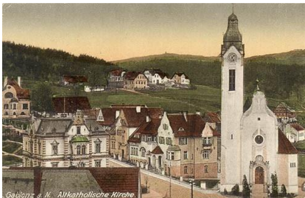
Obr. č. 34 Starokatolický kostel Povýšení sv. Kříže a Scheiblerovy domy – kolorovaná pohlednice.
