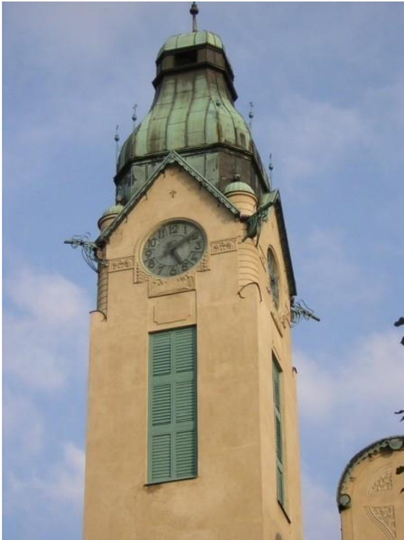
Obr. č. 15 Starokatolický kostel Povýšení sv. Kříže – detail věže.
