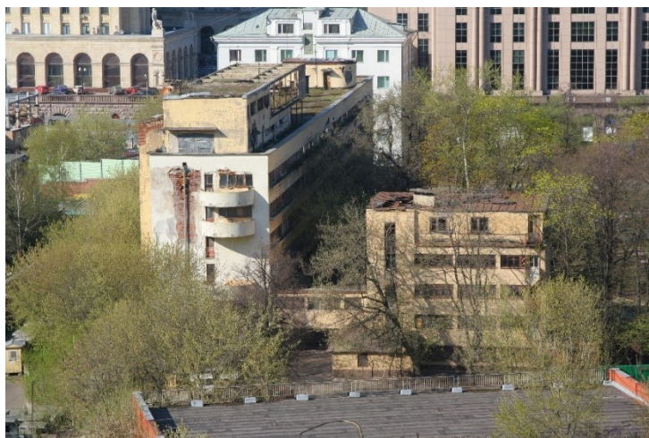
Obrázek č. 28 Budova Narkomfin v roce 2012. Zdroj: https://leidiniu.archfondas.lt/en/alf-02/eanna-bronovitskaya-glimpses-today-visions-russian-avant-garde-architects
