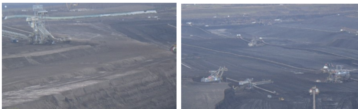
Obr. č. 1, 2: Povrchový velkolom hnědého uhlí Doly Nástup Tušimice; autor fotografie – Bc. Milena Johanová
