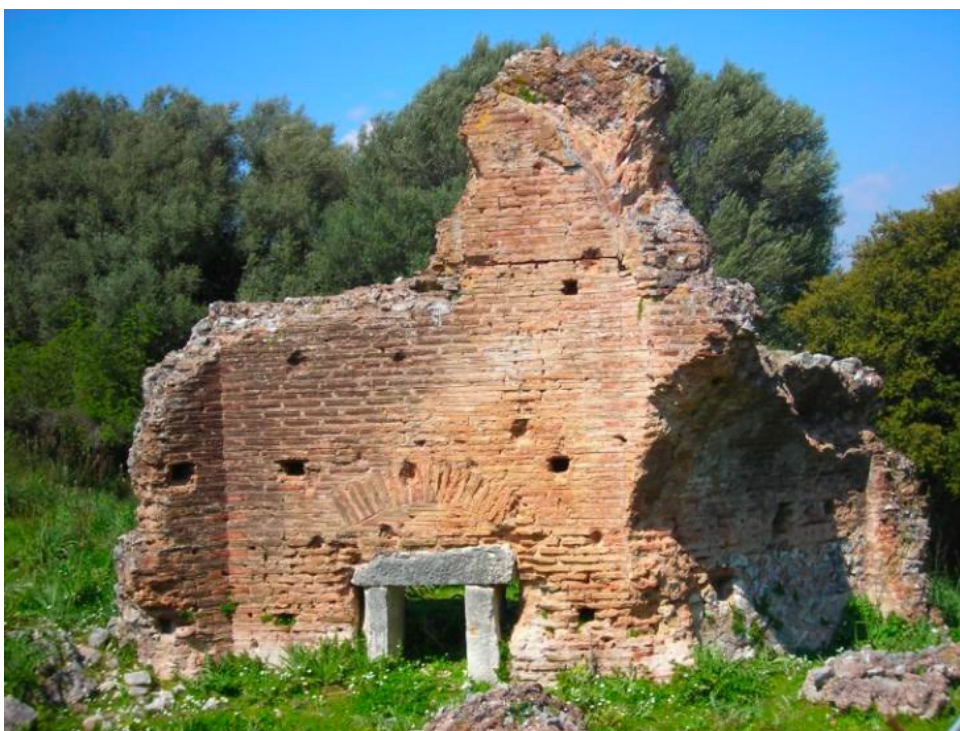
Obrázek 21 – Balneum villy v Strongyli s opus testaceum a klenbovou patkou (Konstantaki 2015, πίνακας 66, δ).
