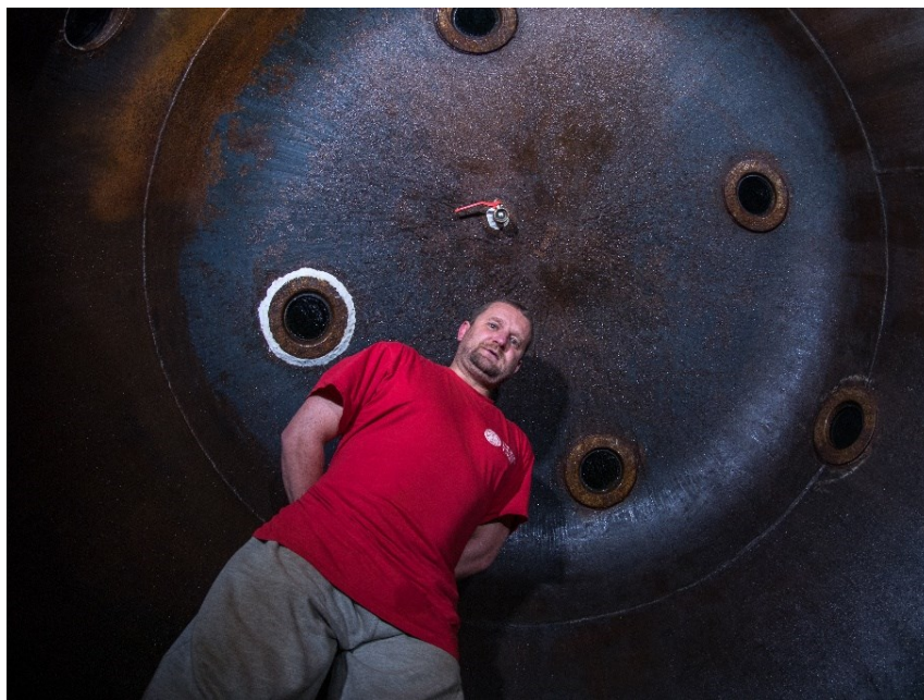
Obr. 5.2.8.1 Na fotografii je vidět vrchní strop kesonu s okénky a sprchou pro zaplavení. Na stěnách je zachycena srážející se vlhkost, která tvoří kapky, které protékají celým kesonem. Zdroj: Archiv Davida Vondráška
