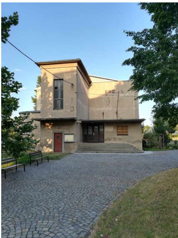
Příloha č. 2: Stav budovy kina v červenci 2019
