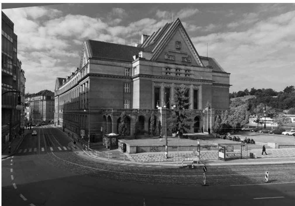
Budova Právnické fakulty UK
