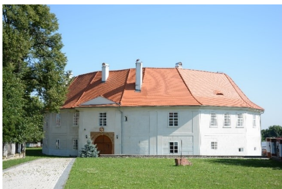
Obr. 26: Zámek Nepomyšl – bývalé správní sídlo Velkostatku (foto autor)
