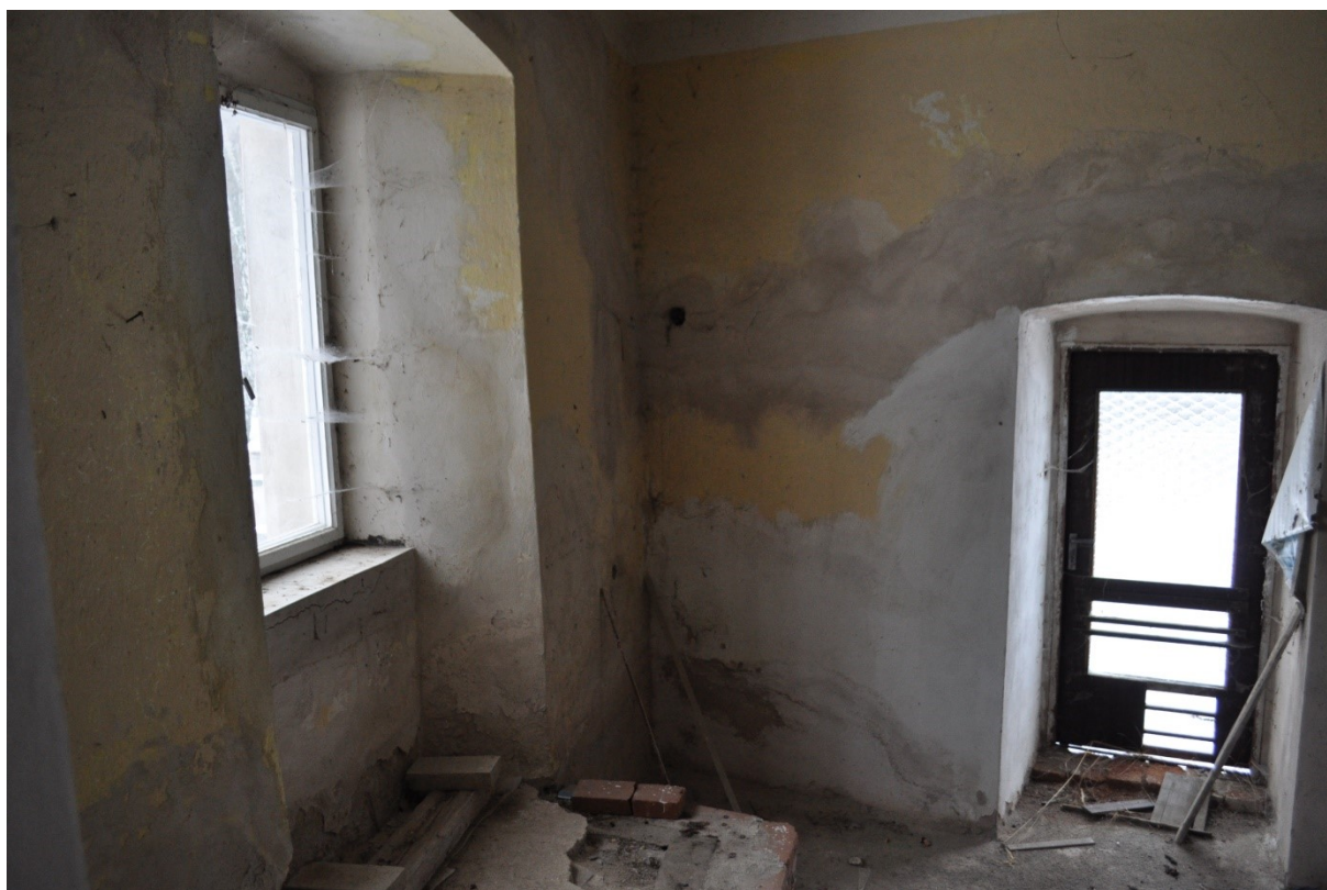
Jižní místnost přízemí domu zahradníka, vchod v jižní zdi
