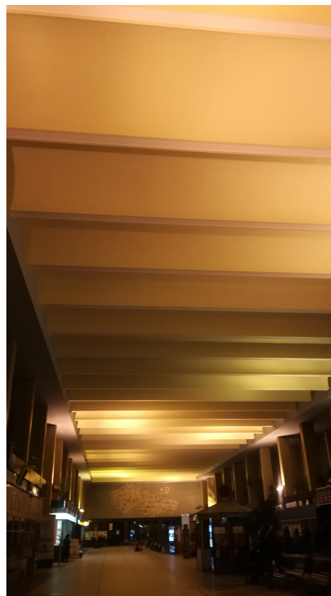
Obr. 10. Nádraží Pardubice. Interiér - Detail - podlhedu. 2019
