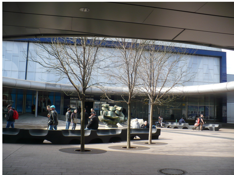
Obr. 59. Ostrava hlavní nádraží. Exteriér s přednádražním prostorem. 2019
