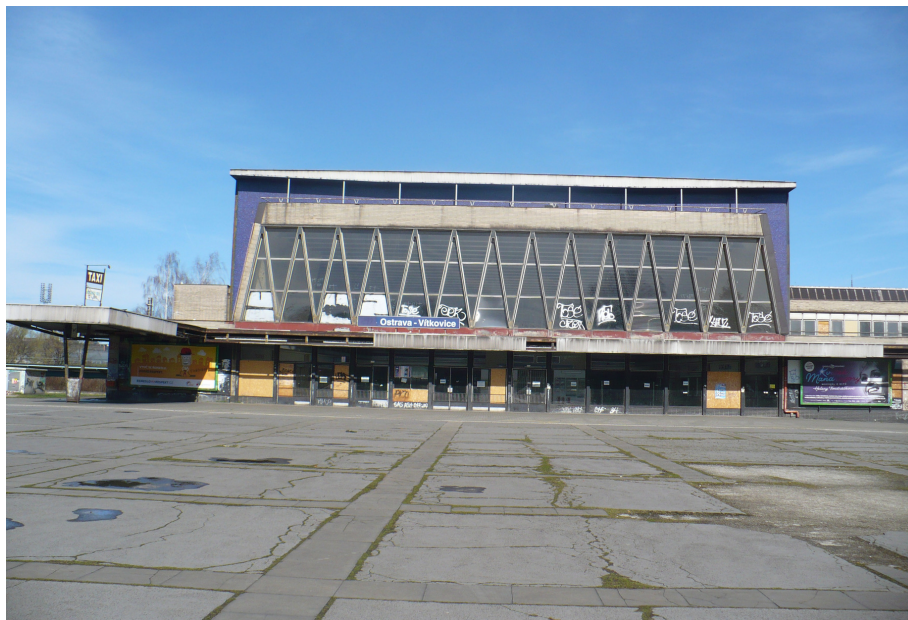
Obr. 33. Nádraží Ostrava Vítkovice. Exteriér nádraží s přednádražní plochou. 2019
