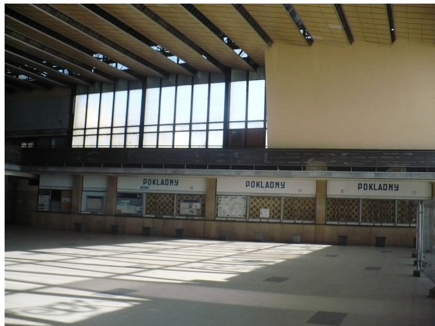
Obr. 37. Nádraží Ostrava - Vítkovice. Interiér haly. 2019
