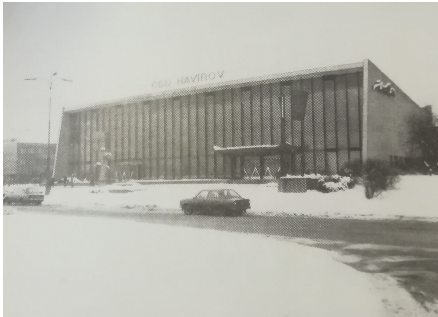
Obr. 42. Nádraží Havířov- exteriér. 70. léta. [Zdroj: DANDA, Josef. Naše Železniční nádraží.]
