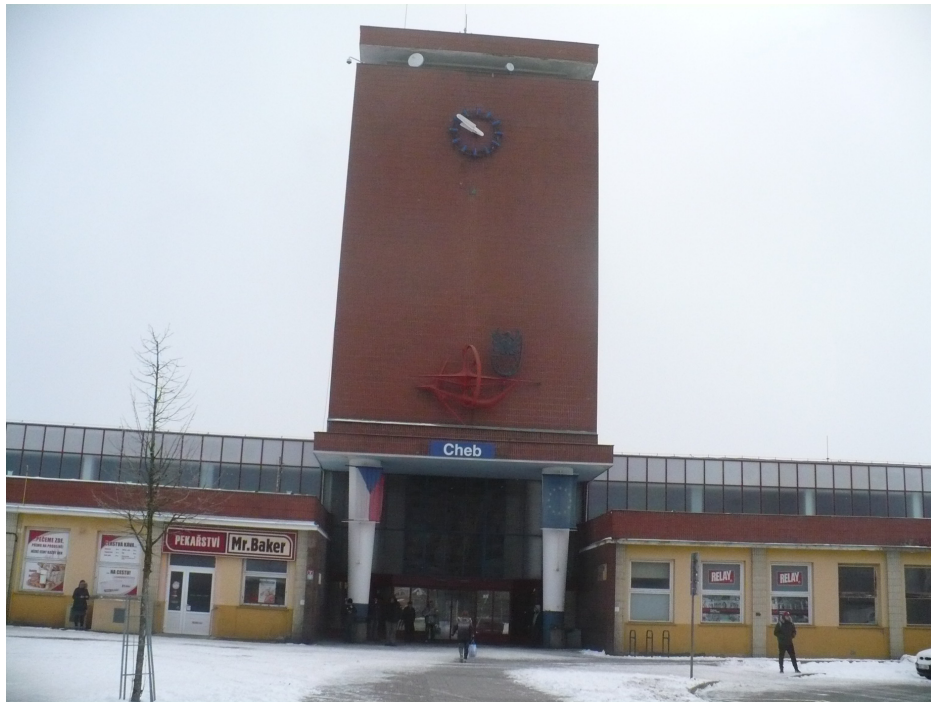
Obr. 19. Nádraží Cheb. Výpravní hala - exteriér. 2019.
