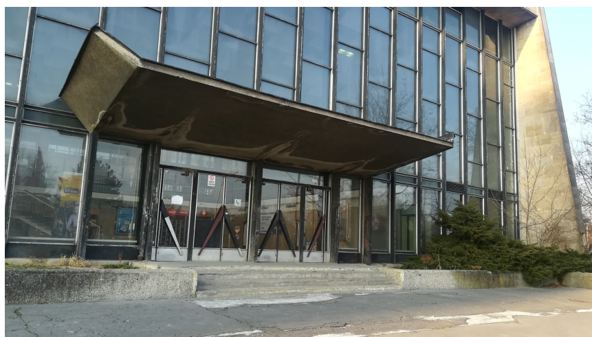
Obr. 45. Nádraží Havířov- exteriér. Detail původního hlavního vchodu. 2018
