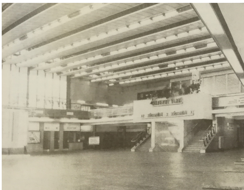
Obr. 31. Výpravní hala - interiér. Exteriér.60.-70. léta. [Zdroj: DANDA, Josef. Naše Železniční nádraží.]
