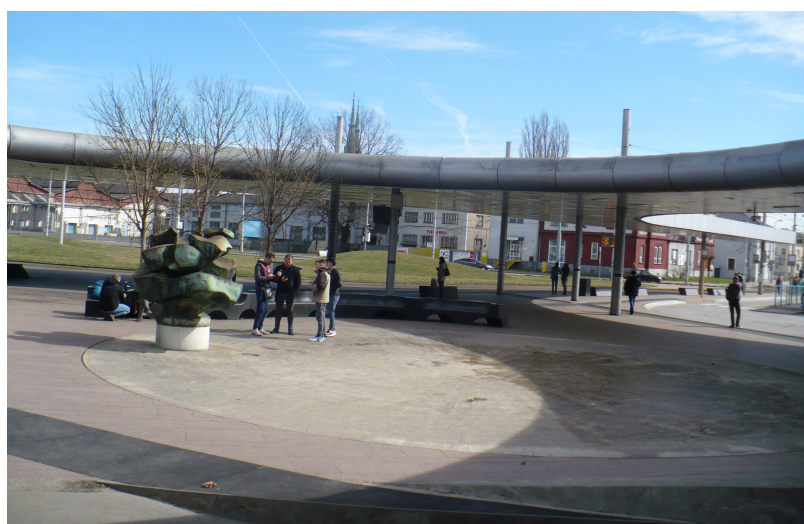
Obr. 60. Ostrava hlavní nádraží. Exteriér s přednádražním prostorem. 2019
