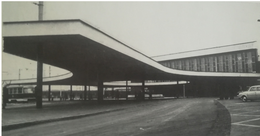
Obr. 56. Ostrava hlavní nádraží. Exteriér - detail kolonády. 70. léta. [Zdroj: DANDA, Josef. Naše Železniční nádraží.]
