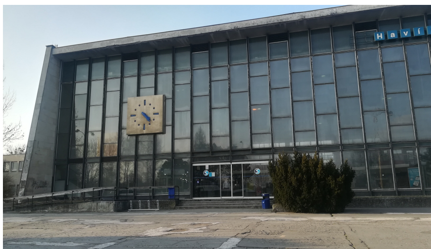
Obr. 43. Nádraží Havířov- exteriér. Detail nově umístěného hlavního vchodu a hodin. 2018
