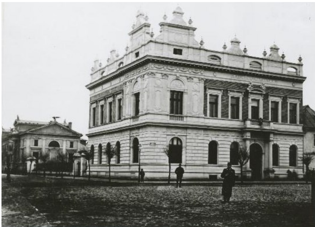
Obr. 19: Budova Občanské záložny při severní části náměstí v Českém Brodě na fotografii z počátku 20. století (v pozadí budova sokolovny)
