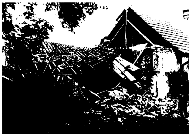
Obr. 60 Zborcená kolna a poškozená zadní stěna domku (Drahorád, 2004)
