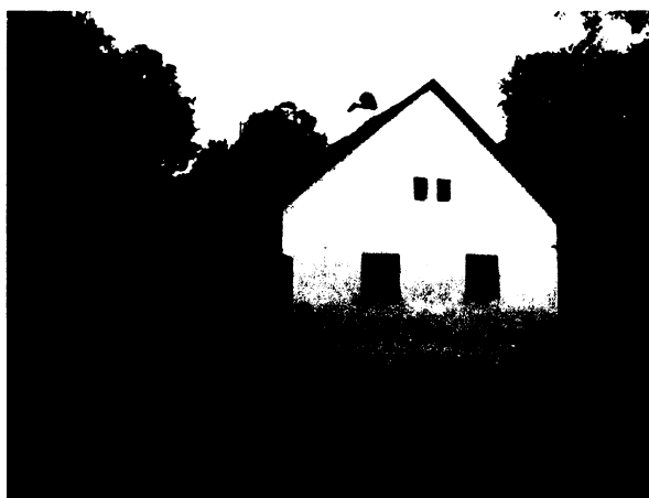
Obr. 74 Chalupa při pohledu od východu – stav po opravě porušené štítové zdi
