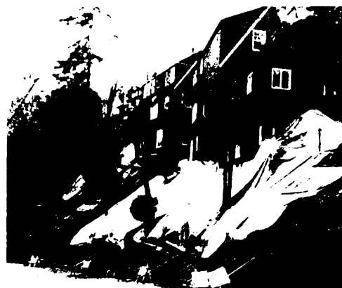
Obr. 6 Igelitové „pláštěnky“ na ochranu domů v sesuvném území v Portlandu (Oregon, USA) před infiltrací srážkové vody (Legget, 1962)
