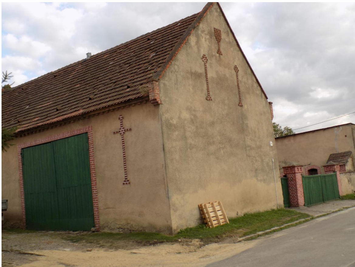
Obrázek 1: Průčelí husineckého statku s průduchy ve tvaru kalichu a kříže.
