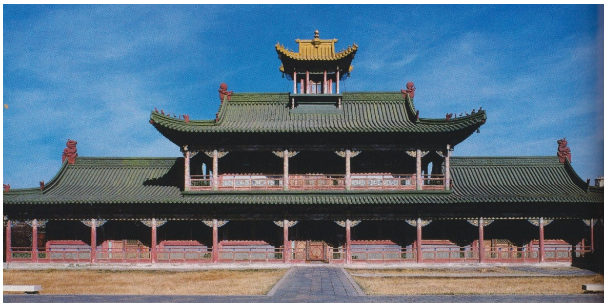
Obr. č. 9: Příklad čínského stavebního slohu. 34
