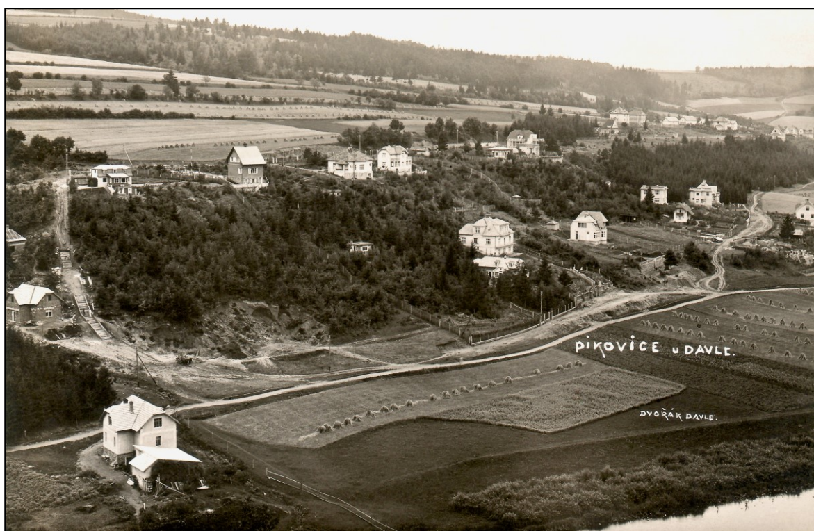
Obrázek 7 Vily v ulicích Na Průhoně a Dolní Průhon r. 1931, vlevo probíhá výstavba schodů pikovickým Okrašlovacím spolkem. Zdroj: Knihovna Hradištko.
