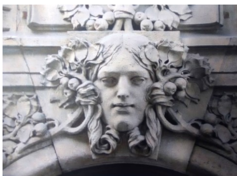
1. Celda Klouček: maskarony, detail fasády Pražské úvěrní banky, ul. 28. října, 1902
