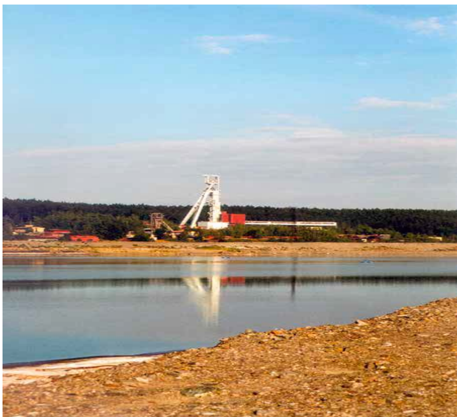
Obr. 5: Pohled na Důl R 2 přes odkaliště (zdroj: DIAMO, s. p.).
