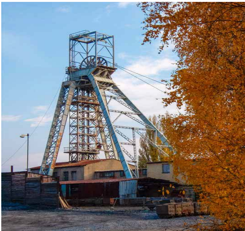
Obr. 4: Těžní věž jámy R 1 (zdroj: DIAMO, s. p.).
