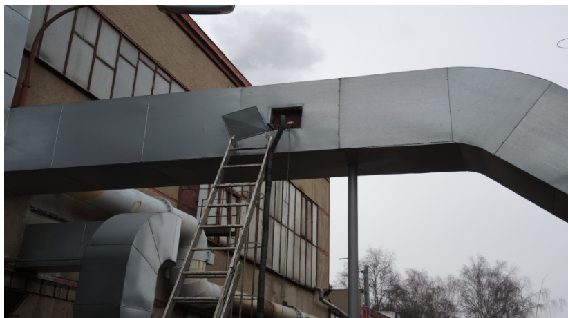
Obr. 23: Měření emisí autorizovanou firmou na vyjmenovaném stacionárním zdroji kotelna ZCHÚ (zdroj: DIAMO, s. p.).
