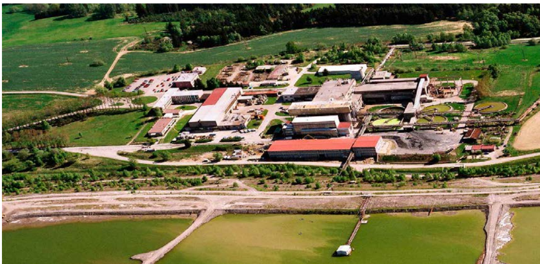
Obr. 8: Letecký pohled na výrobní část ZCHÚ, v popředí plovoucí čerpací stanice na odkališti K 1 (zdroj: DIAMO, s. p.).
