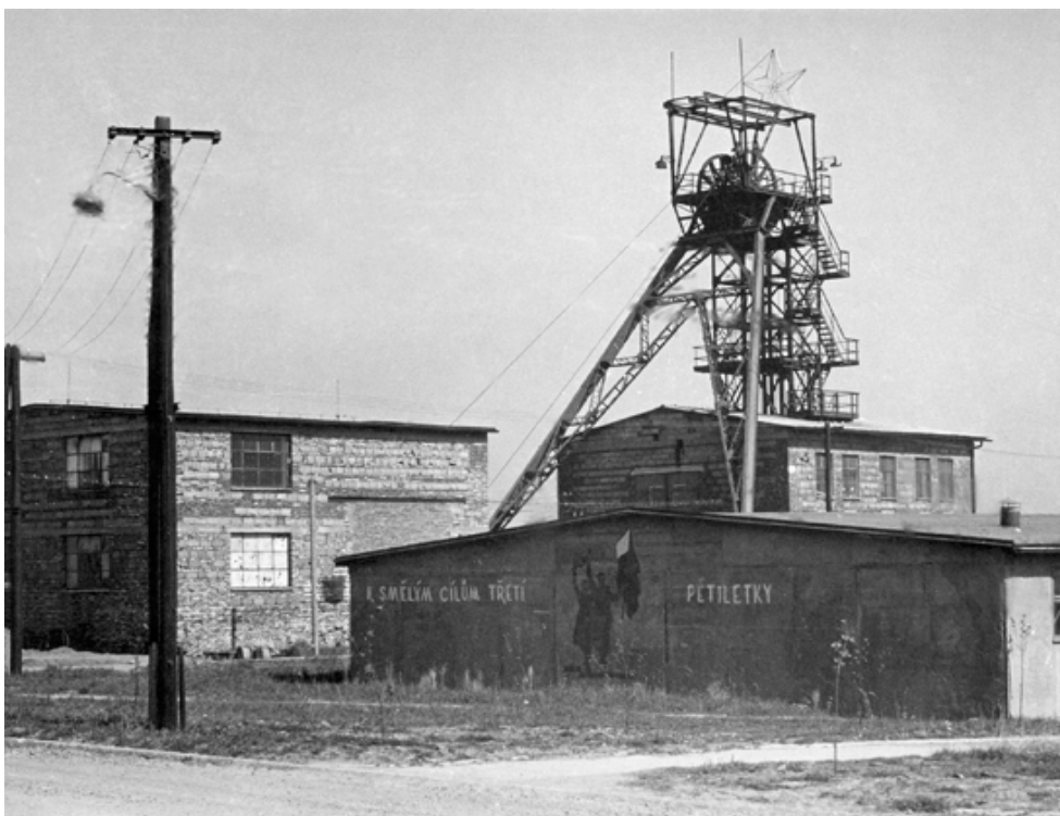
Obr. 3: jáma R1 - Dne 27. 10. 1957 zahájil tehdejší závod KHB v Chotěboři hloubení jámy R 1, čímž byla zahájena těžební činnost v oblasti Dolní Rožínky (zdroj: archiv DIAMO).
