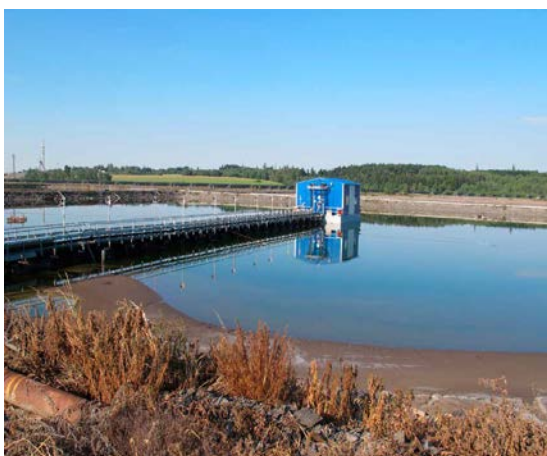
Obr. 13: Plovoucí čerpací stanice na odkališti K 1
