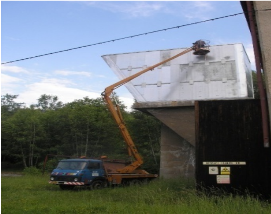
Obr. 22: větrací stanice R 6 (zdroj: DIAMO, s. p.).
