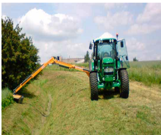
Obr. 12: Údržba obtokových příkopů
